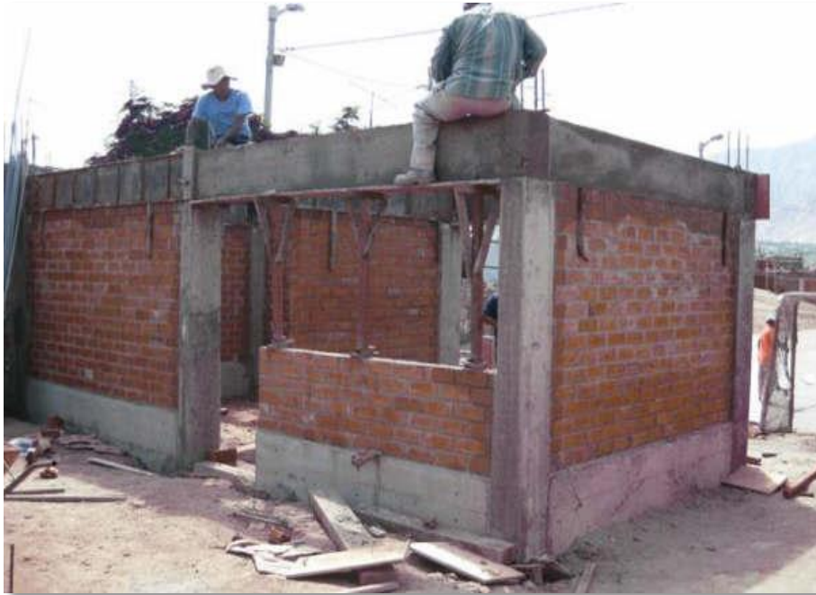
Figura 5: Proceso constructivo mediante la albañilería confinada.
