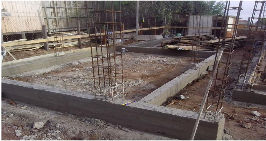
Figura 8: Sobrecimiento de Concreto Simple.
