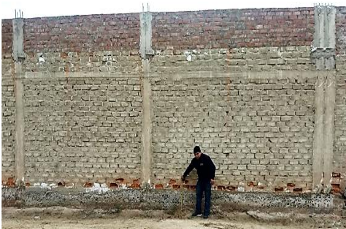
Fotografía 13: Medición del área del muro de albañilería, sobrecimiento y columnas de confinamiento afectados por la erosión en la Unidad Muestral 22.
