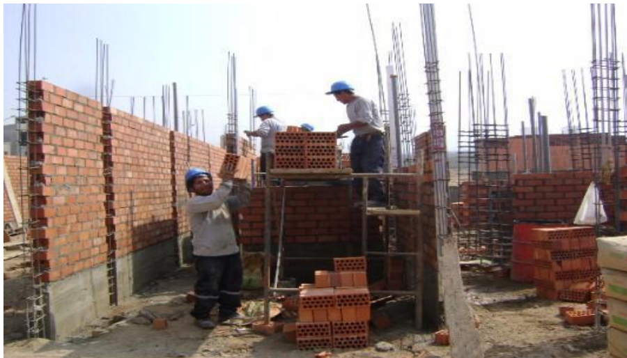
Figura 12: Muro de arriostre de Albañilería Confinada.
