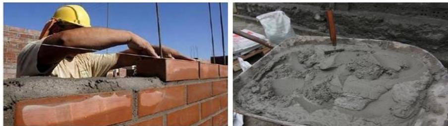
Figura 16: Aparejo de ladrillo con mortero.
