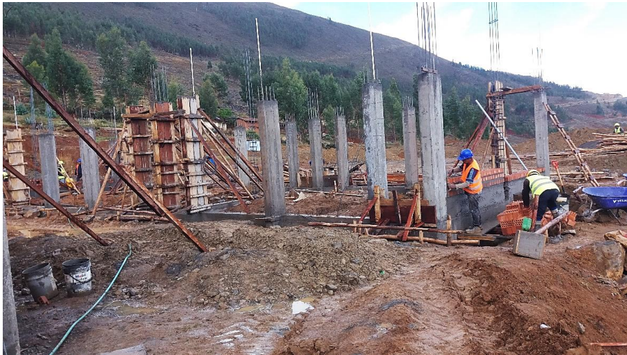
Figura 9: Columnas de Concreto Armado.
