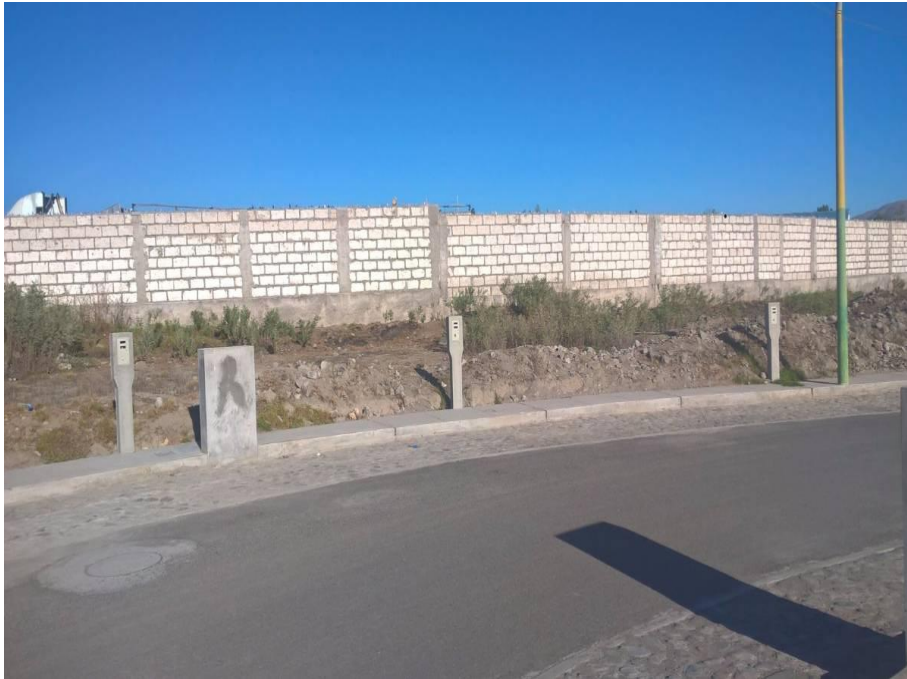
Figura 13: Muro no portante de Albañilería.
