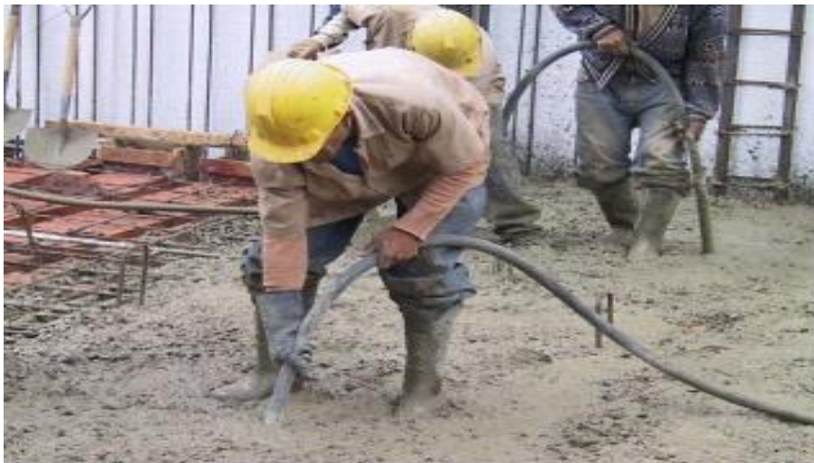
Figura 19: Vaciado de concreto para techo aligerado.
