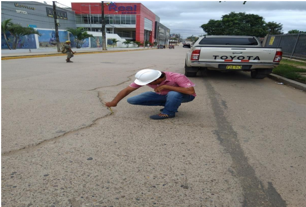
FOTO 1: FALLAS PATOLÓGICAS EN LA PAVIMENTACIÓN EL JIRÓN ALFREDO EGLINTON
