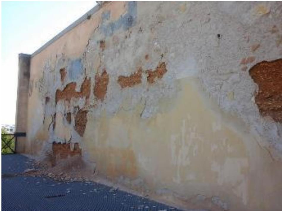
**Figura 08. Imagen de Desprendimiento en muro – Fuente: Broto<sup>29</sup>**
