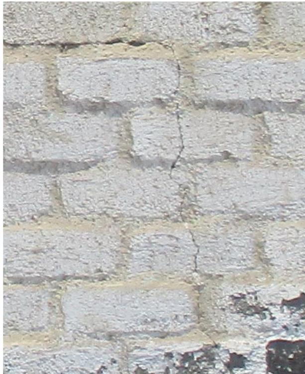
**Figura 278: foto de tipo de Daño: Grieta**
