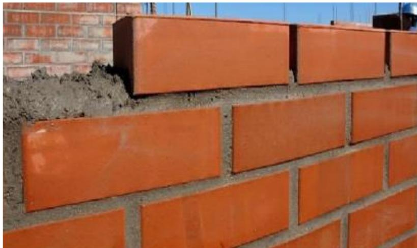
**Figura 05:** Unidades de Albañilería asentado on mortero – Fuente:
