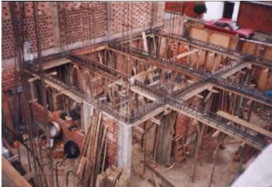
**Figura 03.** Construcción de Viga de concreto armado – Fuente: San Bartolomé A.
