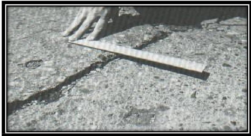
Figura N°15. (Media Severidad)-Escala.
