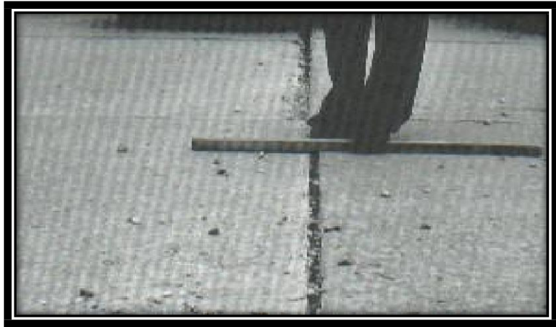
Figura N°14. (Baja Severidad)-Escala
