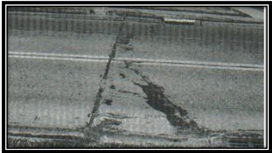
Figura N°37. (Media Severidad)-Punzonamiento.
