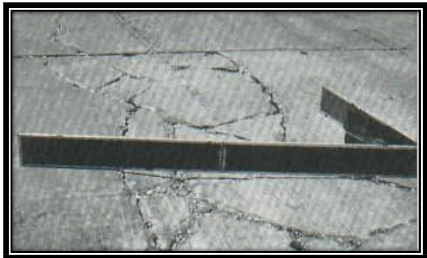
Figura N°38. (Alta Severidad)-Punzonamiento.
