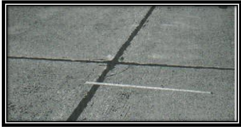
Figura N°43. (Baja Severidad)-Descaramiento de Esquina.
