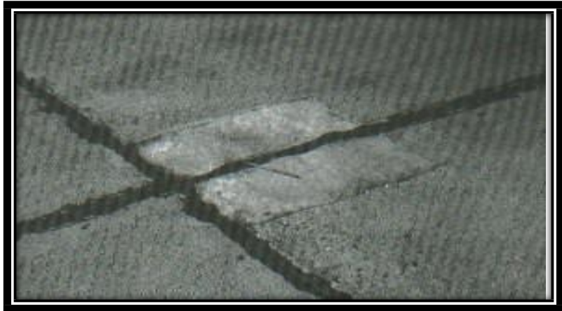
Figura N°29. (Baja Severidad)-Parche Pequeño.
