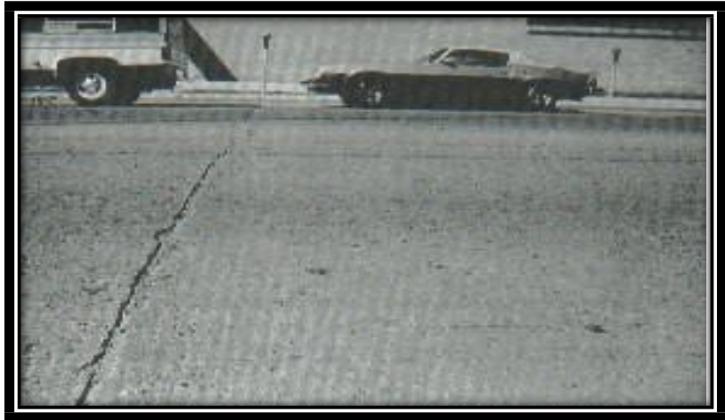
Figura N°46. (Baja Severidad)-Descascaramiento de Junta.
