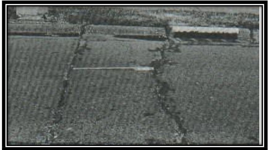
Figura N°36. (Baja Severidad)-Punzonamiento.
