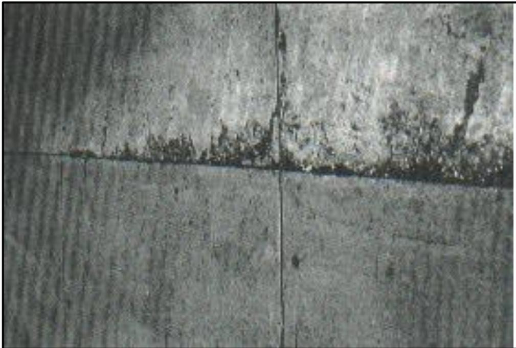
*Figura 55: Descascaramiento de junta de severidad media.*
