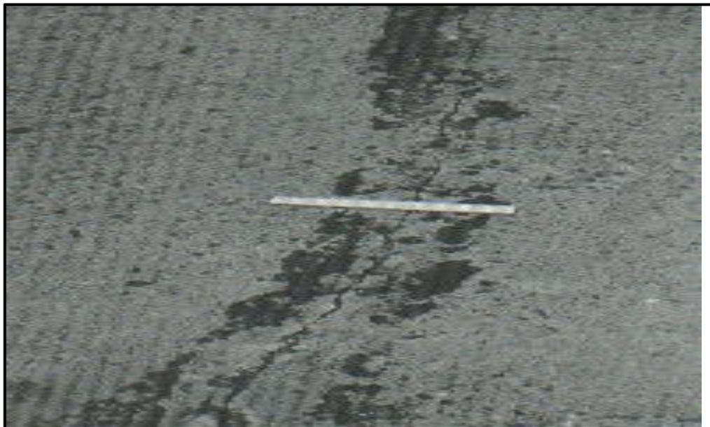
*Figura 29: Grietas lineales de baja severidad en losa de concreto simple.*
