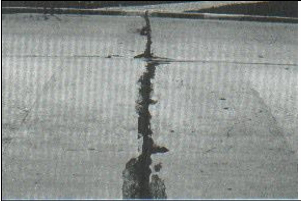
*Figura 23: Daño del sello de junta de severidad baja*
