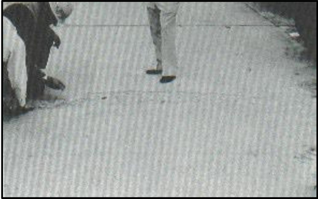
*Figura 19: Grieta de durabilidad de severidad alta*
