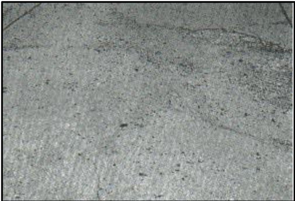
*Figura 18: Grieta de durabilidad de severidad media.*
