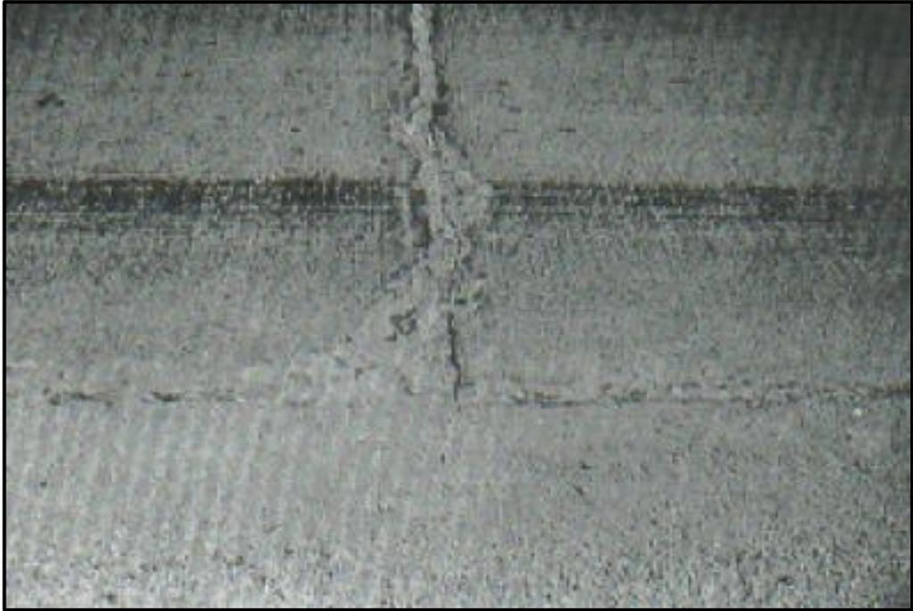
*Figura 52: Descascaramiento de esquina de severidad media.*
