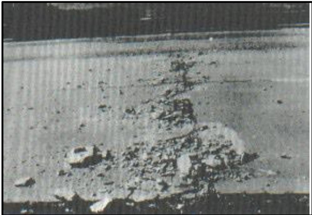
*Figura 8: Blowup / Buckling severidad. severidad baja*
