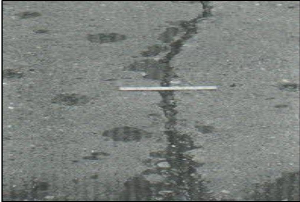
*Figura 30: Grietas lineales de severidad media en losa de concreto reforzado.*
