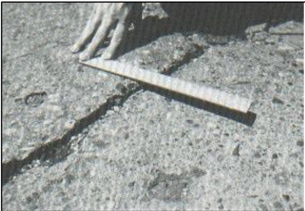
*Figura 21: Escala de severidad media*
