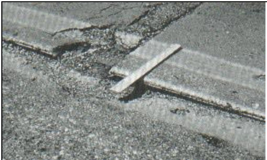
*Figura 26: Desnivel carril / berma de baja severidad.*
