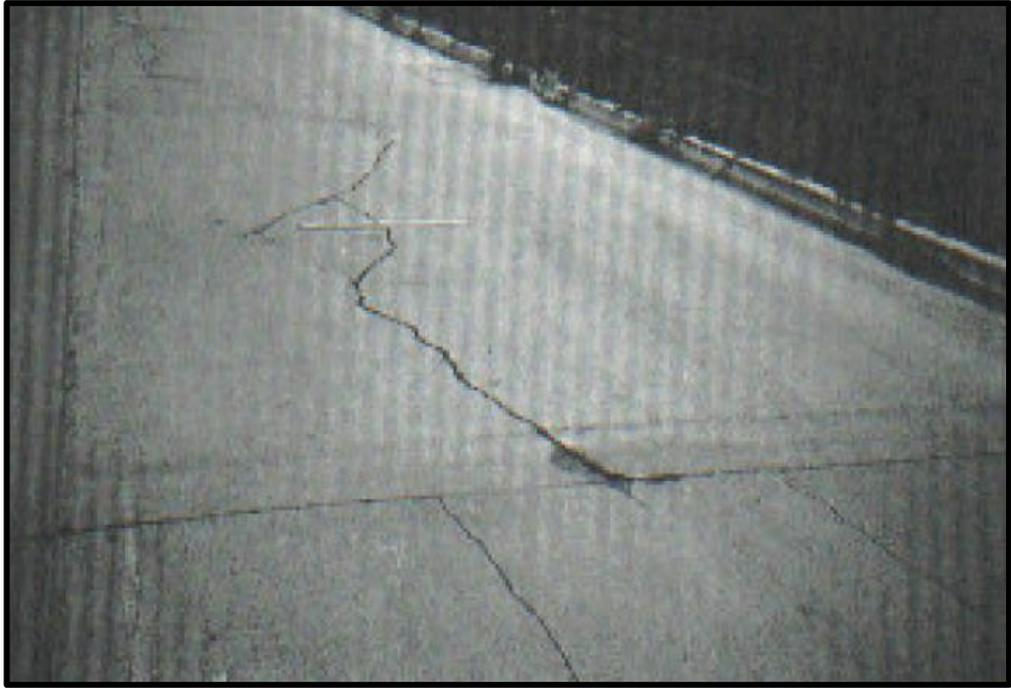
*Figura 15: Losa dividida de severidad media.*
