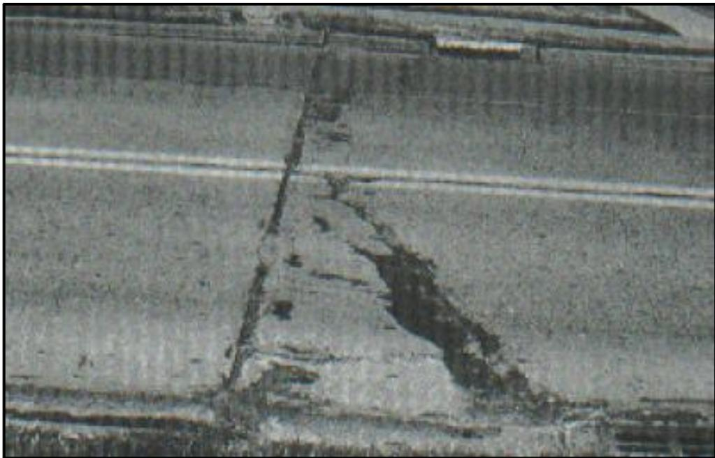
*Figura 43: Punzonamiento de alta severidad.*
