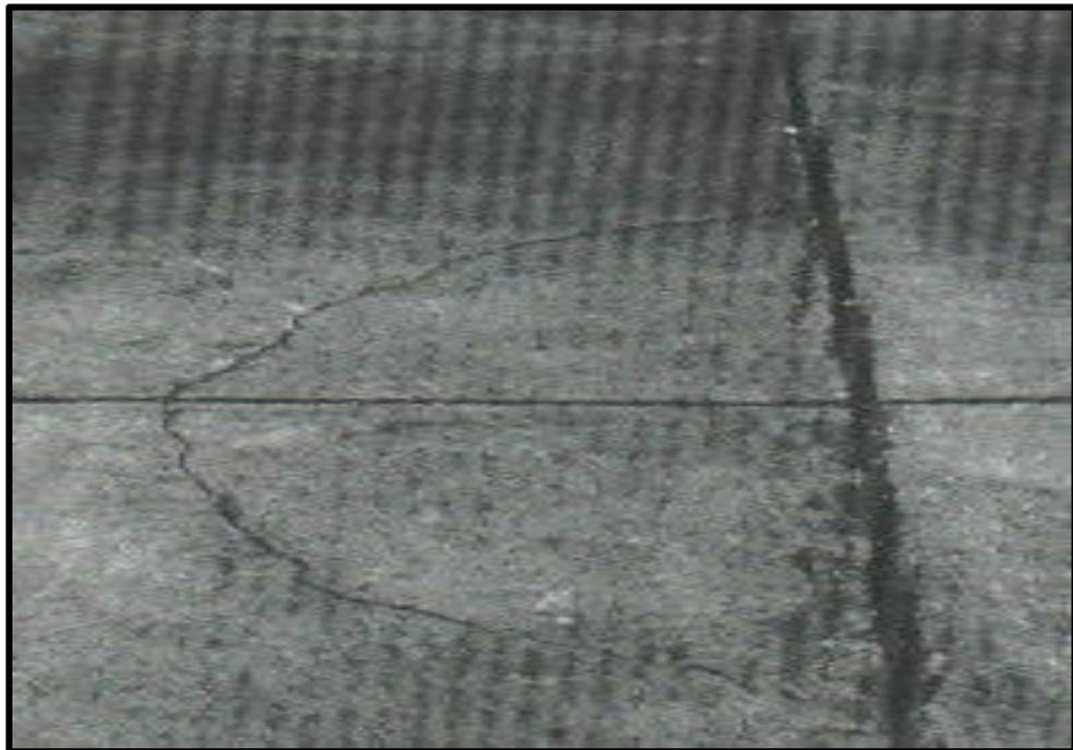
*Figura 11: Grieta de esquina de severidad baja*
