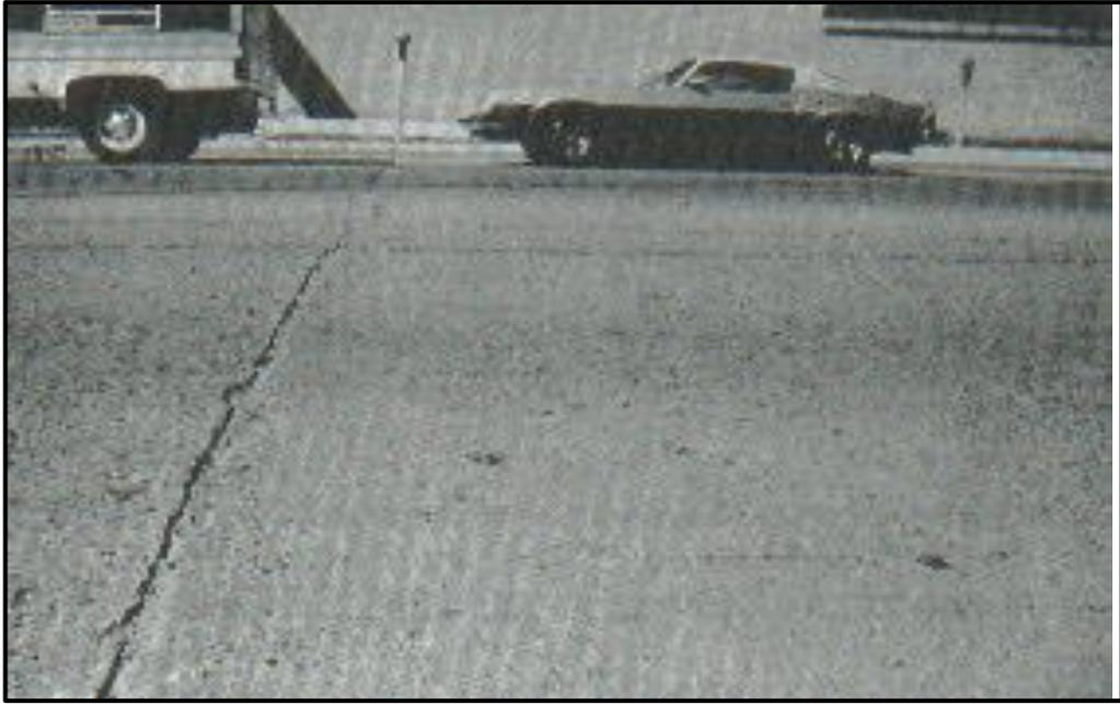
*Figura 54: Descascaramiento de junta de baja severidad.*
