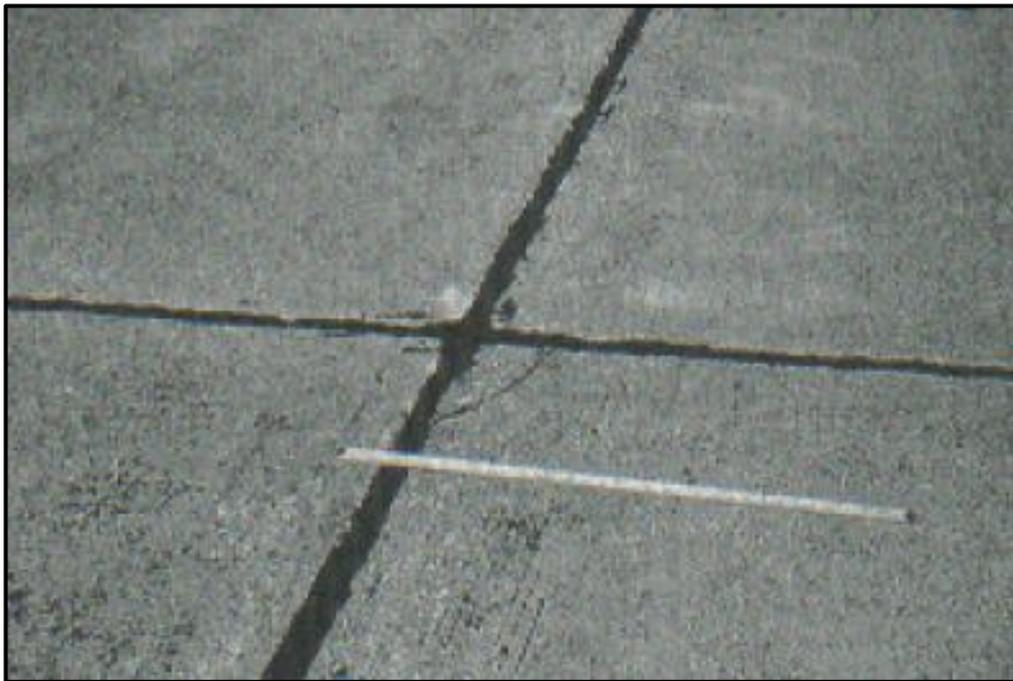
*Figura 51: Descascaramiento de esquina de severidad baja*
