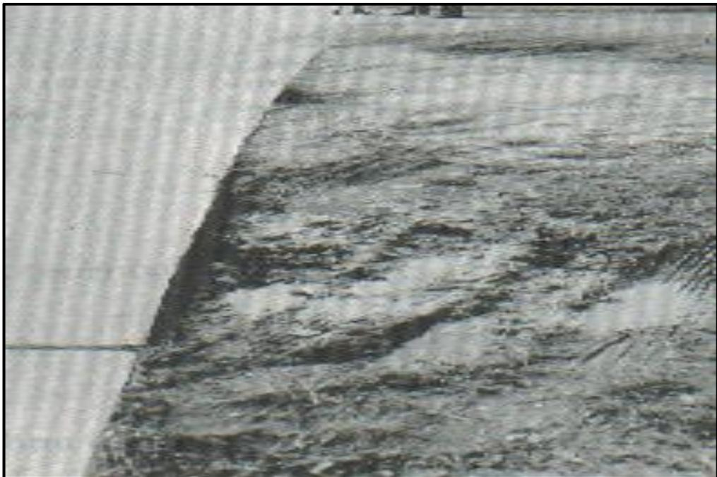
*Figura 28: Desnivel carril / berma de severidad alta.*
