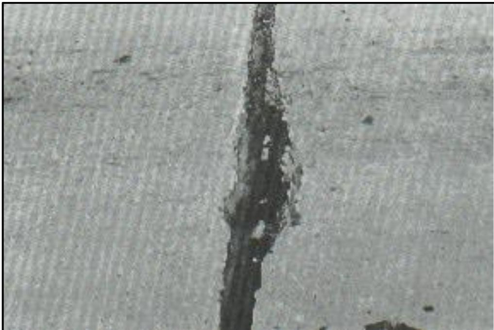
*Figura 24: Daño del sello de junta de severidad media.*
