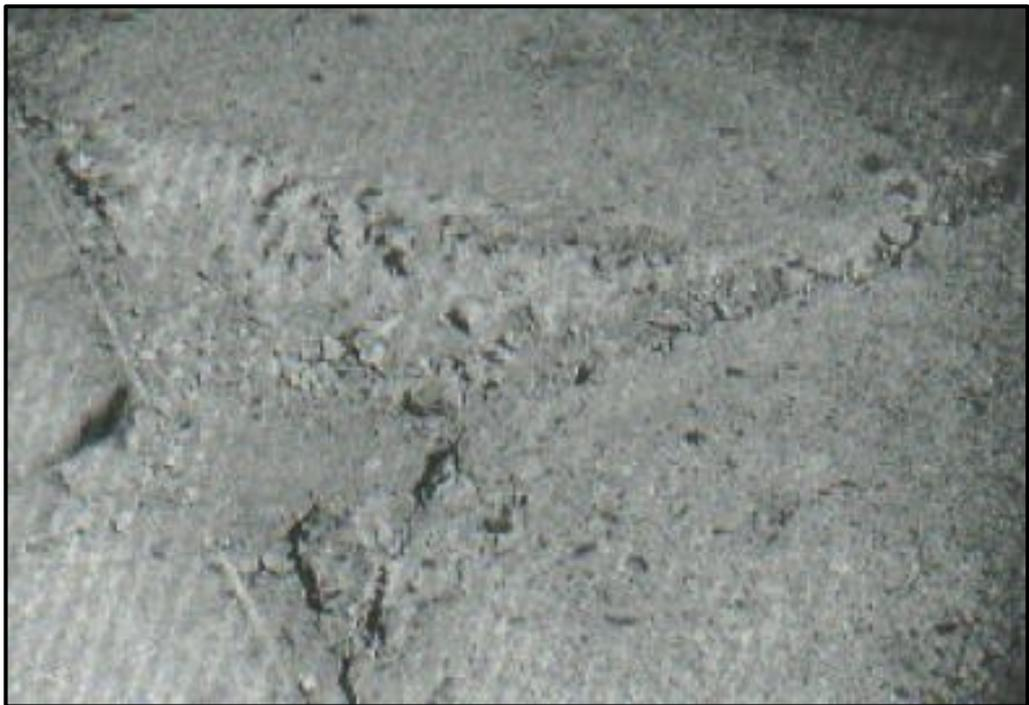
*Figura 53: Descascaramiento de esquina de severidad alta*
