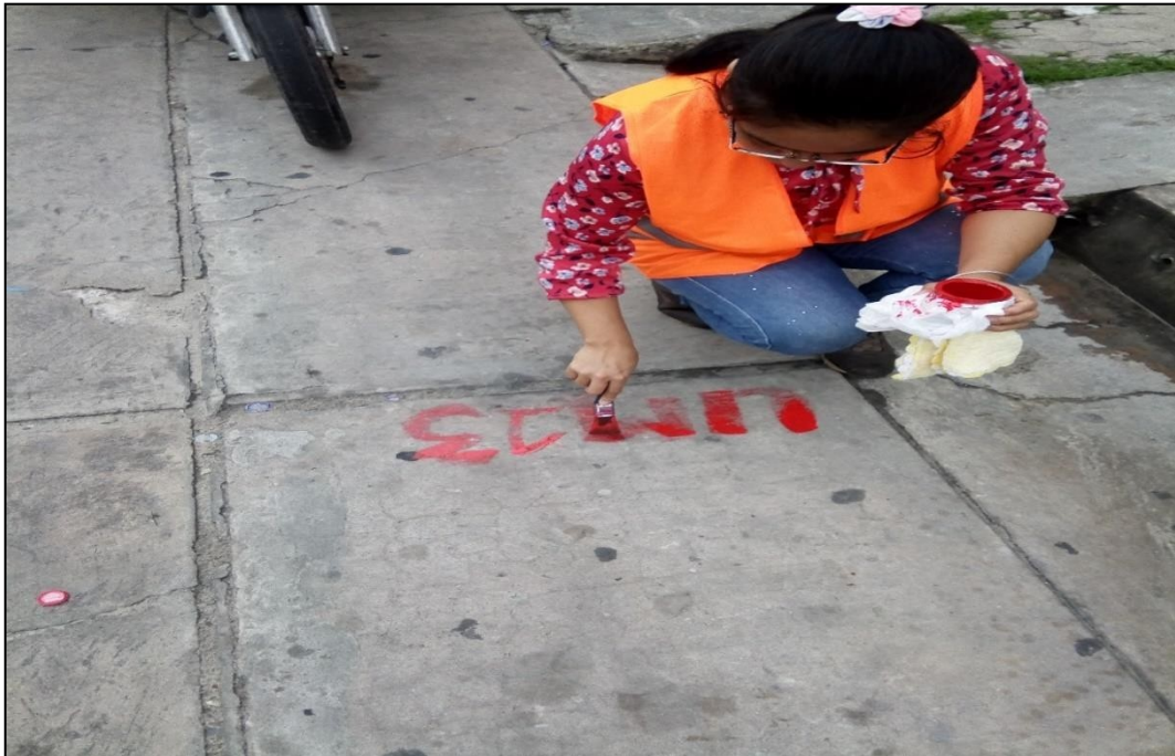
Fotografía 23: Unidad de muestra 13, se nota el parche de severidad media. Originado por la instalación de los servicios públicos.
