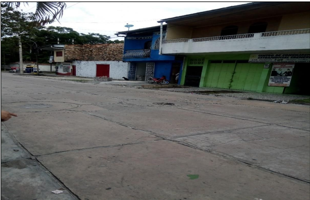
Fotografía 28: Se verifica el parche por el acople de las instalaciones sanitarias. UM - 16
