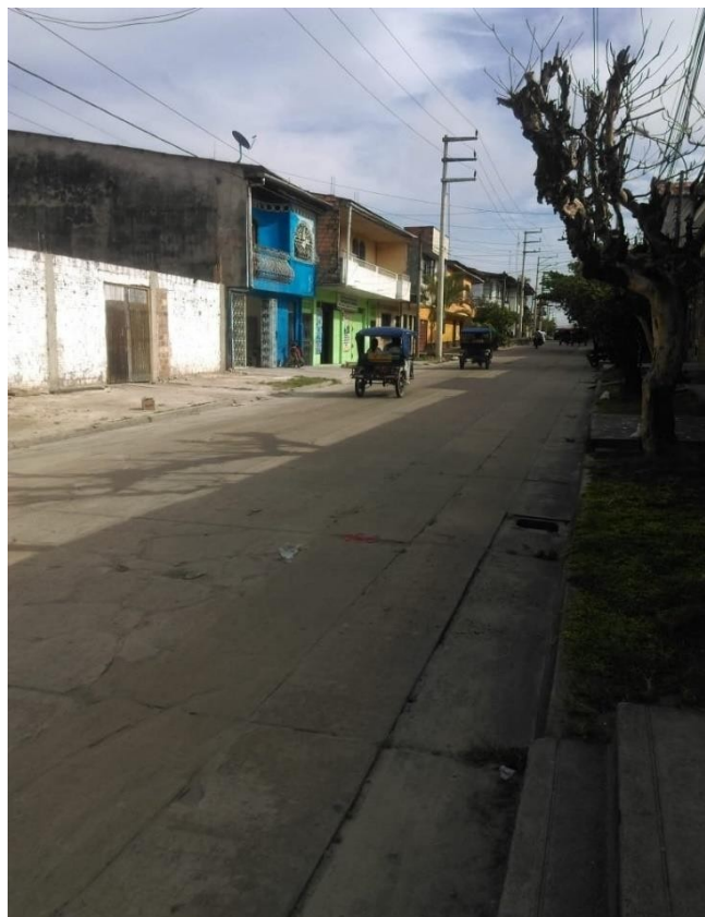
Fotografía 7: Panorama de la calle UM – 03, se nota la cantidad de losa dividiva, los parches grandes
