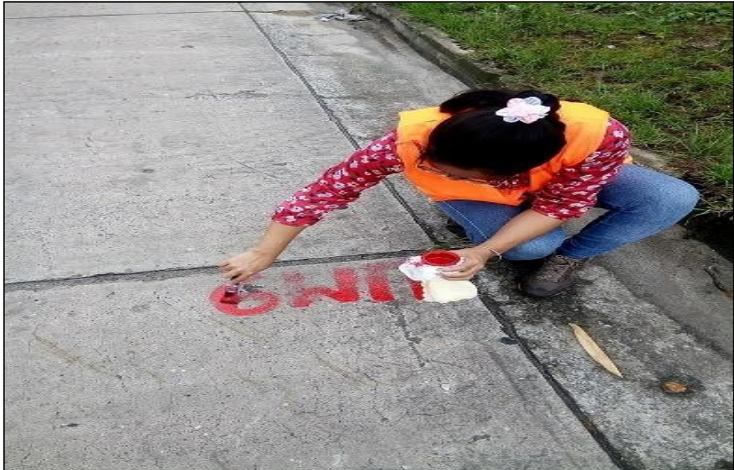
Fotografía 18: Unidad de muestra 9, se nota el desconchamiento de severidad baja. Originado por el deficiente fraguado del pavimento.
