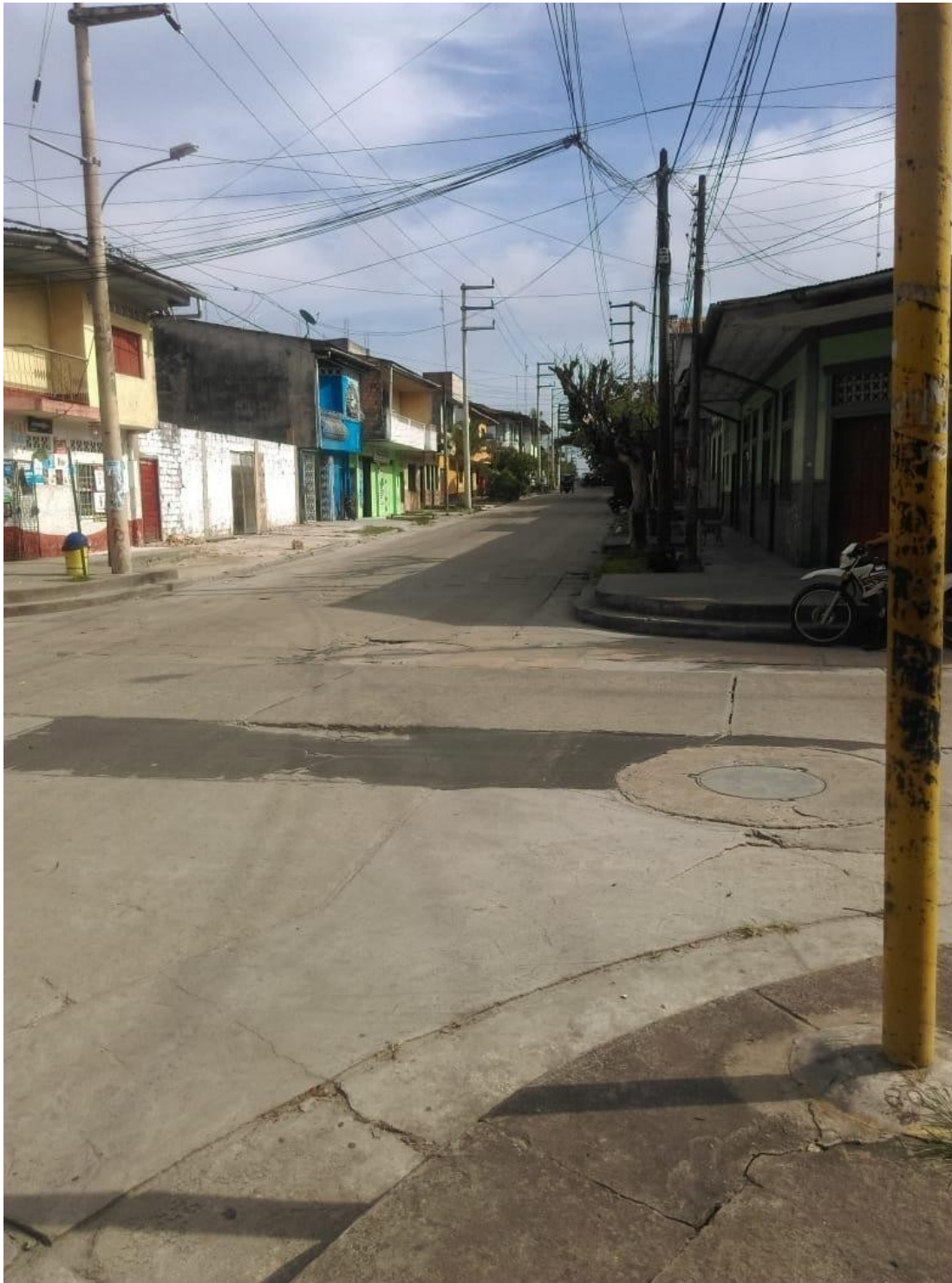
Fotografía 1: panorama de la calle Callao intersección con la calle Napo, se nota distintas fallas.
