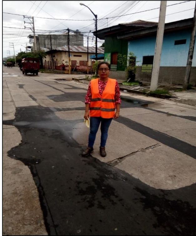
Fotografía 3: UM 1Parche Grande de severidad media Originado por las instalaciones sanitarias públicas.
