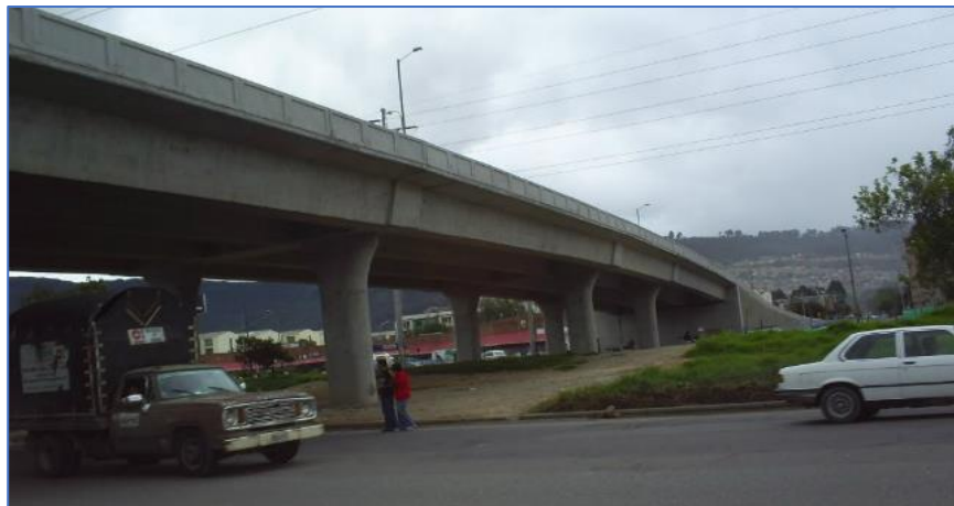
Imagen 1: Puentes Bogotá – Colombia
