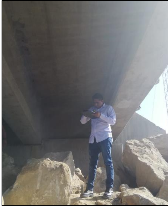
Imagen 34: Inspección y Toma de Datos
