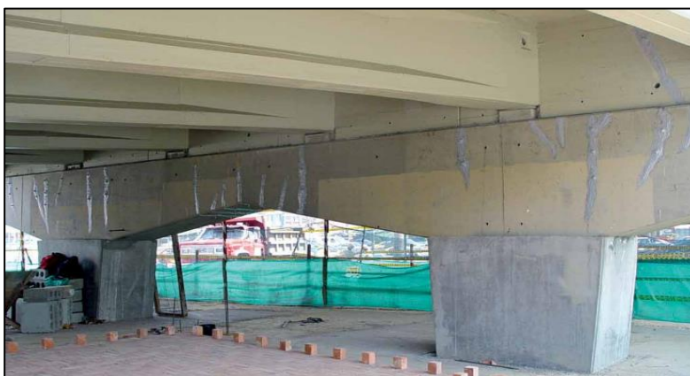
Imagen 18: Reparación de Fisuras.
