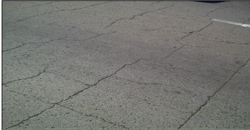
Imagen 19: Retracción Plástica - Losa.
