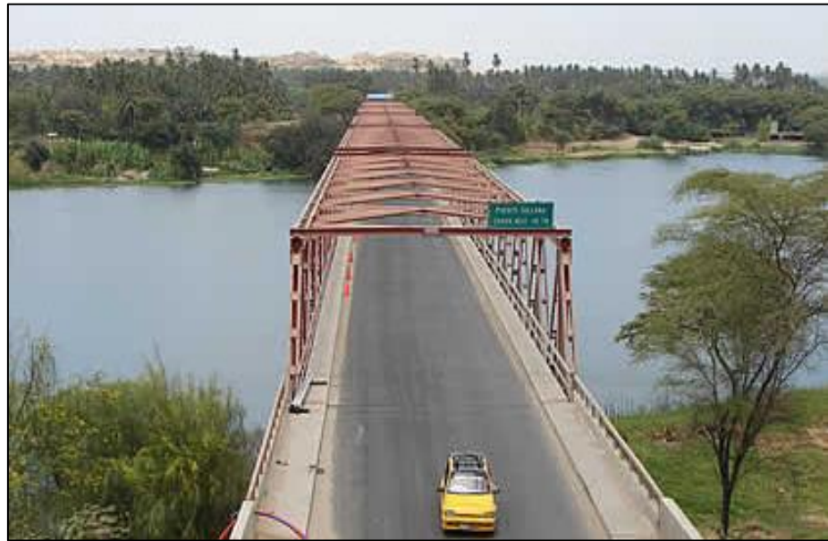
Imagen 2: Puente Sullana – Marcavelica
