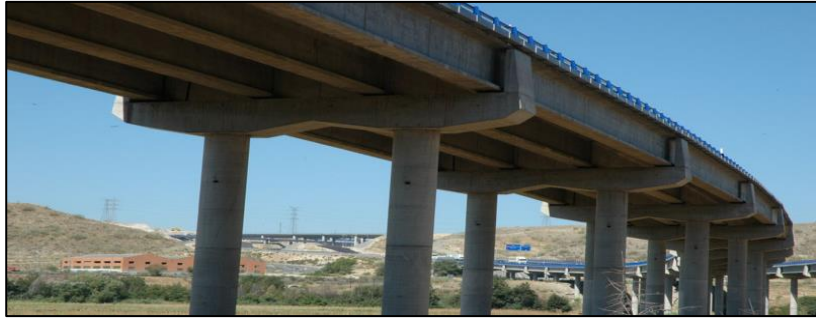
Imagen 6: Vigas Principales – puentes
