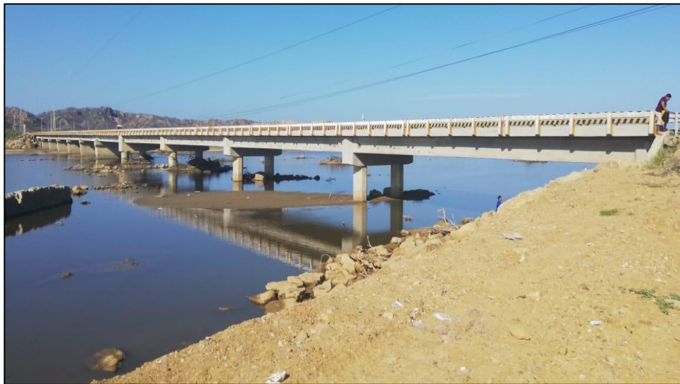
Imagen 33: Toma General del Puente Bocapán.
