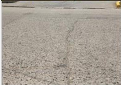
Figura N° 151: V.D. de Grietas Lineales, UM 03 –MZ P
