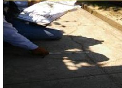
**Figura N° 88:** V.D. de Grietas Lineales, UM 02 – MZ H
