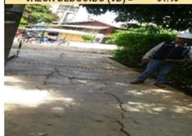
**Figura N° 70:** V.D. Losa dividida, UM 01 – MZ F
