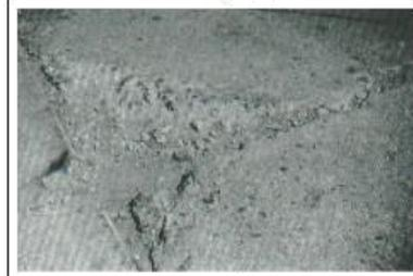
**Figura N° 206:** V.D. de Descascaramiento de Esquina, UM 04 –MZ Z
