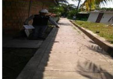
**Figura N° 136:** V.D. De Grietas Lineales, UM 03 –MZ N
