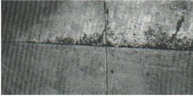
**Figura N° 28:** Descascaramiento de Junta
