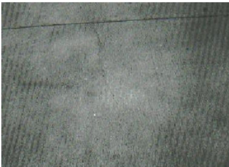
**Figura N° 26:** Grietas de retracción
