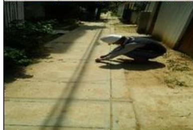
**Figura N° 120:** V.D. de Grietas Lineales, UM 02 –MZ L
