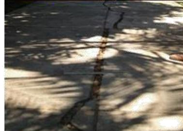
**Figura N° 80:** V.D. de grietas lineales, UM 02 – MZ G
