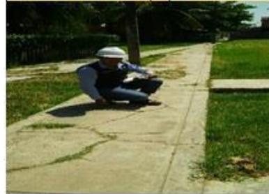
Figura N° 101: V.D.de losa dividida, UM 02 – MZ J
