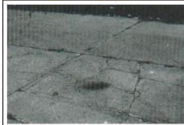
**Figura N° 178:** V.D. de Losa Dividida, UM 04 –MZ T
