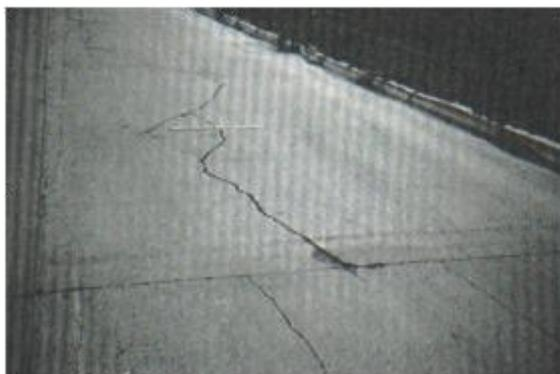
**Figura N° 12:** Losa Dividida
