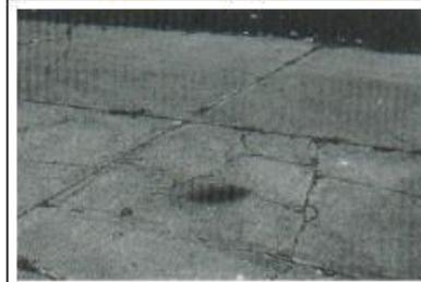
**Figura N° 195:** V.D. de Losa Dividida, UM 04 –MZ V
