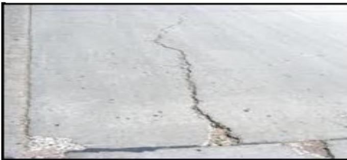
**Figura N° 9:** Gráfico de falla superficial de pavimento rígido
