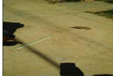
**Figura N° 89:** V.D. de Pulimento de Agregados, UM 02 – MZ H
