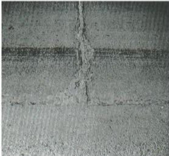
**Figura N° 27:** Descascaramiento de Esquina
