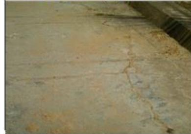
**Figura N° 125** V.D. de losa dividida, UM 03 –MZ M
