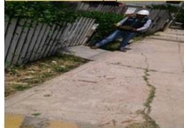
**Figura N° 73:** V.D. Grietas Lineales, UM 01 – MZ F
