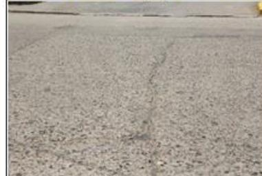
Figura N° 168: V.D. de Grietas Lineales, UM 03 –MZ R
