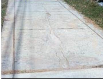
**Figura N° 33** V.D.de grietas lineales, UM 01- MZ A
