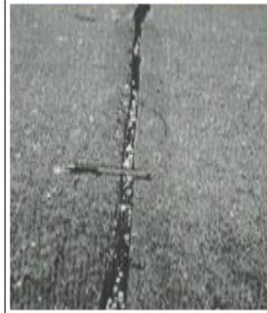
**Figura N° 197:** V.D. de Daño del Sello de Junta, UM 04 –MZ V
