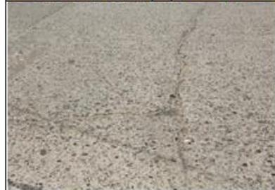
**Figura N° 153:** V.D. de Pulimento de Agregado, UM 03 –MZ P
