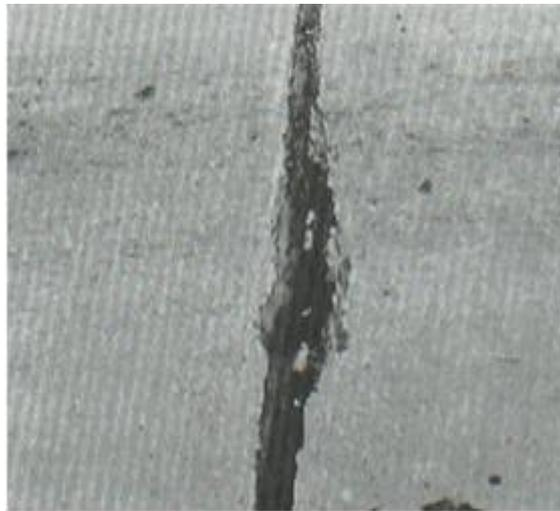
**Figura N° 15:** Daño del Sello de Junta
