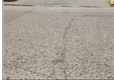
**Figura N°:198:** V.D. de Daño de Grietas Lineales, UM 04 –MZ V
