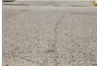
**Figura N° 203:** V.D. de Grietas Lineales, UM 04 –MZ Z
