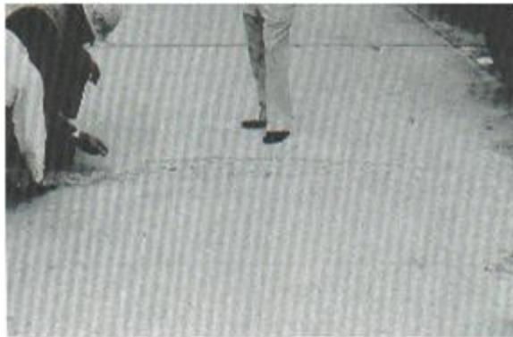
**Figura N° 13:** Grieta de Durabilidad “D”
