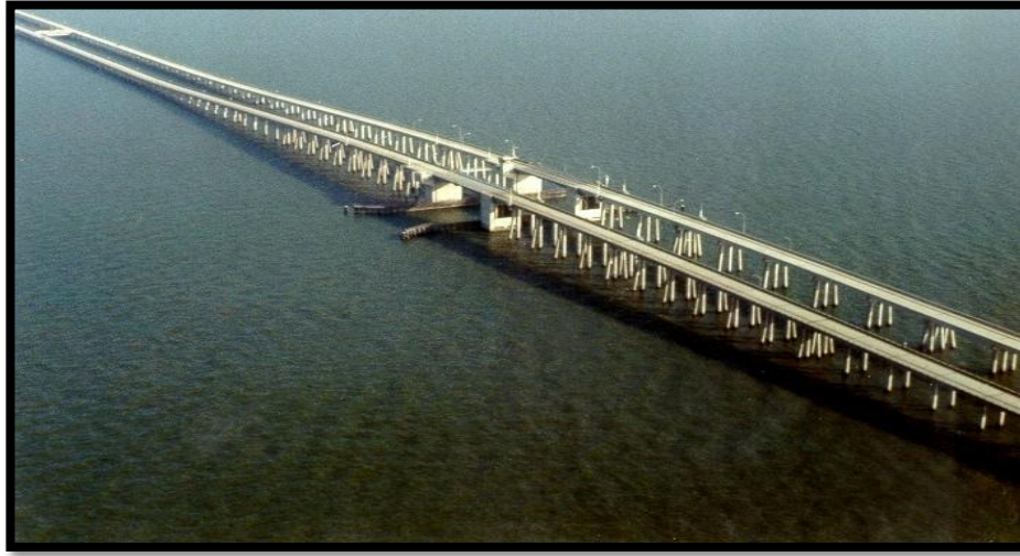
Figura 32.- puente viga.
