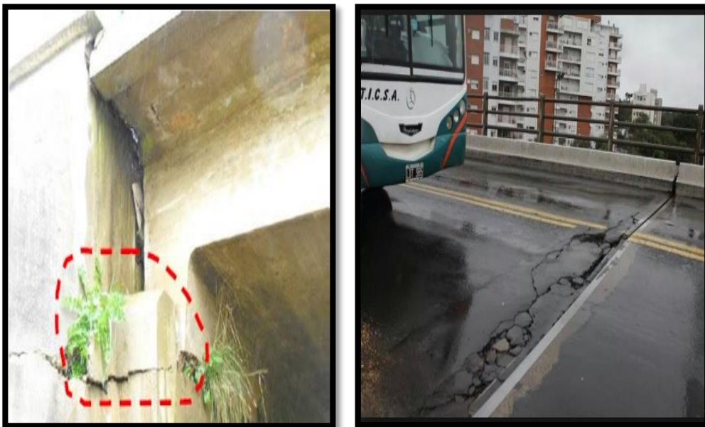
Figura 58. –fisuras en el estribo del puente (imagen derecha), grietas en la plataforma del puente (imagen izquierda).
