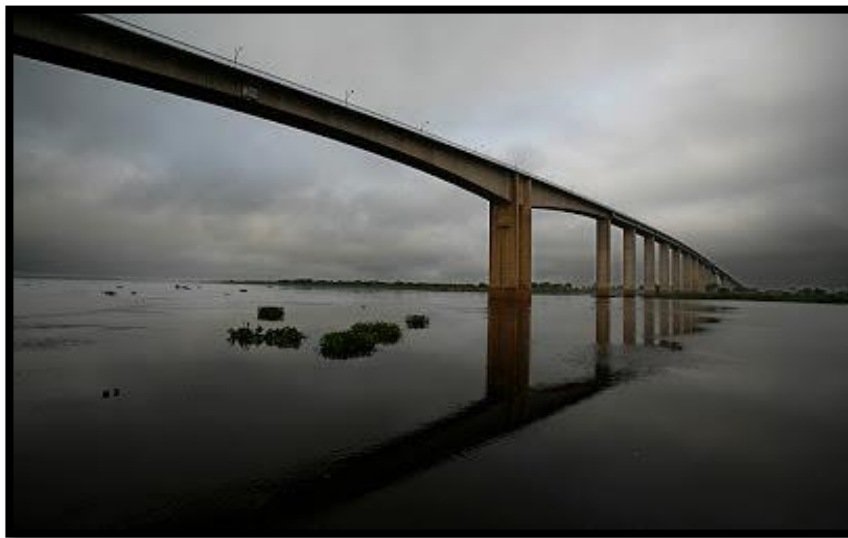
Figura 45. - Puente arquitectónico de hormigón.
