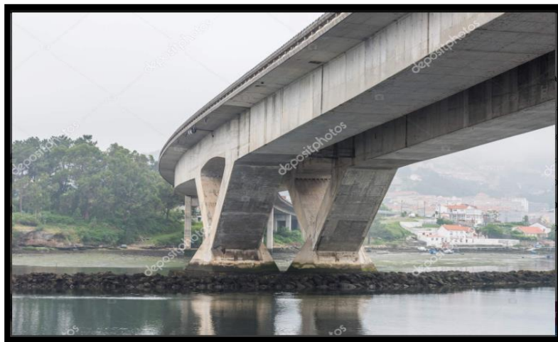
Figura 42. - puente de hormigón sobre el río
