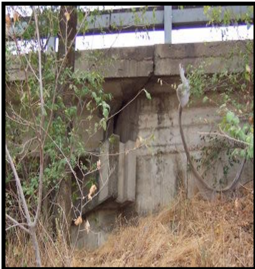
Figura 53. – nótese deterioro de las juntas de dilatación
