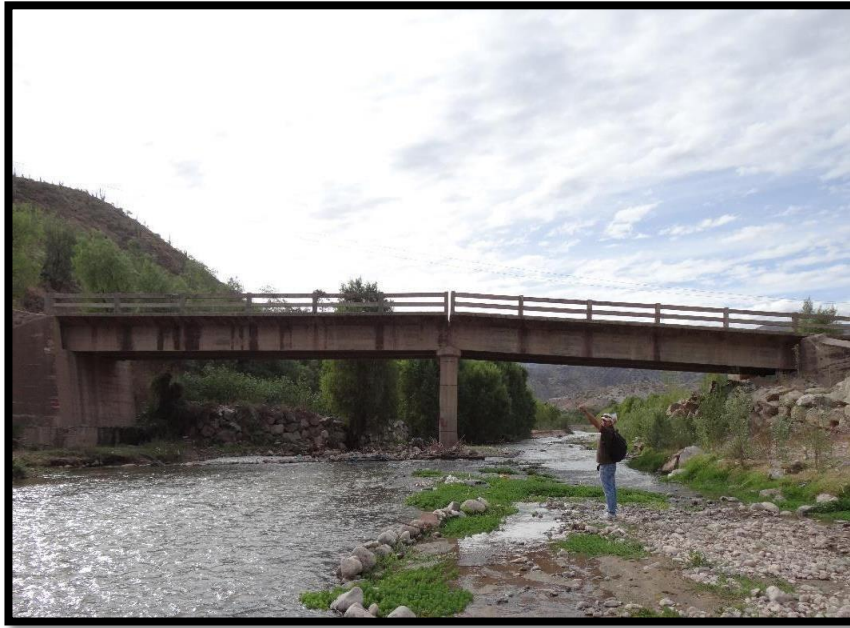
Figura 17. Tramos del Puente a evaluar.
