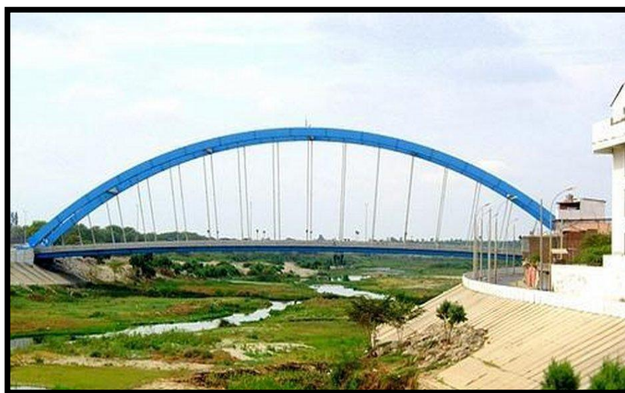
Figura 19.- Puente Bolognesi - Piura.
