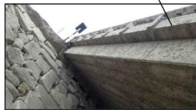
estribos proteccion enrocado
