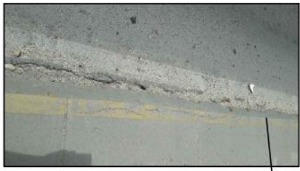
se observa pulimiento de agregados
