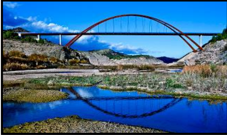
Figura 34.-Puente arco de La Vicaria en Albacete, es un puente arco metálico con tablero intermedio.
