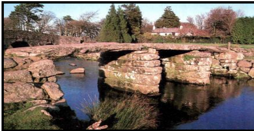
Figura 25.-Puente Histórico de Clapper, Devon.
