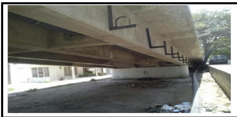
Figura 10.- Riostras y vigas longitudinales entre pilas.
