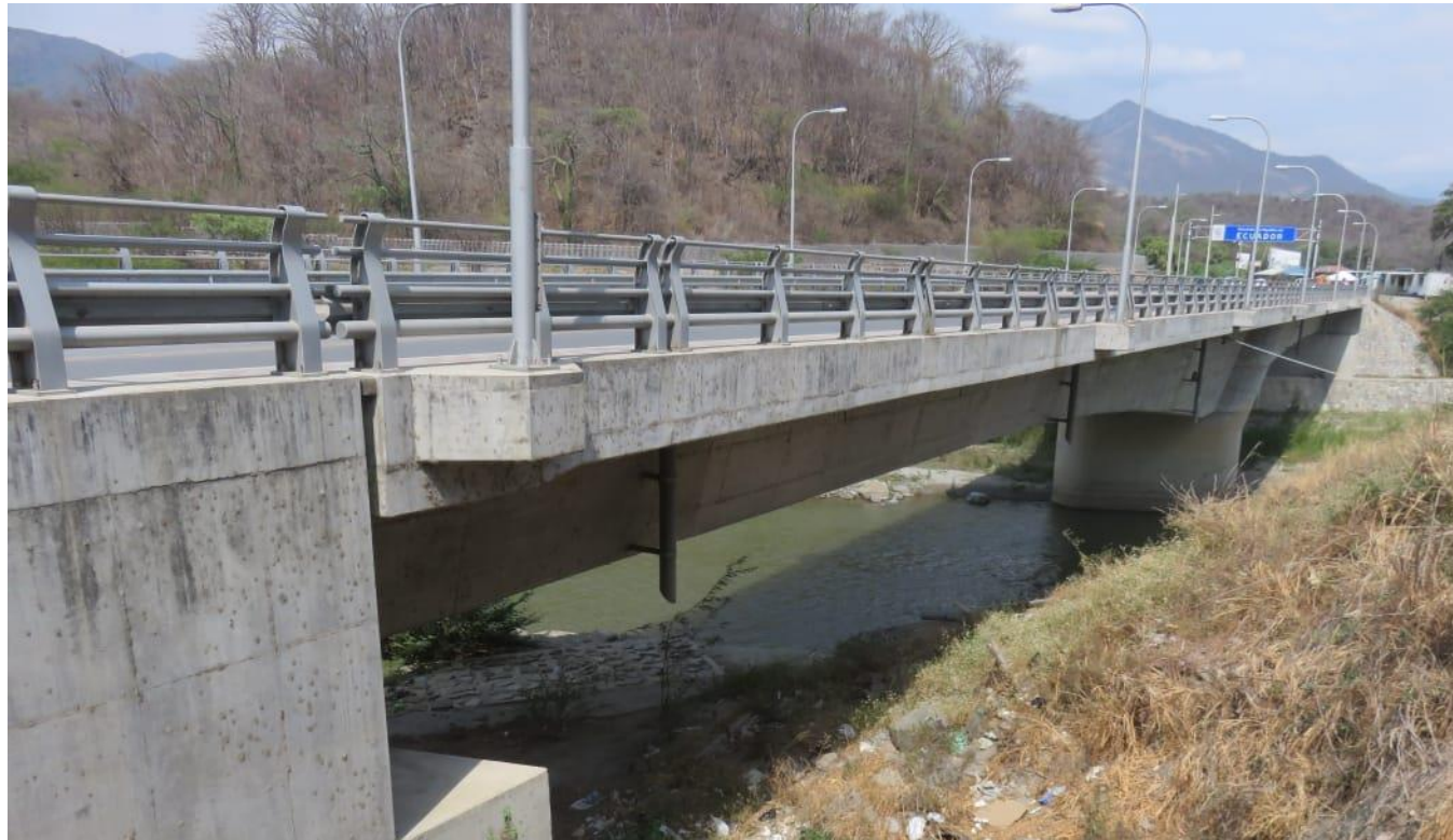
ANEXO N° 01: Foto del Puente Internacional Perú – Macara – Ecuador
