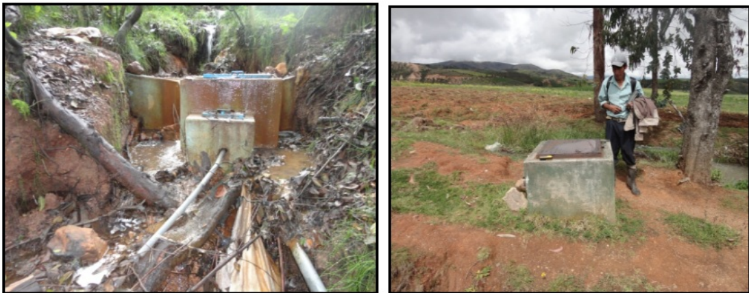
Figura 4.16: Vista de la captación tipo C-1 y cámara rompe presión tipo 6 existentes.
