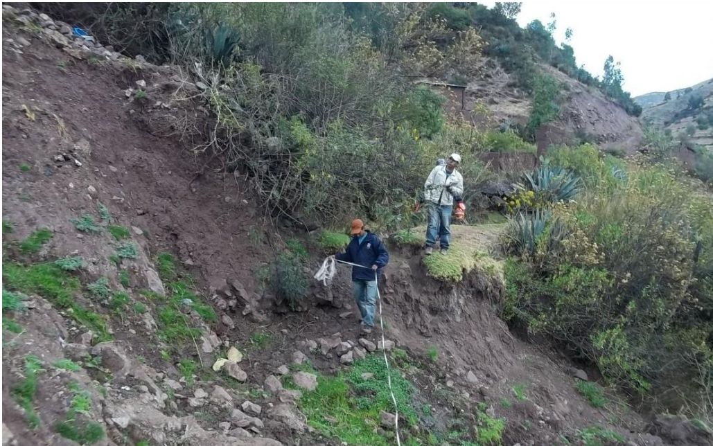
Foto 06: Trabajos topográficos realizados en el lugar del proyecto.
