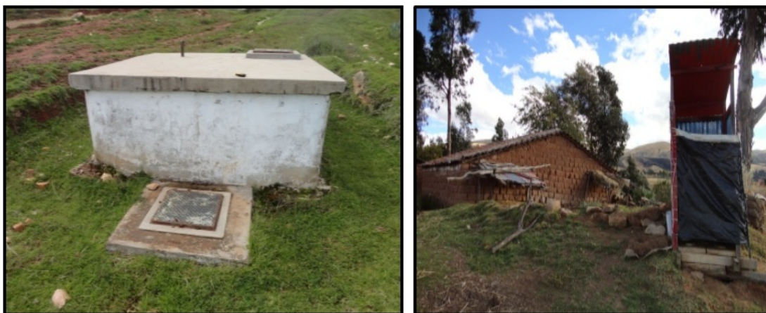
Figura 4.17: Vista del reservorio y letrina de hoyo seco totalmente colmatado existentes
