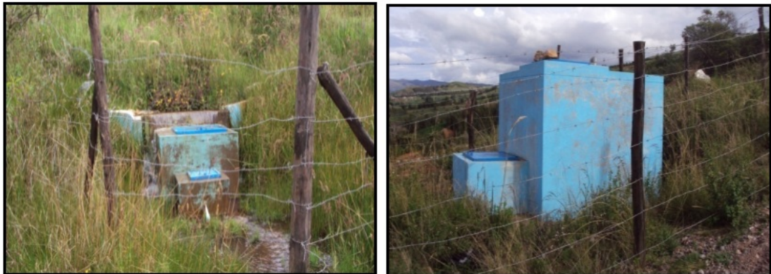
Figura 4.14: Vista de la captación tipo C-1 y reservorio de almacenamiento de agua respectivamente de la comunidad de Pichccapuquio.
