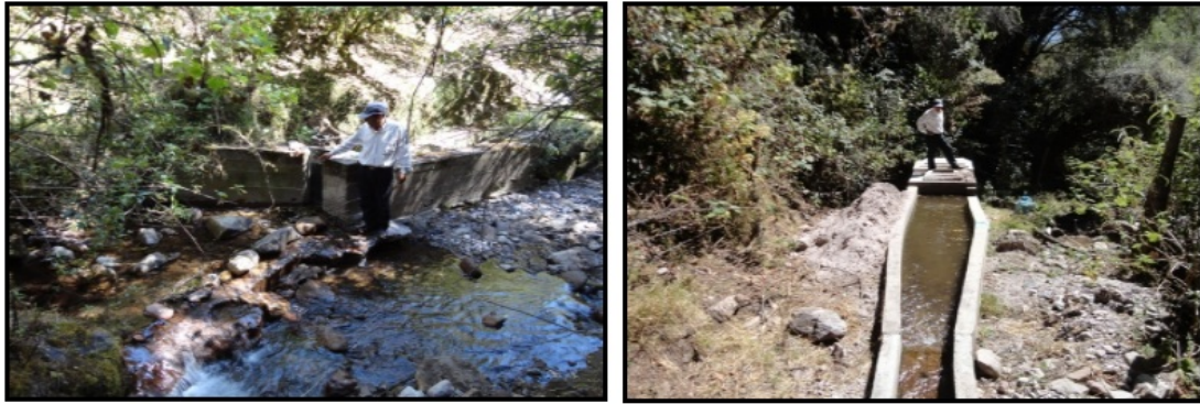
Figura 4.10: Vista de la captación tipo barraje fijo y planta de tratamiento de agua potable.
