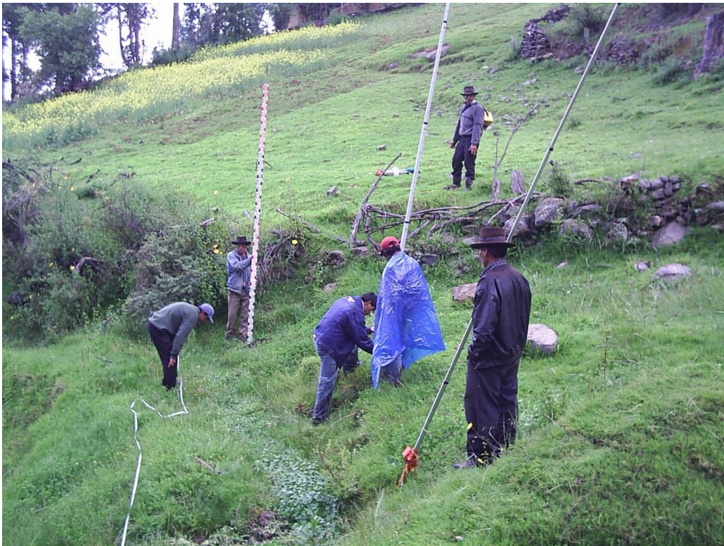
Foto 02: Trabajos topográficos realizados.
