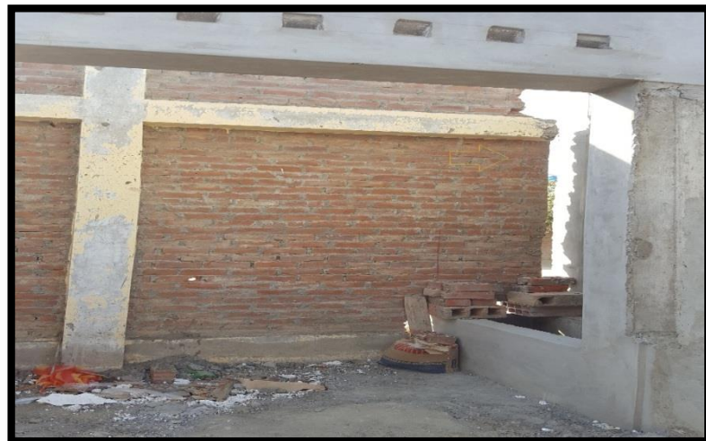
FIGURA 2: LESIONES MECÁNICAS FUENTE: Elaboración propia
