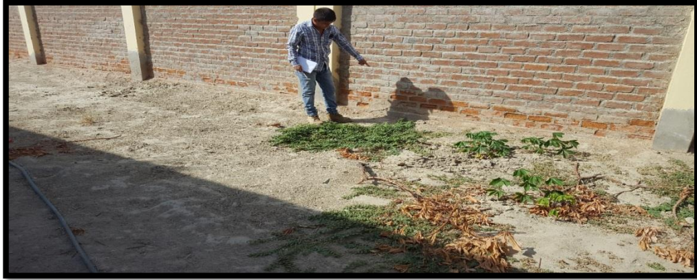
FIGURA 3: EROSIÓN FUENTE: ELABORACIÓN PROPIA
