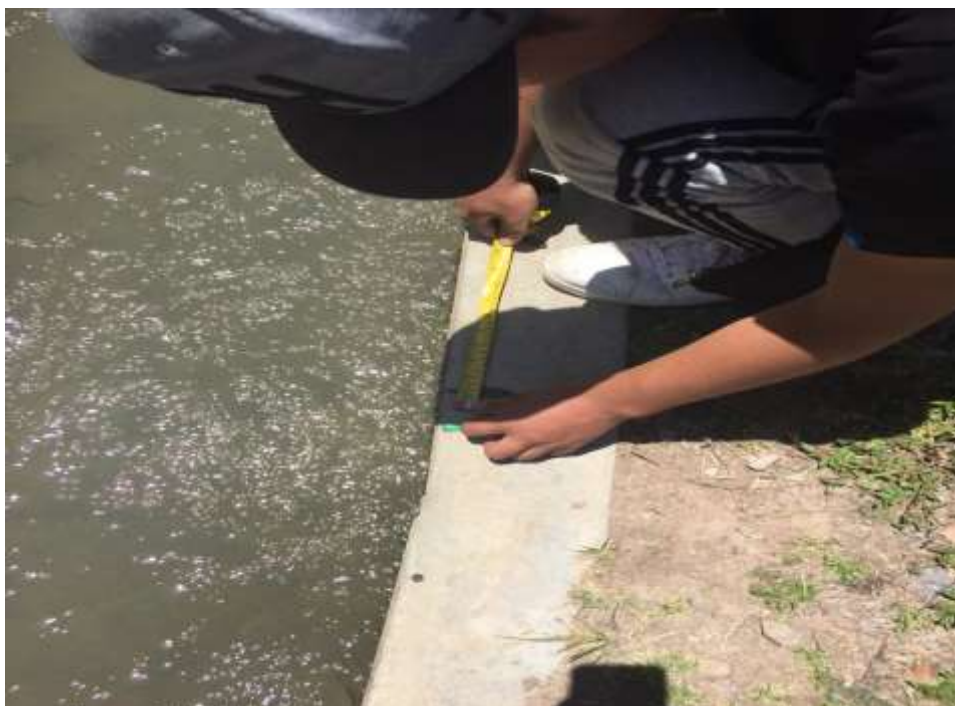
Fotografía 15: Grieta en el canal de riego Sexta Toma
