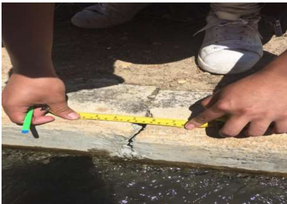
Fotografía 13: Grieta en el canal de riego Sexta Toma
