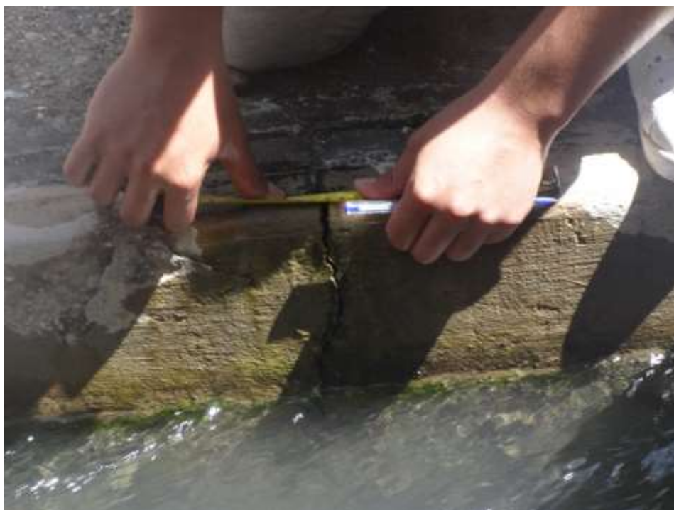
Fotografía 06: Grieta en el muro derecho del canal
