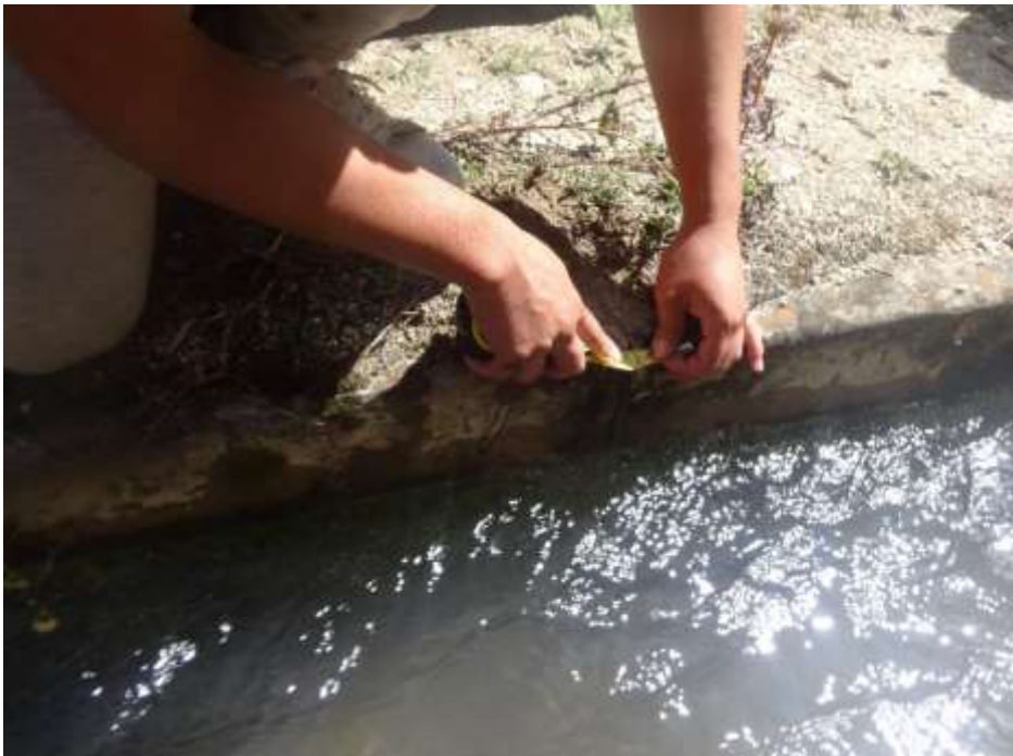
Fotografía 04: Grieta en el muro derecho del canal
