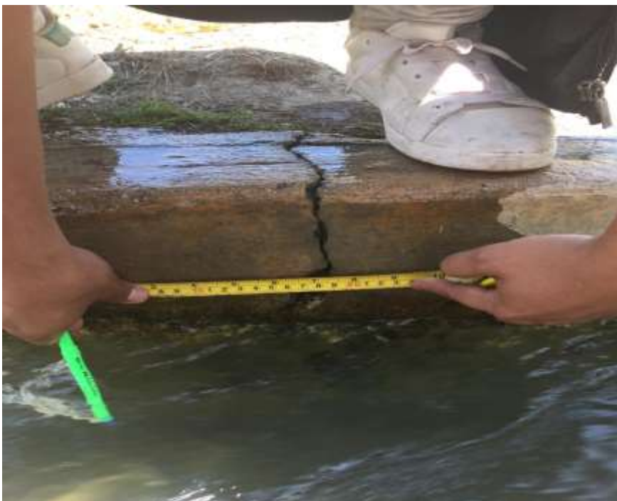
Fotografía 17: Grieta en el muro derecho
