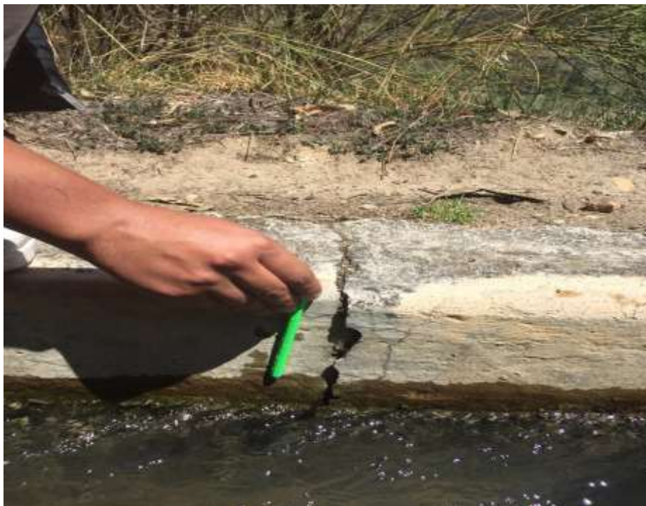
Fotografía 13: Grieta en el canal de riego Sexta Toma
