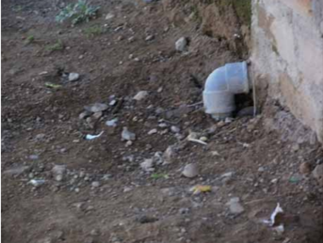
Figura 4.19: Instalación superficial del agua entubada
