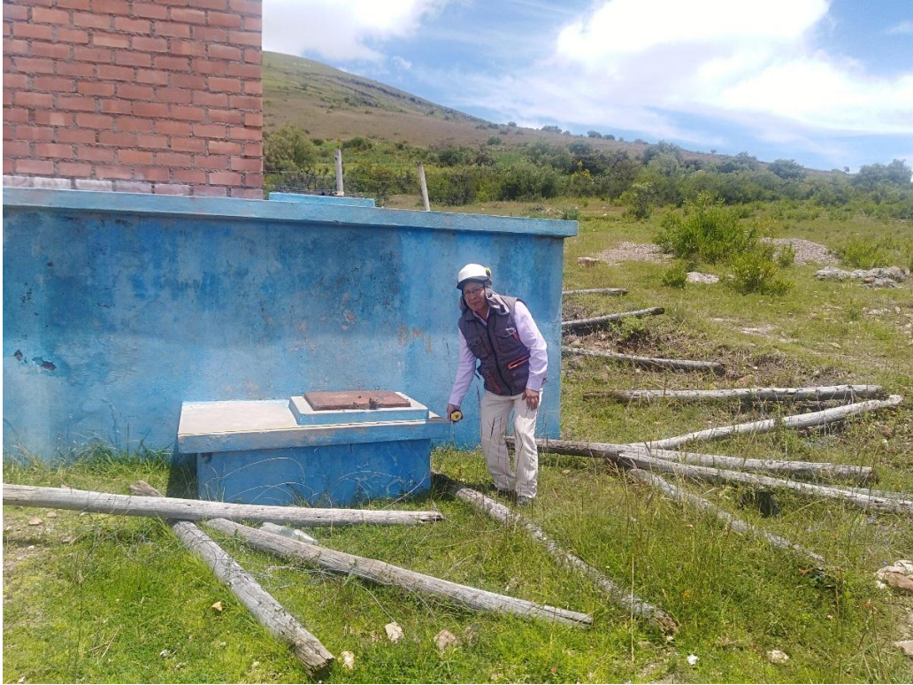
Foto 03: Toma de datos de las dimensiones del sistema de agua potable del lugar.
