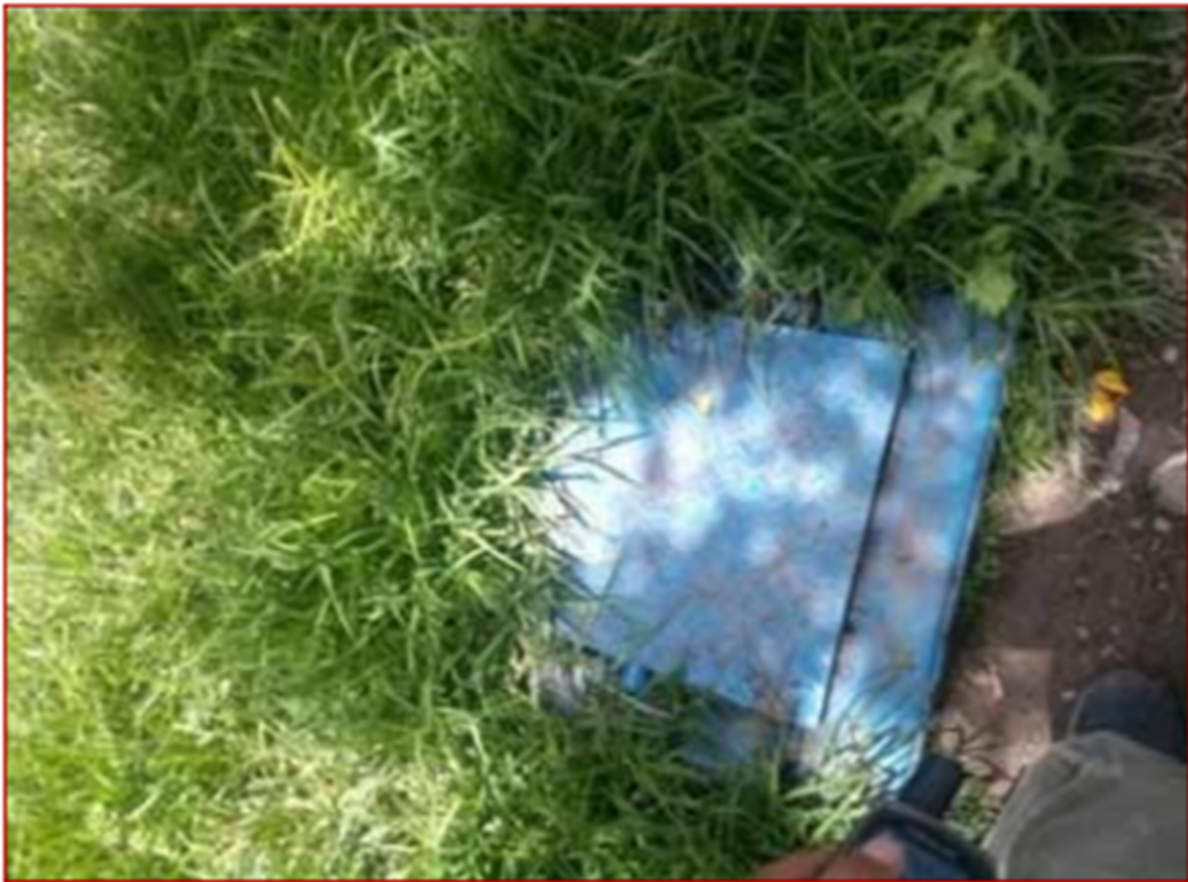
Figura 4.6: Crp en malas condiciones
