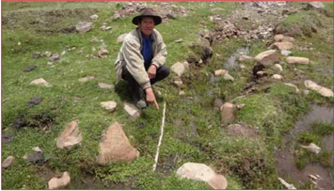
Figura 4.15: Se muestra la red de distribución en pesimas condiciones
