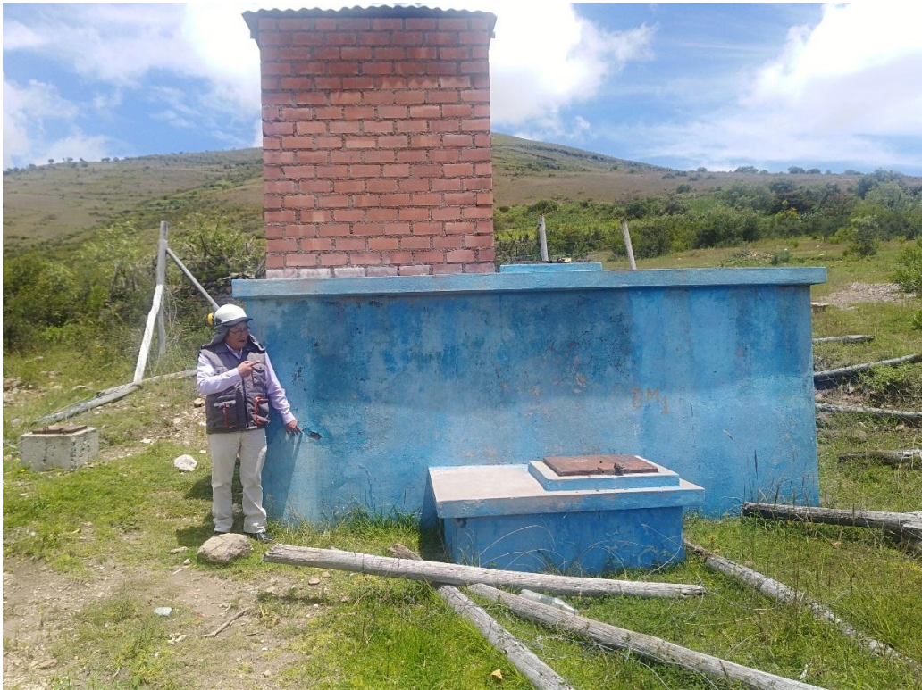
Foto 04: Inspección del sistema de agua potable del lugar.
