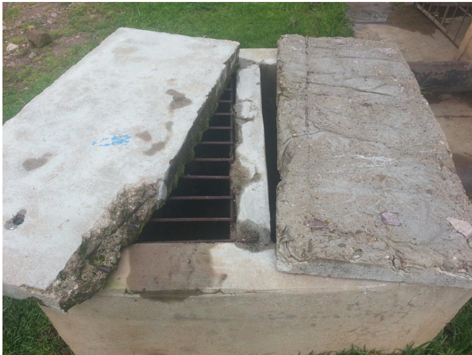
Foto 02: En esta fotografica podemos observar la camara de rompe presion instalado en la ciudad de Vilcashuamán.
