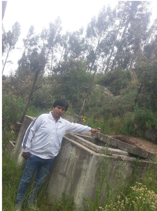
Foto 06: En esta toma fotografica podemos observar la caja de captación del sistema.
