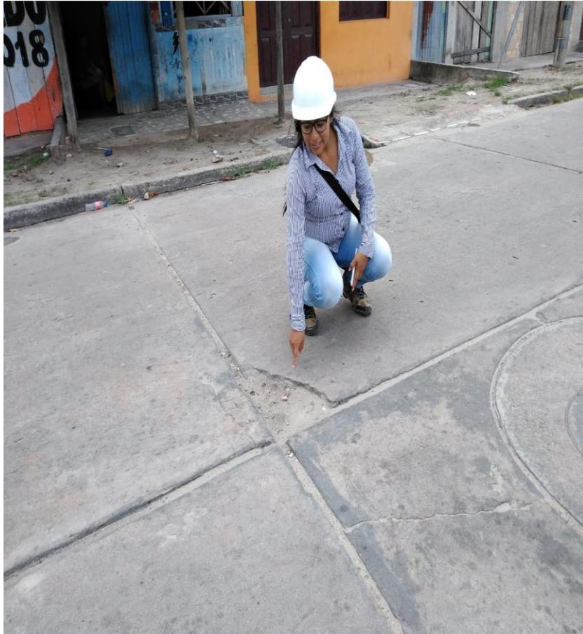
**Fotografía 5:** Descascaramiento de esquina de alta severidad en UM 01.
