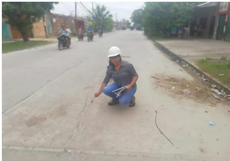
**Fotografía 16:** Daño grietas lineales de severidad media UM 11.
