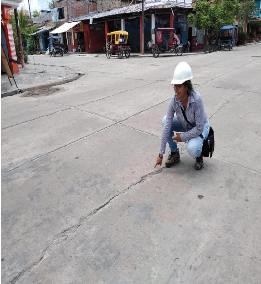
**Fotografía 6:** Grieta lineal de severidad alta UM 01.
