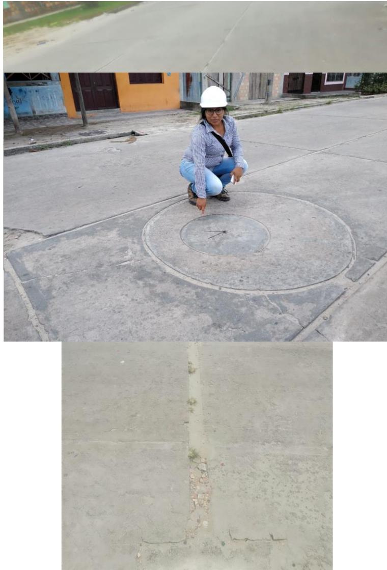
**Fotografía 13:** Daño de sello de junta, desconchamiento y escala de severidad media UM 07.
