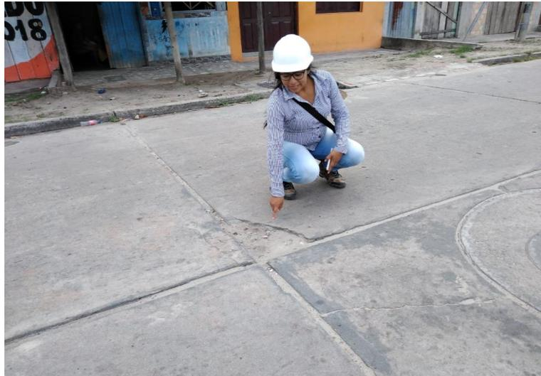
**Fotografía 17:** Descascamiento de esquina de severidad alta UM 12
