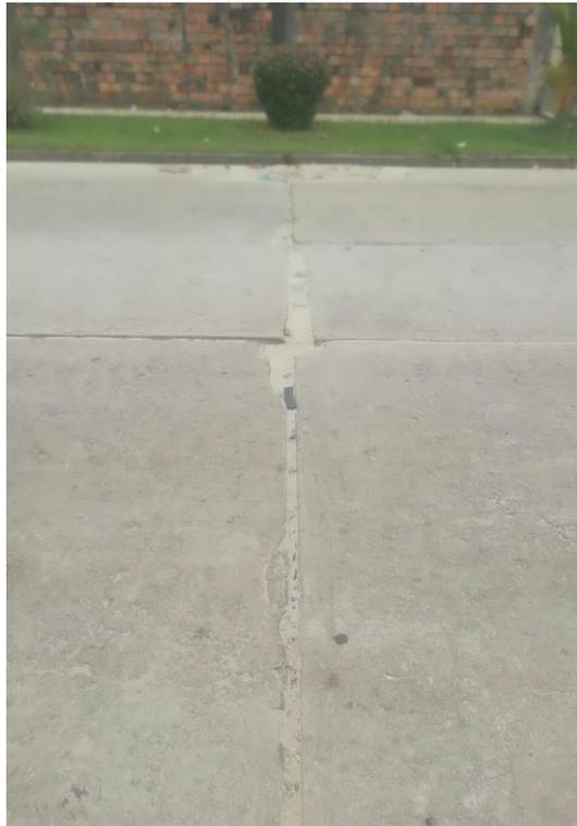
**Fotografía 7:** Daño de descascaramiento de Esquina severidad alta UM 01.
