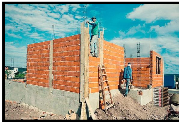
Figura 1: Albañilería confinada
