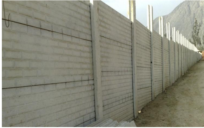
Figura 3: Muro no portante
