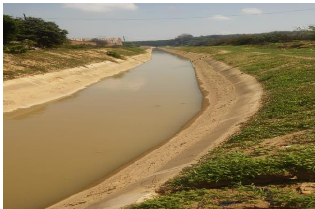
Imagen 2: Canal revestido de concreto.
