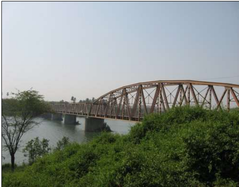
Imagen 30: Toma General del Puente mixto Isaiás Garrido.
