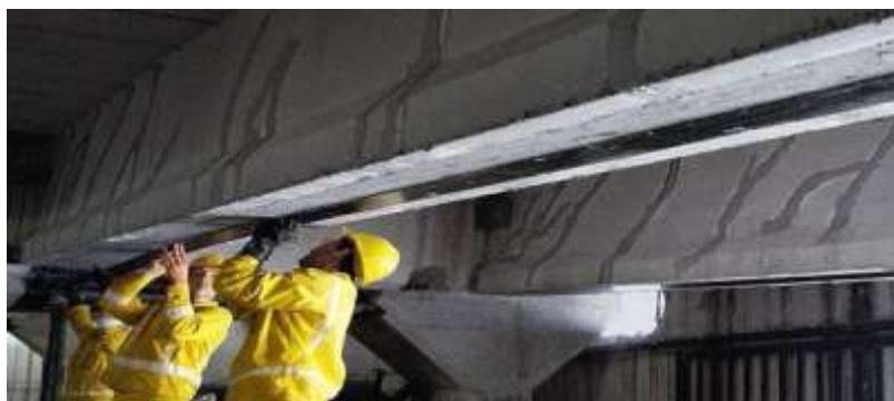
Imagen 15: Reparación de Fisuras.
