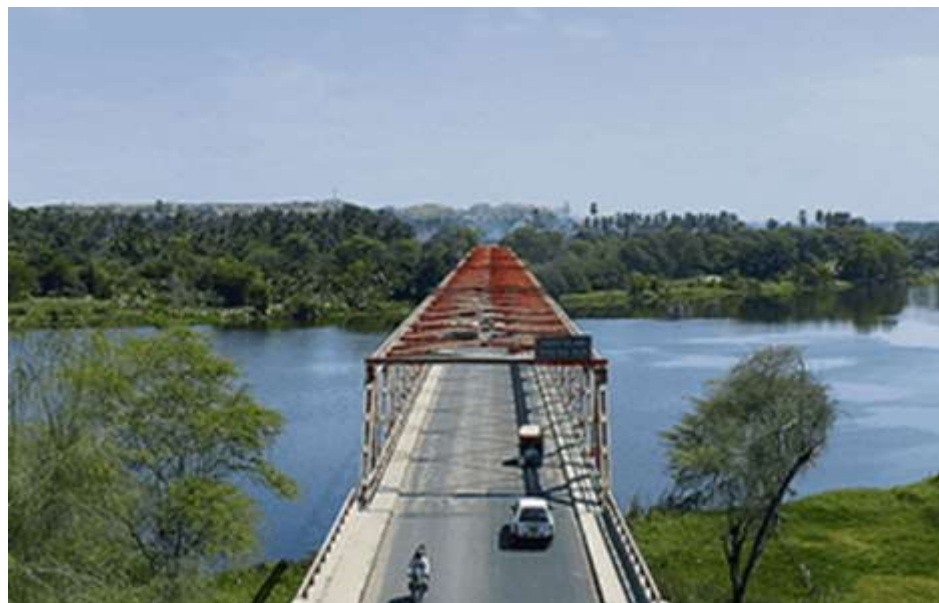
Imagen 2: Puente Sullana – Marcavelica
