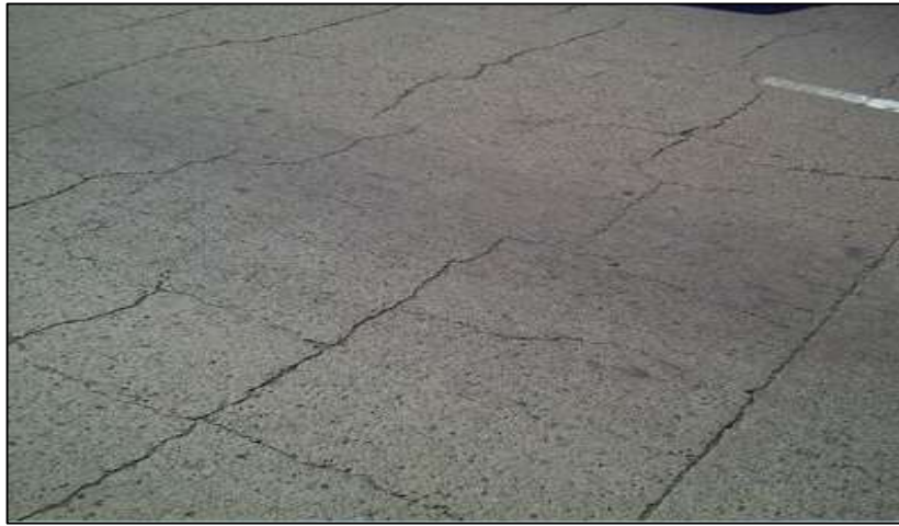
Imagen 16: Retracción Plástica - Losa.
