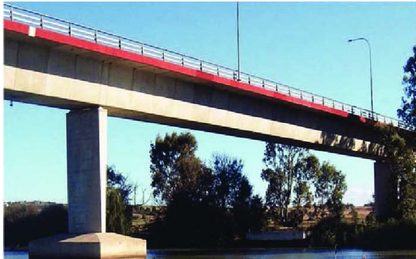
Imagen 5: Vigas Principales – puentes
