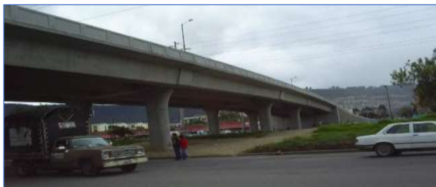
Imagen 1: Puentes Bogotá – Colombia
