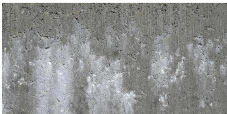
*Imagen N° 30. Eflorescencia en elementos estructurales.*
