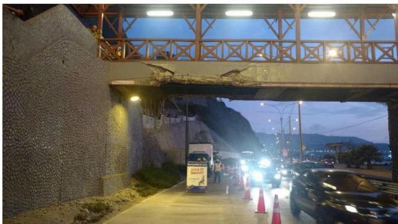
*Imagen N° 21. Impacto en la estructura del puente.*
