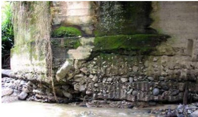
*Imagen N° 23. Socavación de pilar de puente.*
