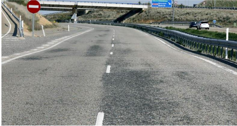
*Imagen N° 22. Desgaste de pavimento.*
