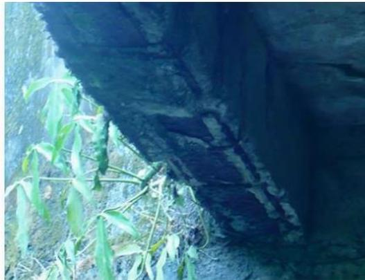
*Imagen N° 20. Desprendimiento de c<sup>a</sup> en una viga.
