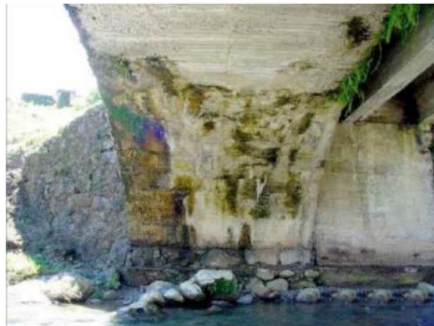
*Imagen N° 19. Estribo con presencia de humedad*
