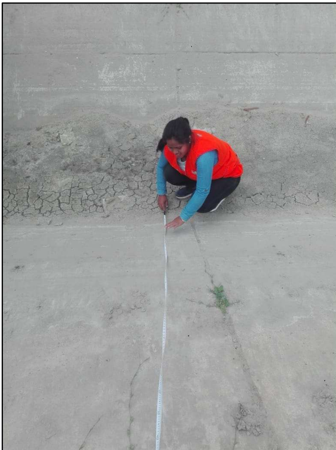
Gráfico N° 45: Medición del muro lateral del canal
