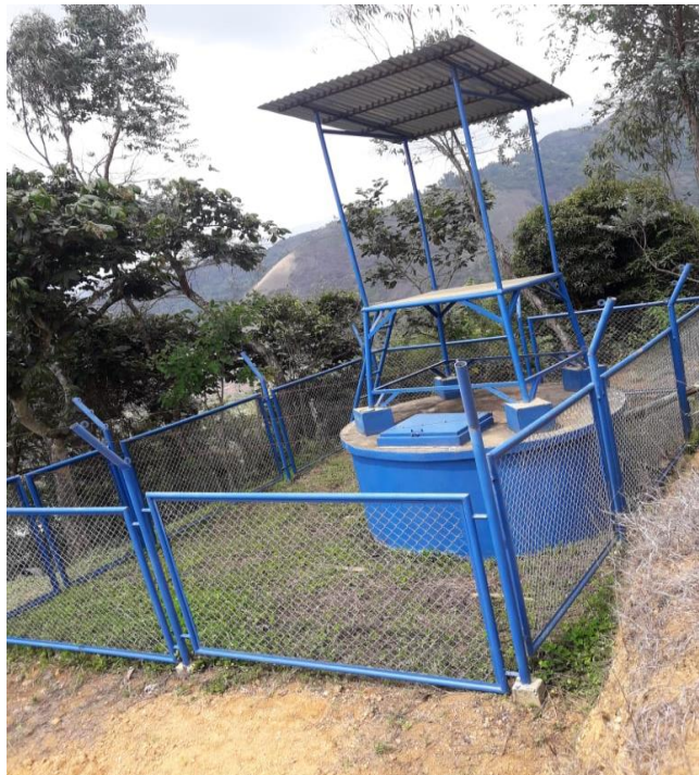
Fotografía 8 Vista frontal del reservorio existente
