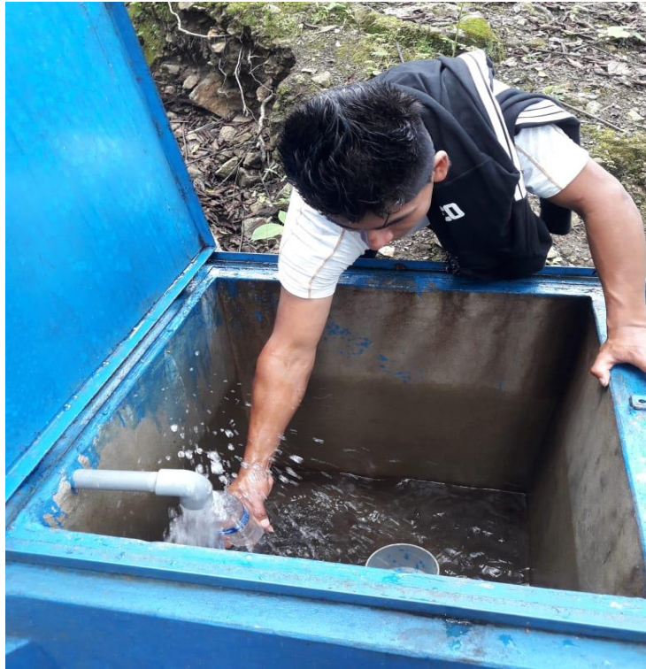
Fotografía 7. Vista interna de la Cámara Rompe Presión
