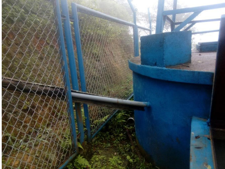
Fotografía 11. Llegada de la tubería de conducción al reservorio
