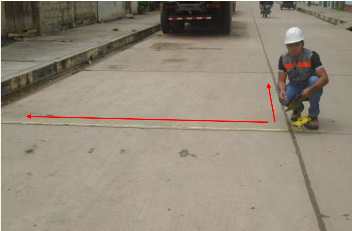
Figura 171. En la fotografía se observa la medición de la losa de la unidad de muestra 1.
