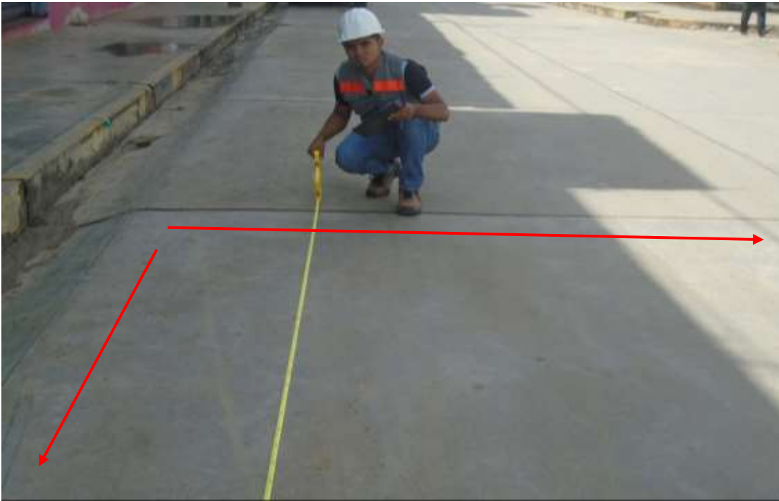
Figura 183. En la fotografía se observa la medición de la losa de la unidad de muestra 4.
