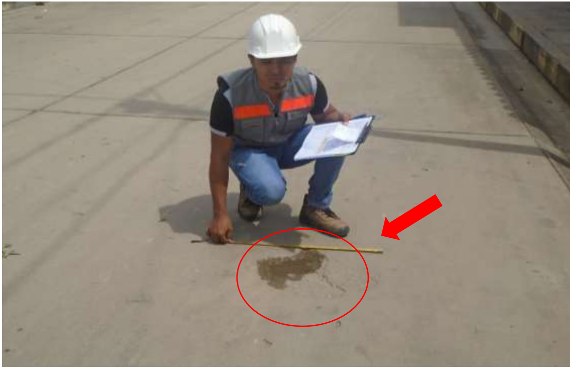
Figura 181. En la fotografía se observa la patología parche pequeño de la unidad de muestra 3.
