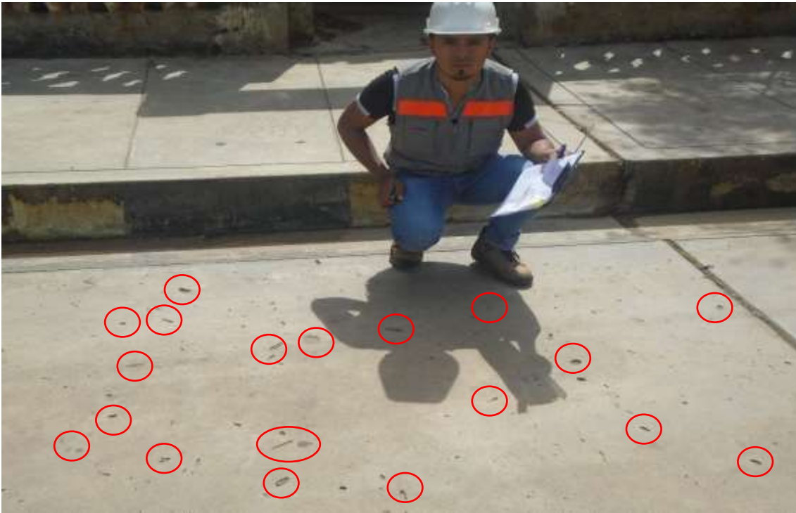
Figura 193. En la fotografía se observa la patología popouts de la unidad de muestra 6.
