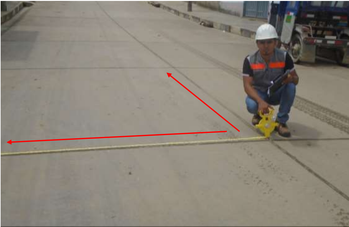
Figura 179. En la fotografía se observa la medición de la losa de la unidad de muestra 3.
