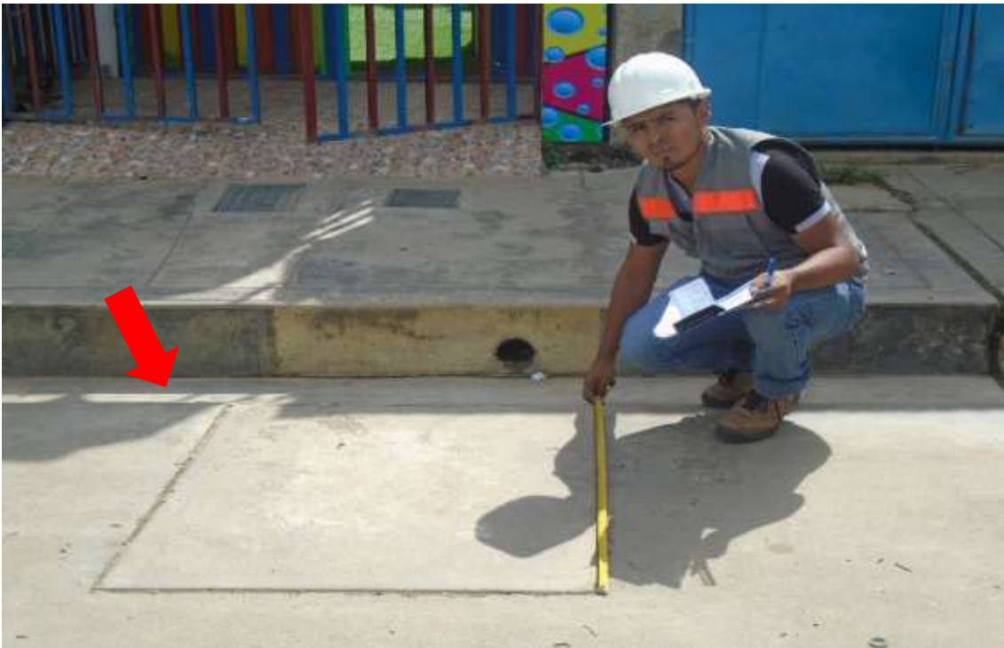
Figura 196. En la fotografía se observa la patología parche grande de la unidad de muestra 7.
