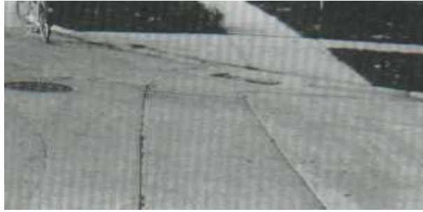
Figura 25. Parche Grande y Acometidas de Servicios Publicos de Baja Severidad.
