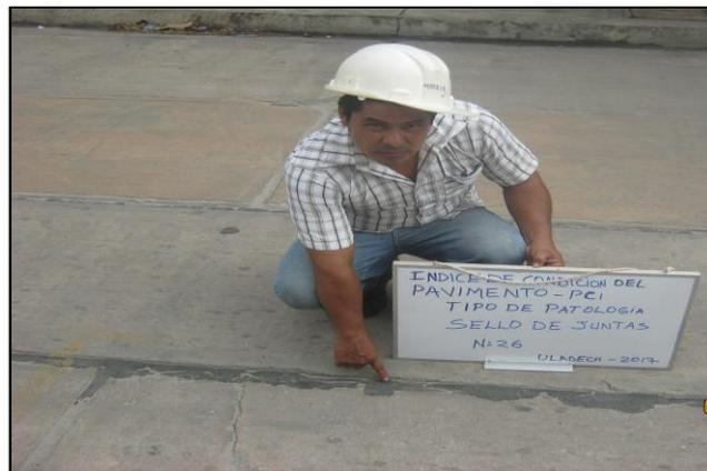
**Figura 18:** Daño del Sello de la Junta
