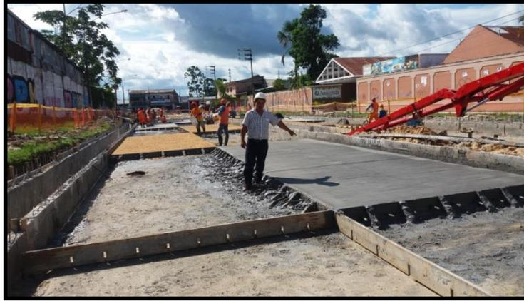
*Figura 04.* Pavimento Rígido.
