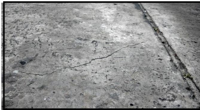
*Figura 10.* Pavimento con fallas por fatiga.
