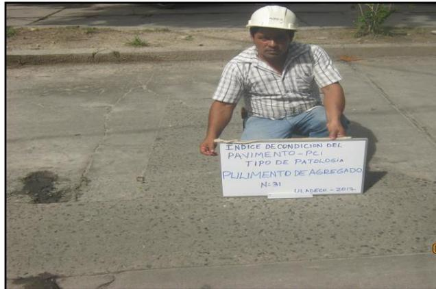
**Figura 27:** Pulimiento de Agregado
