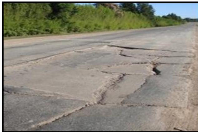
*Figura 08.* Pavimento con fallas por insuficiencia estructural.
