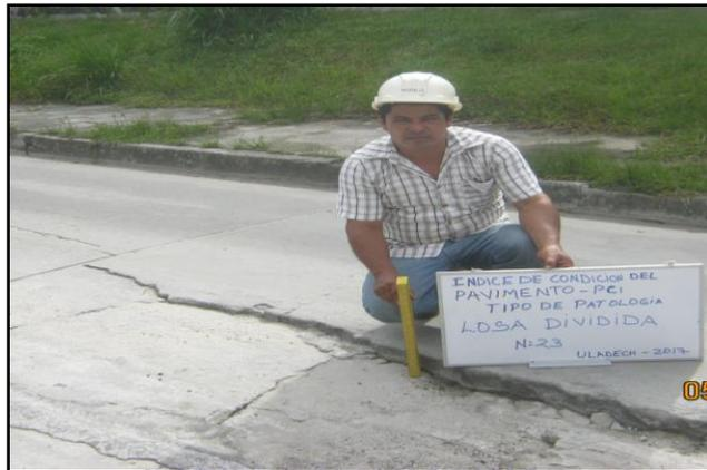
*Figura 23:* Losa Dividida
