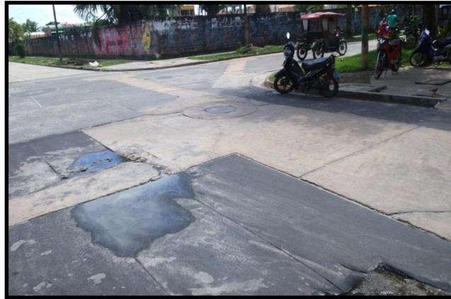
*Figura 09.* Pavimento con fallas por defectos constructivos.
