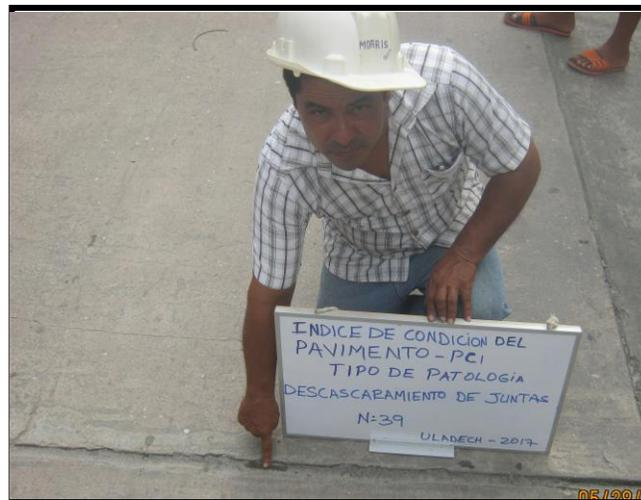
*Figura 16:* Descascaramiento de Junta
