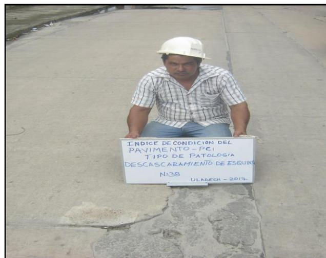
**Figura 15:** Descascaramiento de Esquina.
