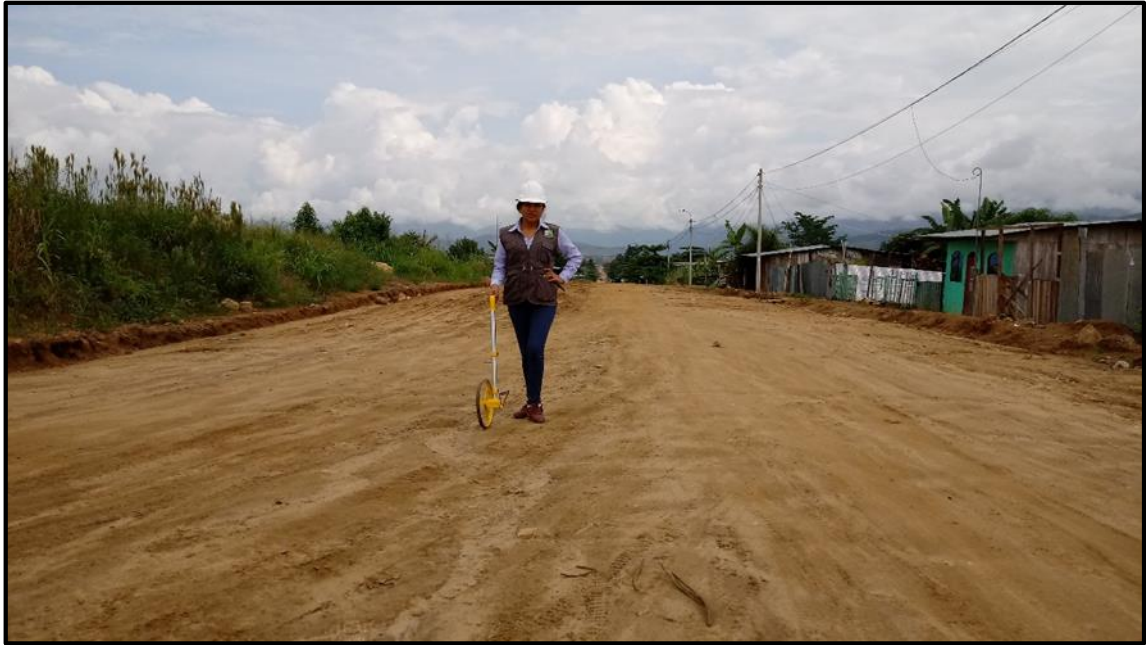
Figura 75: Vista panorámica del inicio de la calle 7 de Junio (exclusión).
