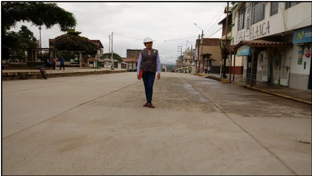
Figura 72: Vista panorámica del final de la calle 3 de Noviembre a estudiar (Inclusión).
