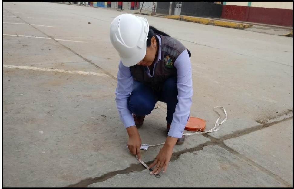
Figura 97: Daño de sello de junta en la calle 7 de Junio para la UM-04.
