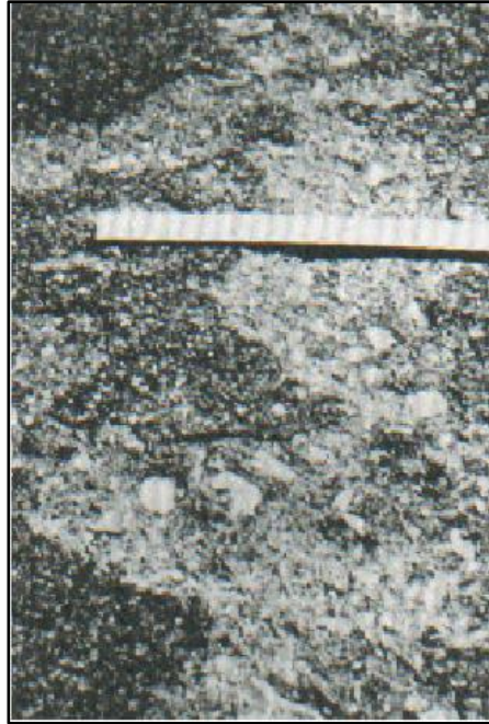
Figura 10: Desconchamiento severidad media Según, Vásquez L. (21) (2012)
