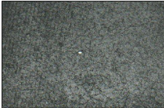
Figura 09: Desconchamiento severidad baja Según, Vásquez L. (21) (2012)
