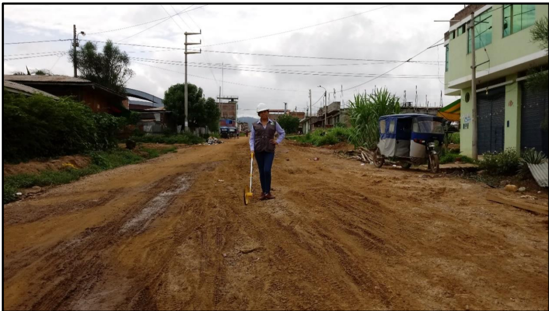
Figura 80: Vista panorámica del final de las 21 cuadras de la calle 7 de Junio (exclusión).
