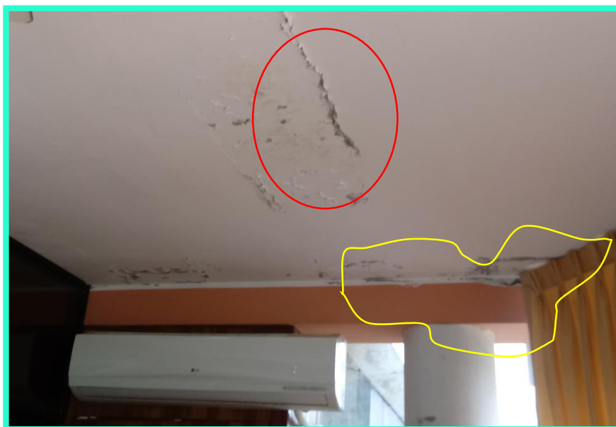
Figura 47. Se puede visualizar las patologías en la losa aligerada en la oficina de la gerencia de desarrollo urbano y rural en el cuarto nivel de la Municipalidad Distrital de Rio Negro. la imagen pertenece a la UM2.
