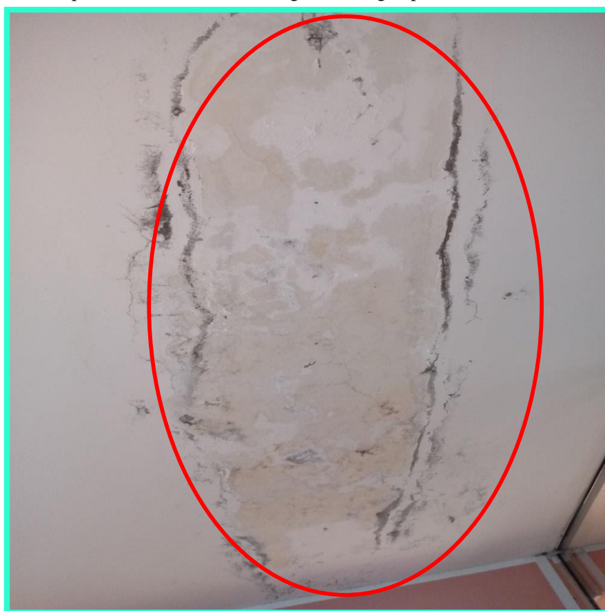
Figura 47. Se puede visualizar las patologías en la losa aligerada en la oficina de la gerencia de desarrollo urbano y rural en el cuarto nivel de la Municipalidad Distrital de Rio Negro. la imagen pertenece a la UM2.
