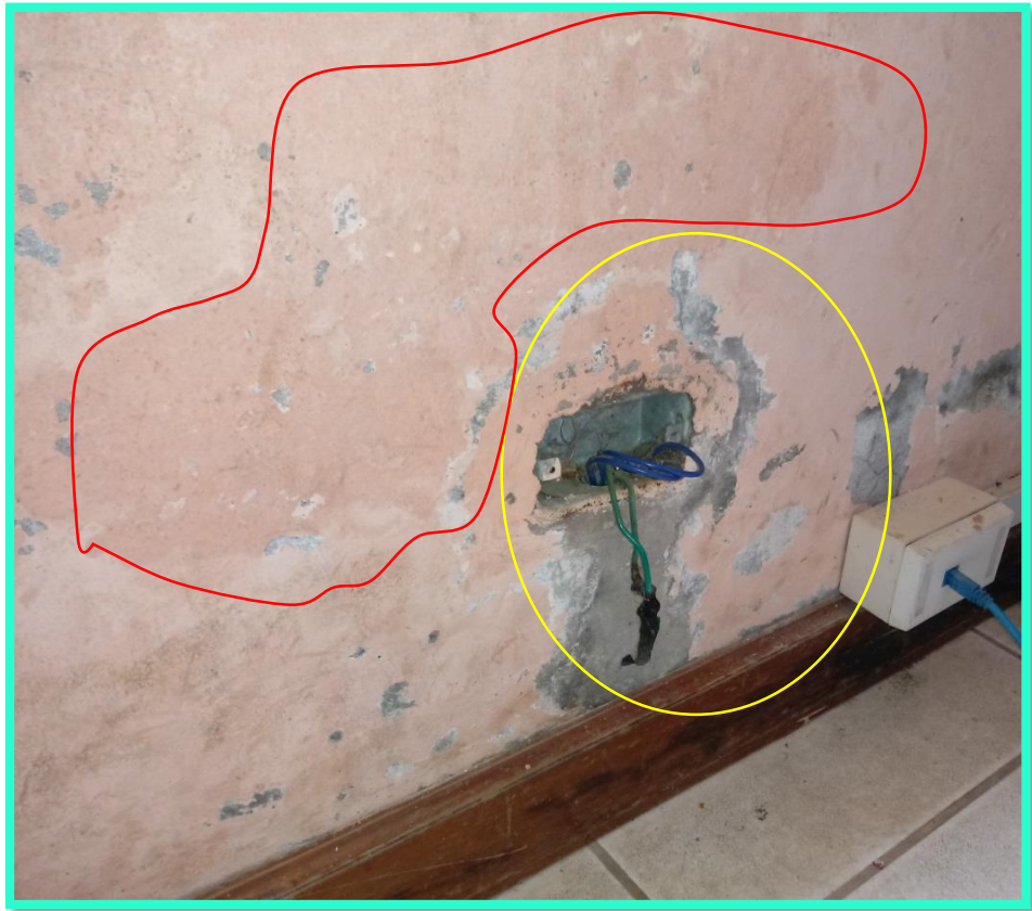
Figura 45. Se puede visualizar las patológicas en la oficina de la gerencia de desarrollo urbano y rural en el cuarto nivel de la Municipalidad Distrital de Rio negro. la imagen pertenece a la UM5.
