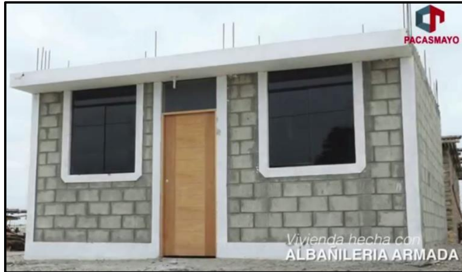
Figura 3. Vivienda hecha con albañilería armada.
