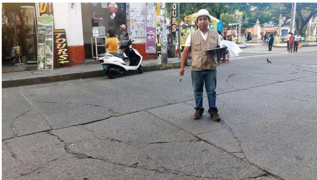
13: Unidad de Muestra 04 del Jirón Tarma, se observa Punzonamiento.
