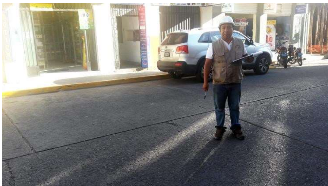
Fotografía 05: Unidad de Muestra 02 del Jirón Tarma, se observa patología de Pulimento de Agregados.
