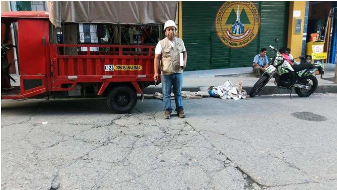
21: Unidad de Muestra 06 del Jirón Tarma, se observa Pulimento de Agregados
