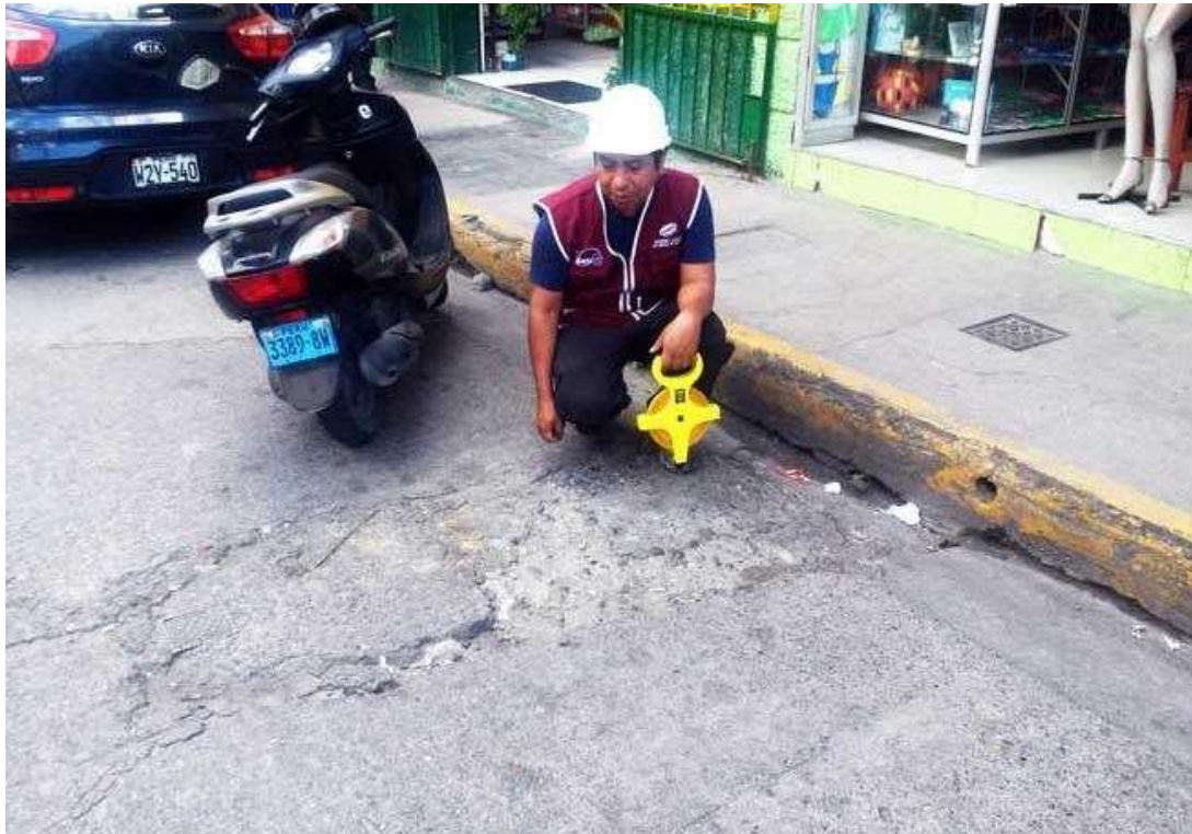
13: Unidad de Muestra 04 del Jirón Tarma, se observa Punzonamiento.
