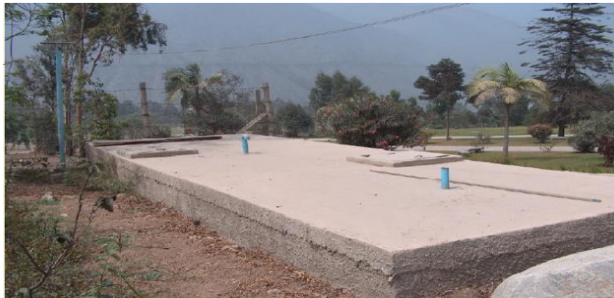
Imagen 4: Reservorio enterrado de concreto armado
