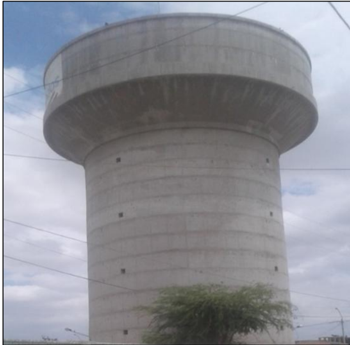
Imagen 1: Reservorio de concreto armado las Mercedes Castilla- Piura
