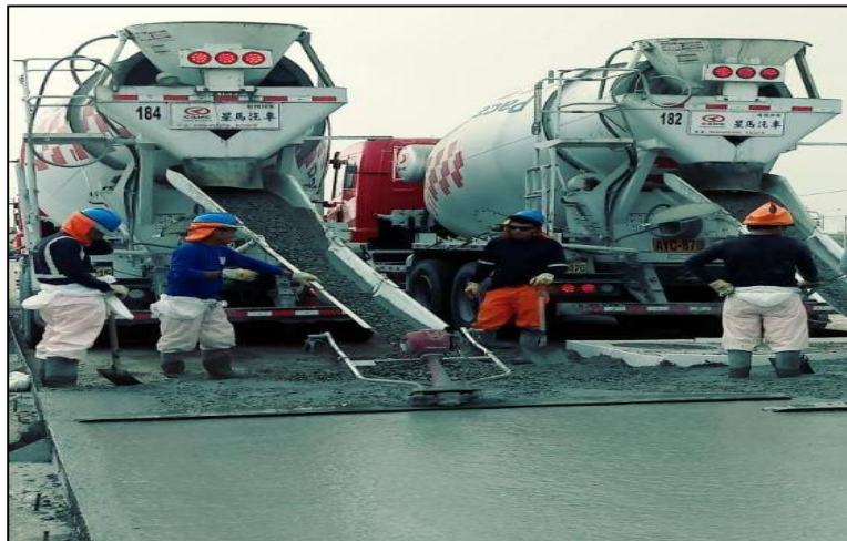
Imagen 5: Concreto Premezclado en obra.
