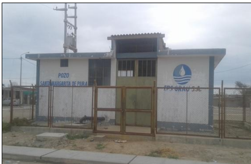
Imagen 2: Reservorio apoyado Santa Margarita-Piura.
