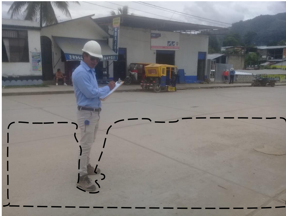
Figura 243: patología de pulimiento de agregados
