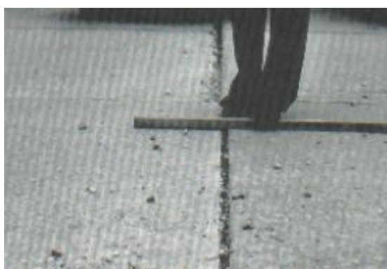
Figura 20: Escala de baja severidad.
