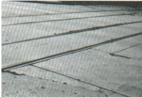
Figura 45: Cruce de vía férrea de baja severidad.
