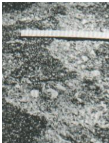
Figura 48: Desconchamiento / Mapa de grietas / Craquelado de baja severidad.
