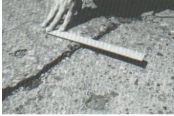
Figura 21: Escala de severidad media.
