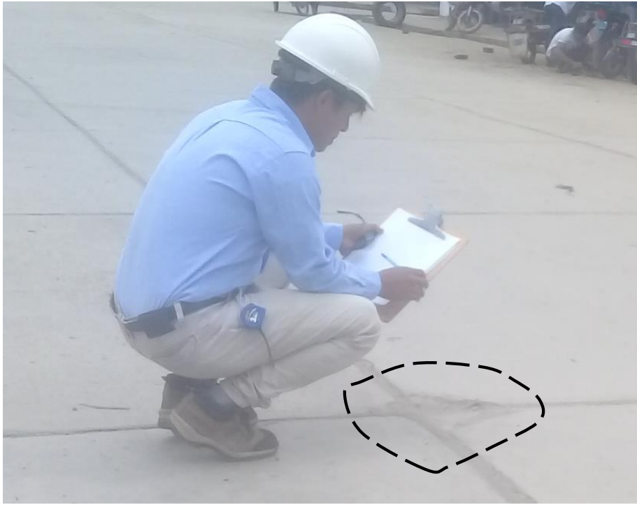
Figura249: Patología de descascaramiento de esquina de severidad media.
