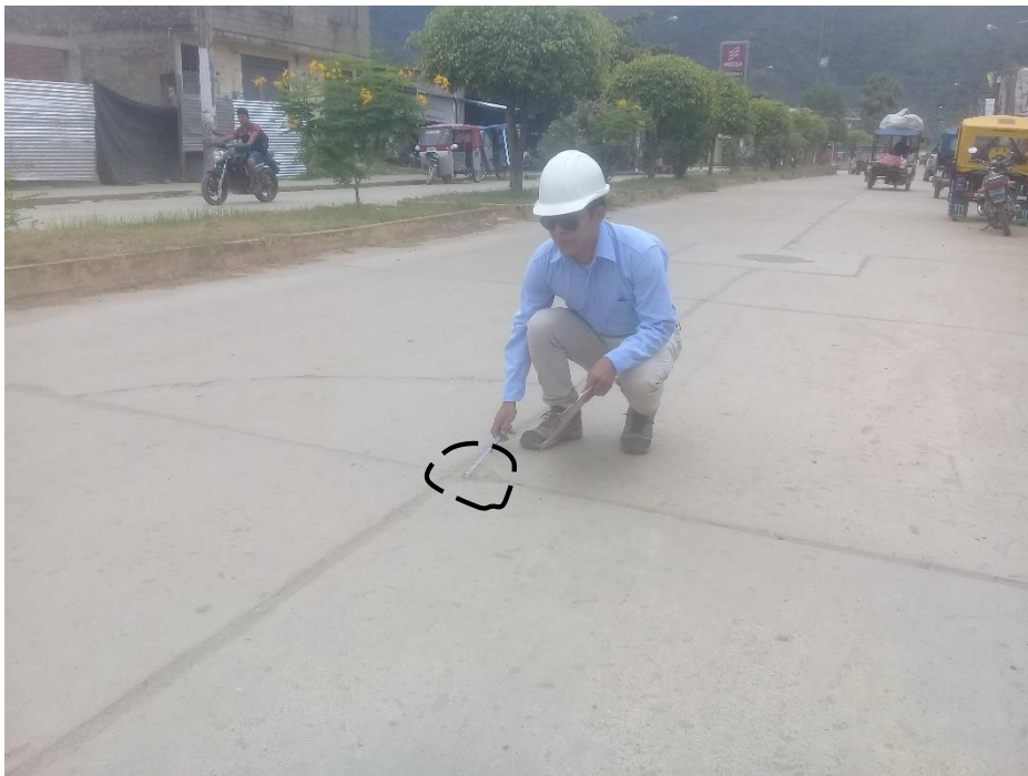
Figura250: Patología de descascaramiento de esquina de severidad media.
