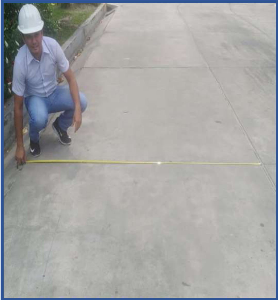
Figura 47 Medicion de PAÑOS de la calle ABTAO
