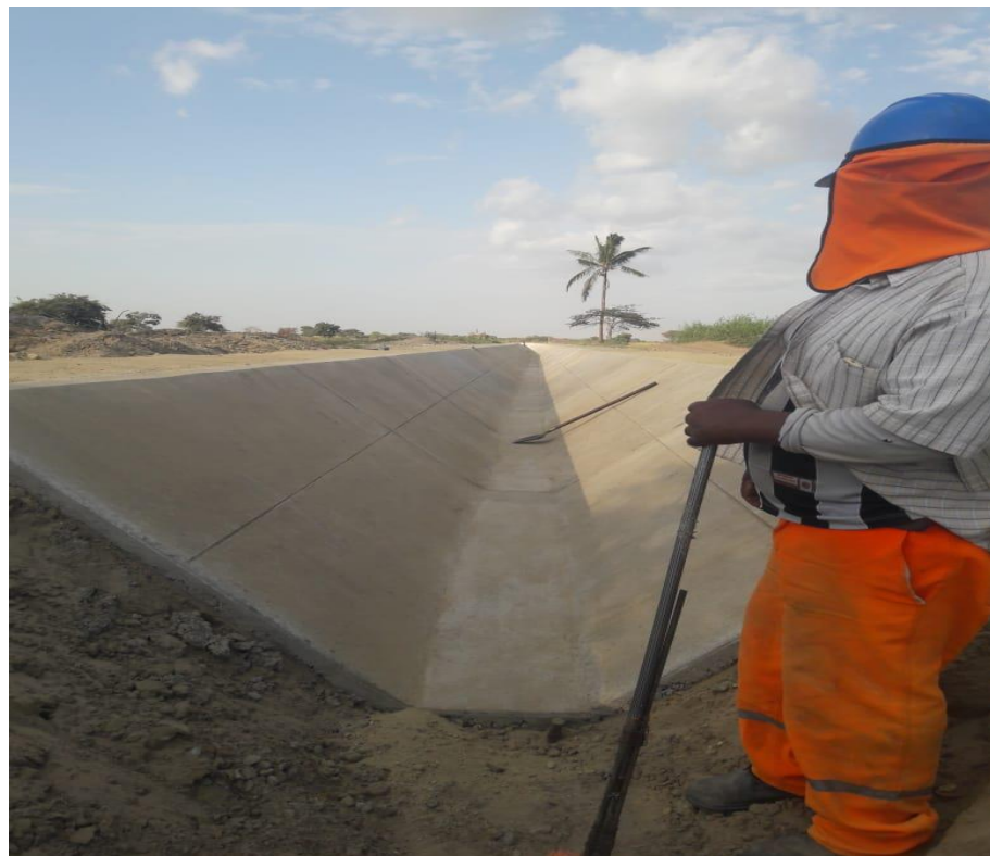
Gráfico 3: Construcción de canal artificial
