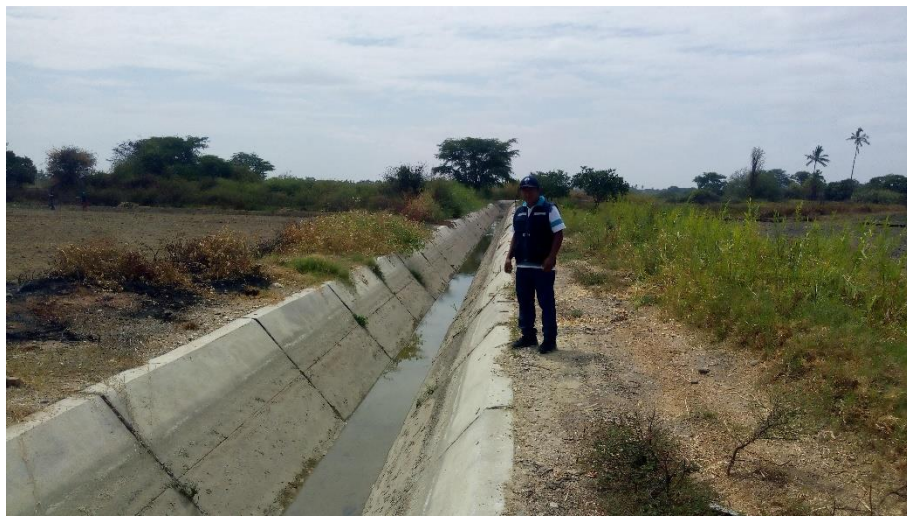
Gráfico 4: Canal de concreto.
