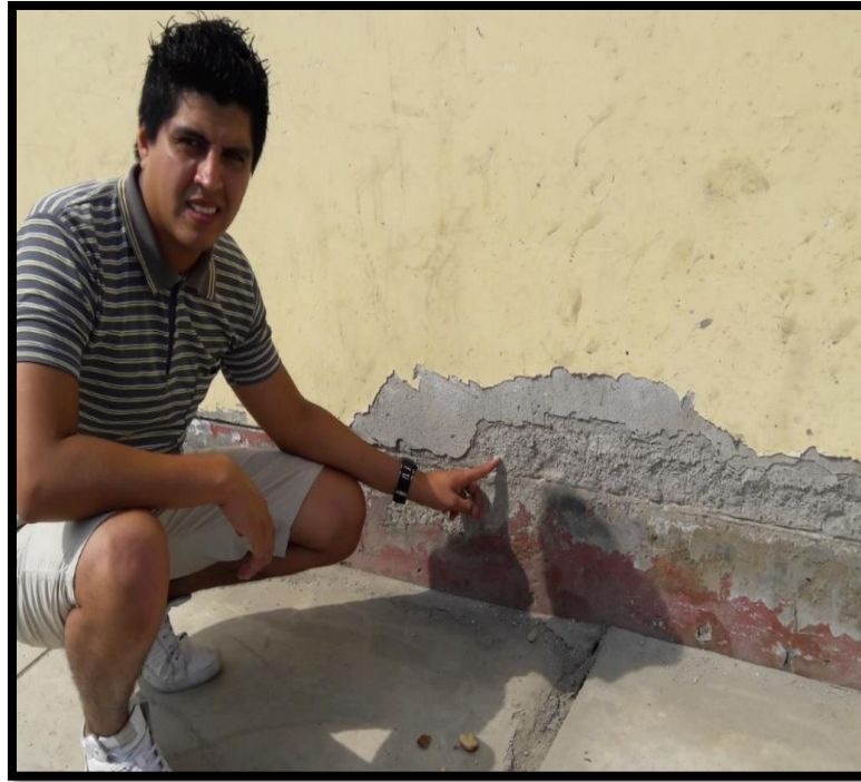
Fotografía 11. Se muestra la presencia de disgregación en la parte inferior del muro, ubicada en la unidad muestral 14.
