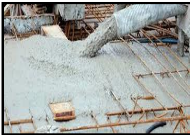
Figura 3. Imagen de concreto armado. Fuente: Arkiplus (2019).
