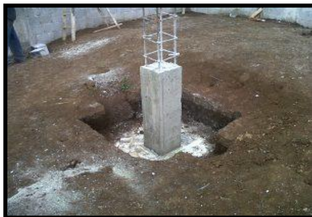
Figura 9. Columna de concreto armado.
