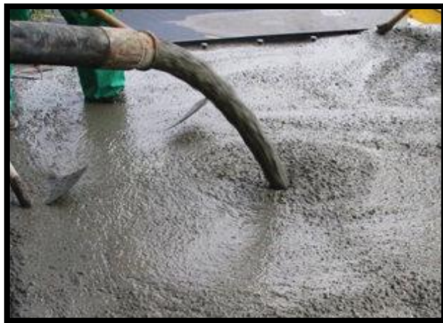
Figura 1. Imagen de vaciado de concreto. Fuente: El Palmar (2019).
