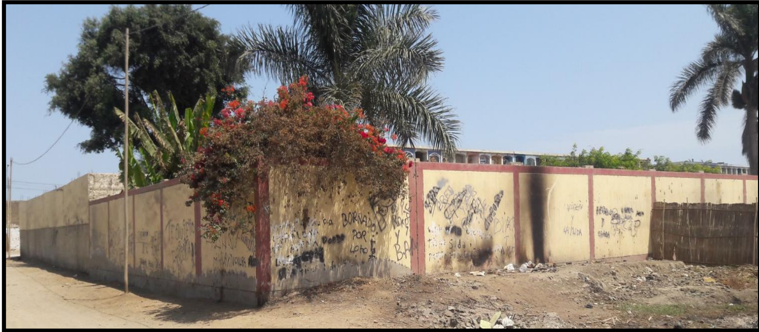
Fotografía 02. Vista panorámica entre las intersecciones de las calles 57 y 59 del cementerio municipal Sandro Dordi, ubicado en el distrito de Santa, provincia del Santa, departamento de Áncash.
