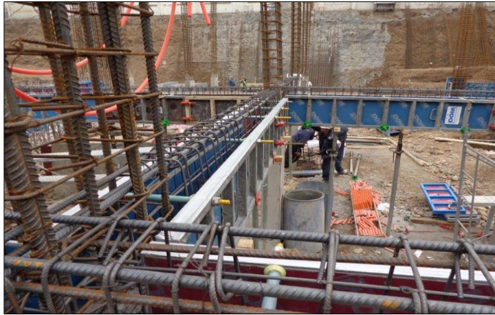
Figura 8. Encofrado metálico de una viga peraltada, Cartagena - Colombia. Fuente: DOM (2014)
