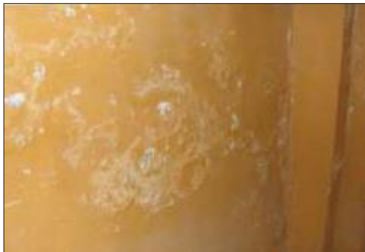
Figura 2. Eflorescencia encontrada en el muro de la iglesia santo Toribio de Mogrovejo. Fuente: Varela y Zetien (2013).
