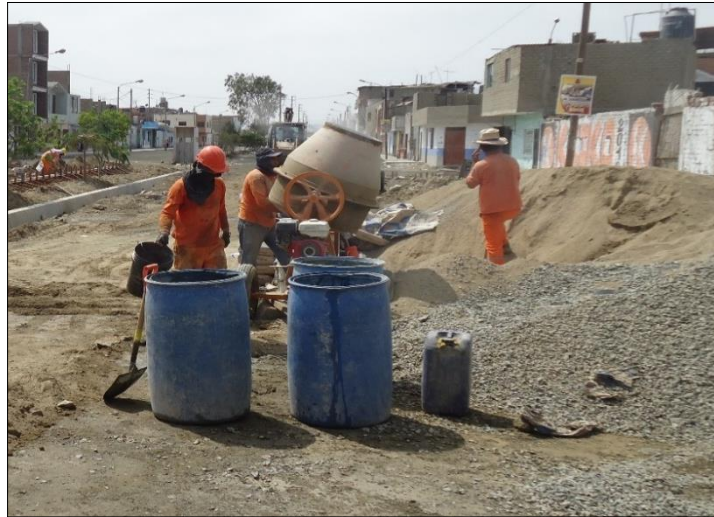
Figura 14. Componentes y preparación del concreto. Fuente: Municipalidad Provincial del Santa (2017).
