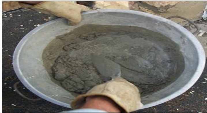
Figura 12. Preparación de mortero. Fuente: Chema (2016)
