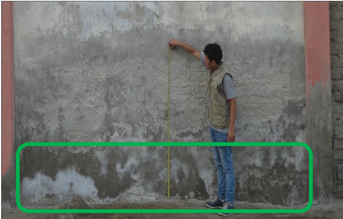
Imagen 6. Visualizamos la evaluación de la unidad de muestra 05 encontrando a la eflorescencia como patología predominante en este muro con un área de 2.28 m 2 .
