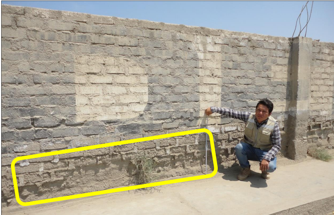
Imagen 4. En esta imagen se observa la evaluación de la patología erosión, de la unidad de muestra 14 con un área de 3.32 m 2 .
