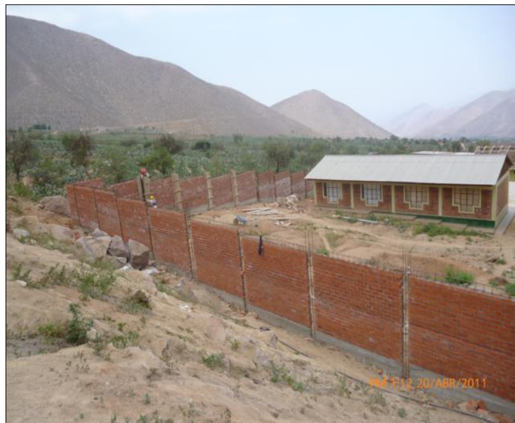
Imagen 24. Cerco perimétrico, Olleros – Perú. Fuente: municipalidad distrital santo Domingo de los Olleros (2011)
