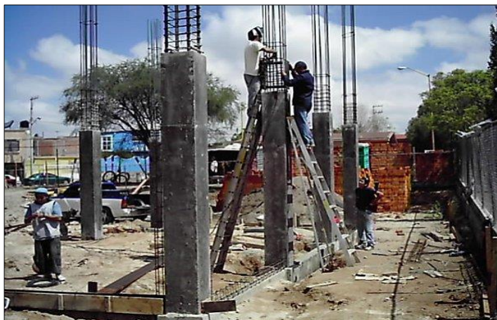
Figura 7. Estribado de una columna de concreto armado, Trujillo – Perú. Fuente: Grupo Andino (2012).
