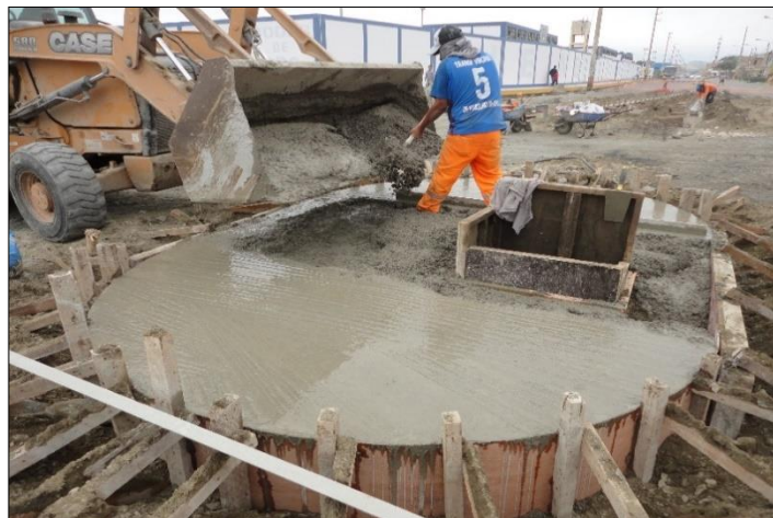
Figura 15. Vaciado de concreto en estado fresco. Fuente: Consorcio la Victoria (2018).
