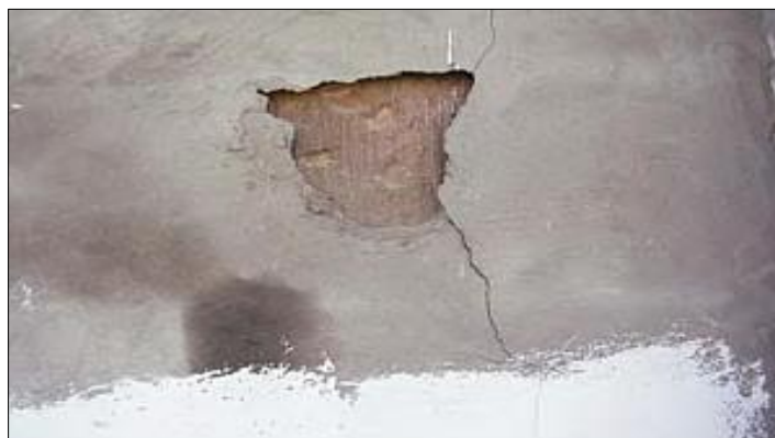
Figura 20. Desprendimiento del tarrajeo en el muro de albañilería. Fuente: Investigación propia (2019).
