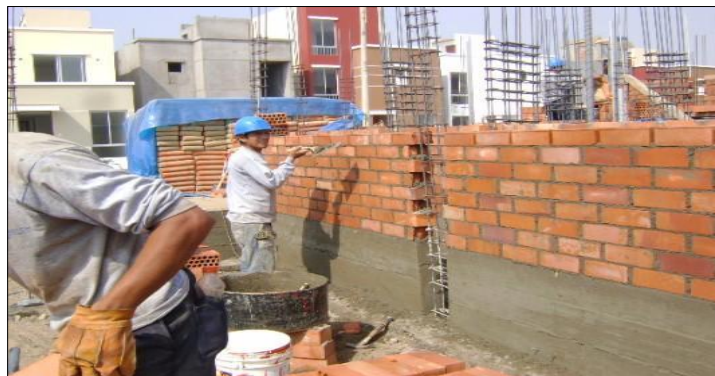
Figura 4. Construcción de una vivienda de albañilería. Lima – Perú. Fuente: ICIC (2018).
