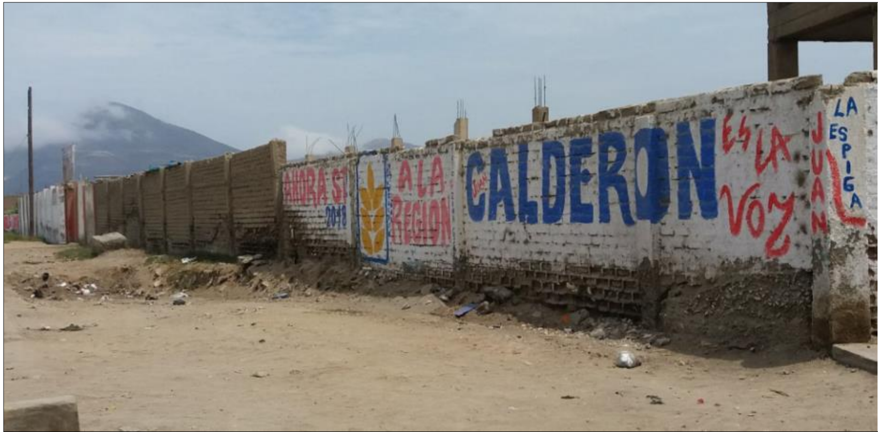
Imagen 2: En esta vista se visualiza el tramo 1 – 2 del cerco perimétrico de la ferretería Faroni en el pueblo joven Dos de Mayo distrito de Chimbote, provincia del Santa, región Áncash.
