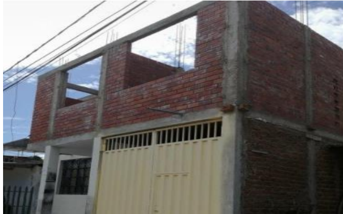
Gráfico 5: Edificación construida mediante sistema de albañilería confinada
