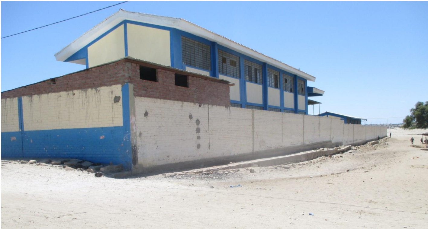
Gráfico 114: Vista panorámica del Cerco Perimétrico de la Institución Educativa 15102 Francisco Bolognesi Ubicada en la Manzana 21 Lote 6 del centro poblado El Tabanco, distrito de El Tallán, provincia Piura, región Piura.
