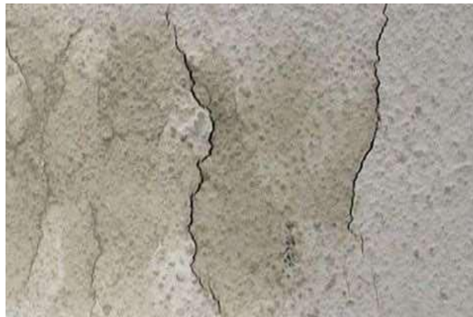
Gráfico 15: Fisuras verticales.
