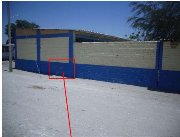
Grafico 131: Unidad de Muestra 1 – paño 2 descascaramientos
