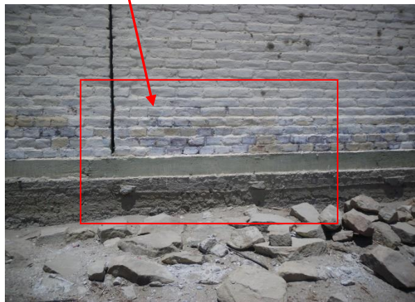
Gráfico 135: Unidad de Muestra 12 Paño 1 Eflorescencia en muro
