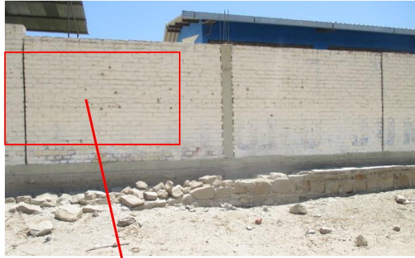
Gráfico 135: Unidad de Muestra 12 Paño 1 Eflorescencia en muro
