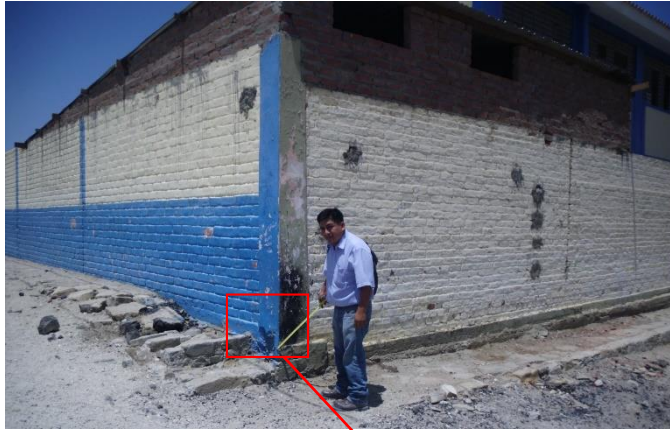
Grafico 132: Unidad de Muestra 2 – Tramo 1-2 – Erosión
