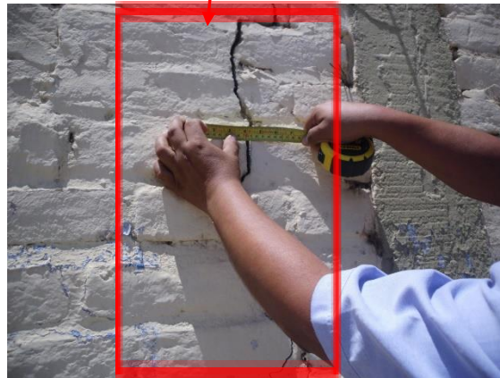
Gráfico 134: Unidad de Muestra 15 – Paño 1 – Grieta en muros
