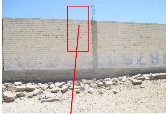
Gráfico 134: Unidad de Muestra 15 – Paño 1 – Grieta en muros
