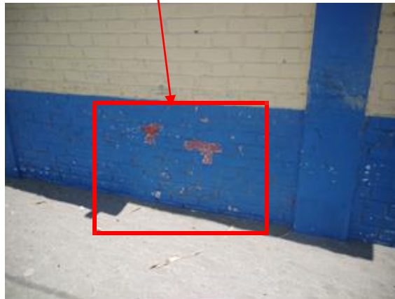
Grafico 131: Unidad de Muestra 1 – paño 2 descascaramientos
