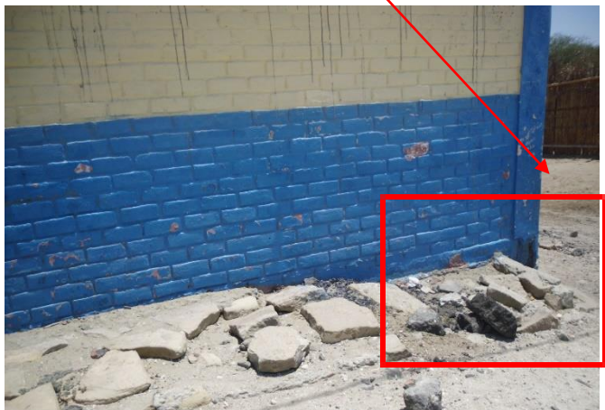
Grafico 132: Unidad de Muestra 2 – Tramo 1-2 – Erosión
