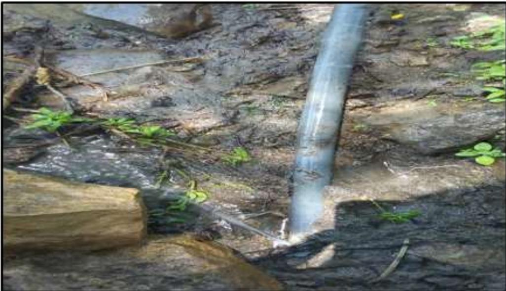
**Ilustración 38.** Estado actual red de distribución, (fuga de agua en tubería de red de distribución).
