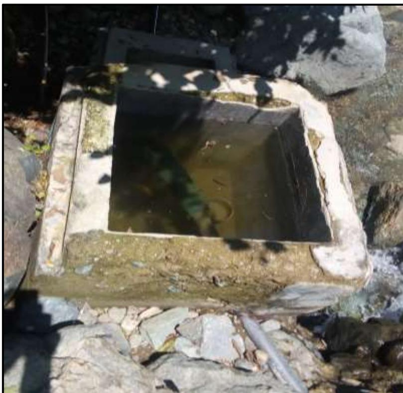
**Ilustración 35.** Estado actual de la caja de captación del sistema de agua
