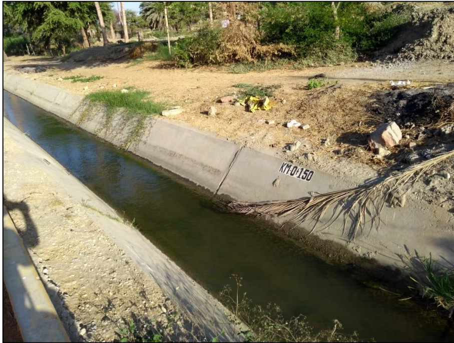
Gráfico 3: Canal de concreto Piedra del Toro Km 0+150.
