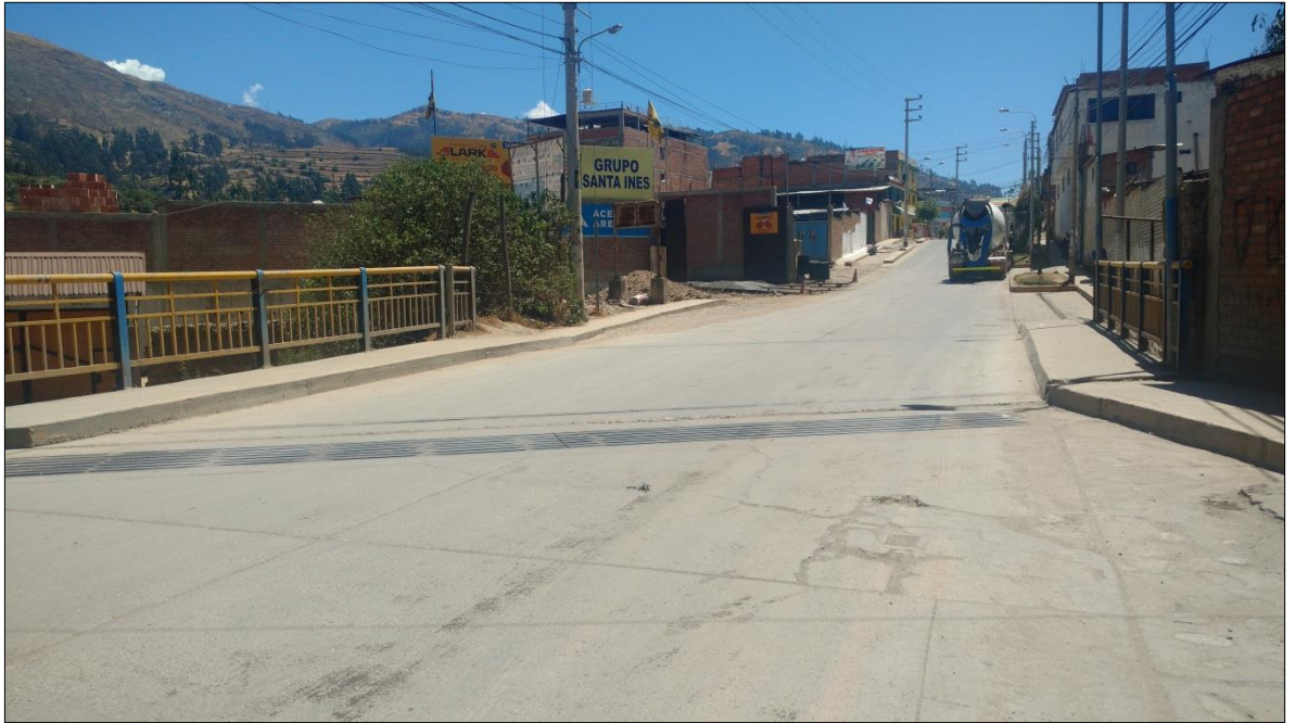
Fig. 14. Plataforma del puente primavera
