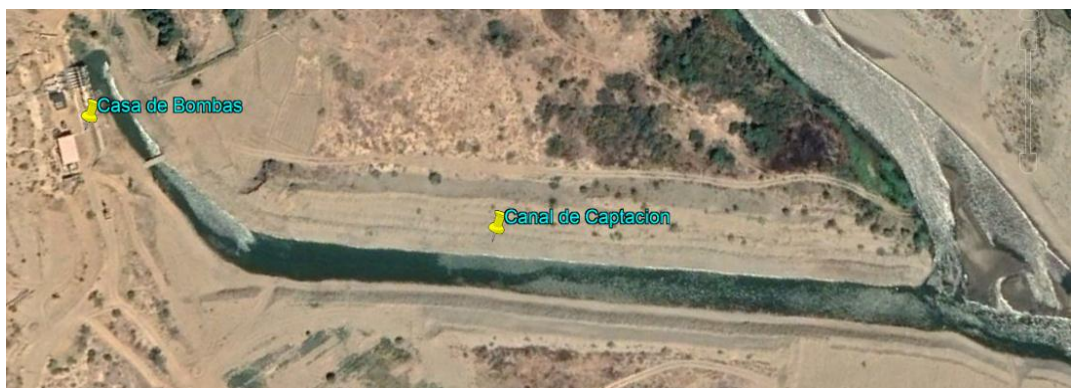
Gráfico 13: Captación Existente de Agua El Arenal
