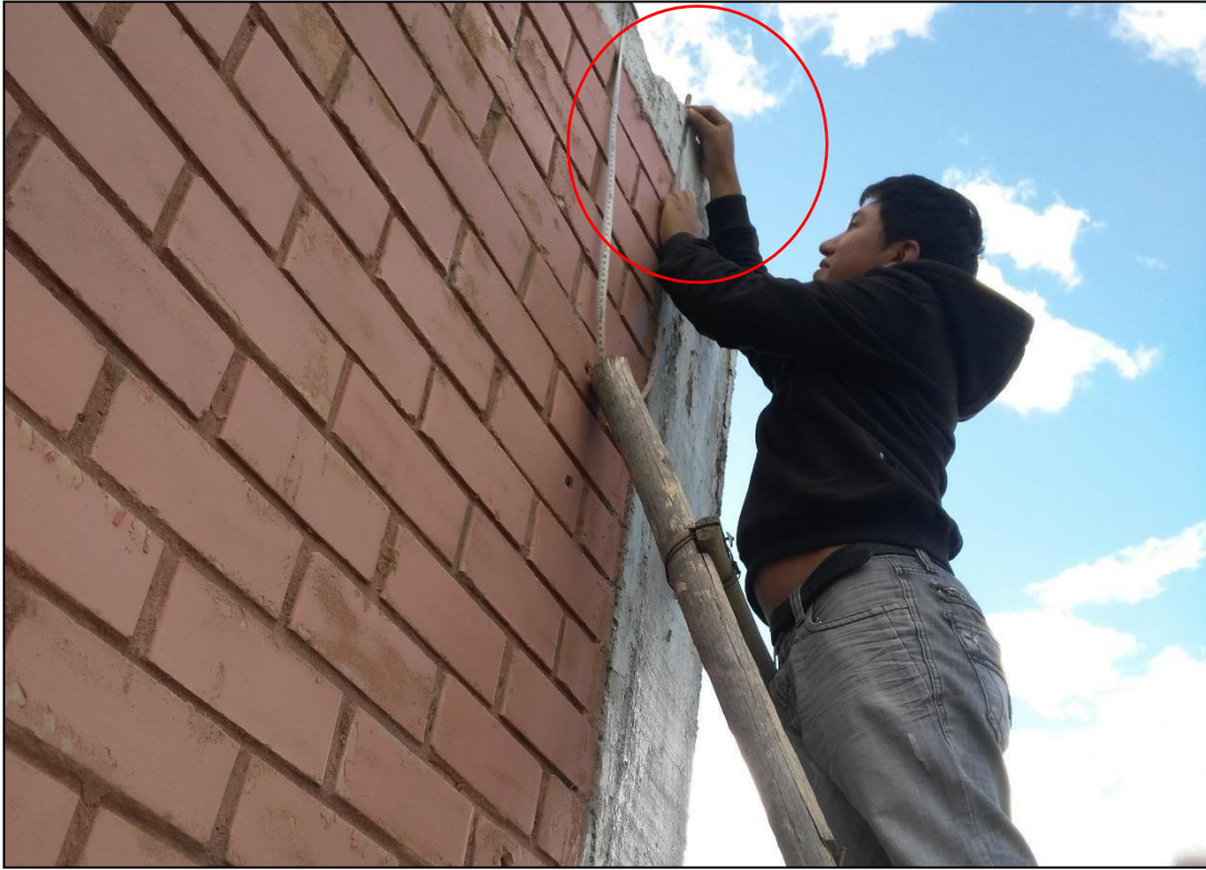
Fotografía 19: Realizando medida de la viga en la unidad de muestra 7.
