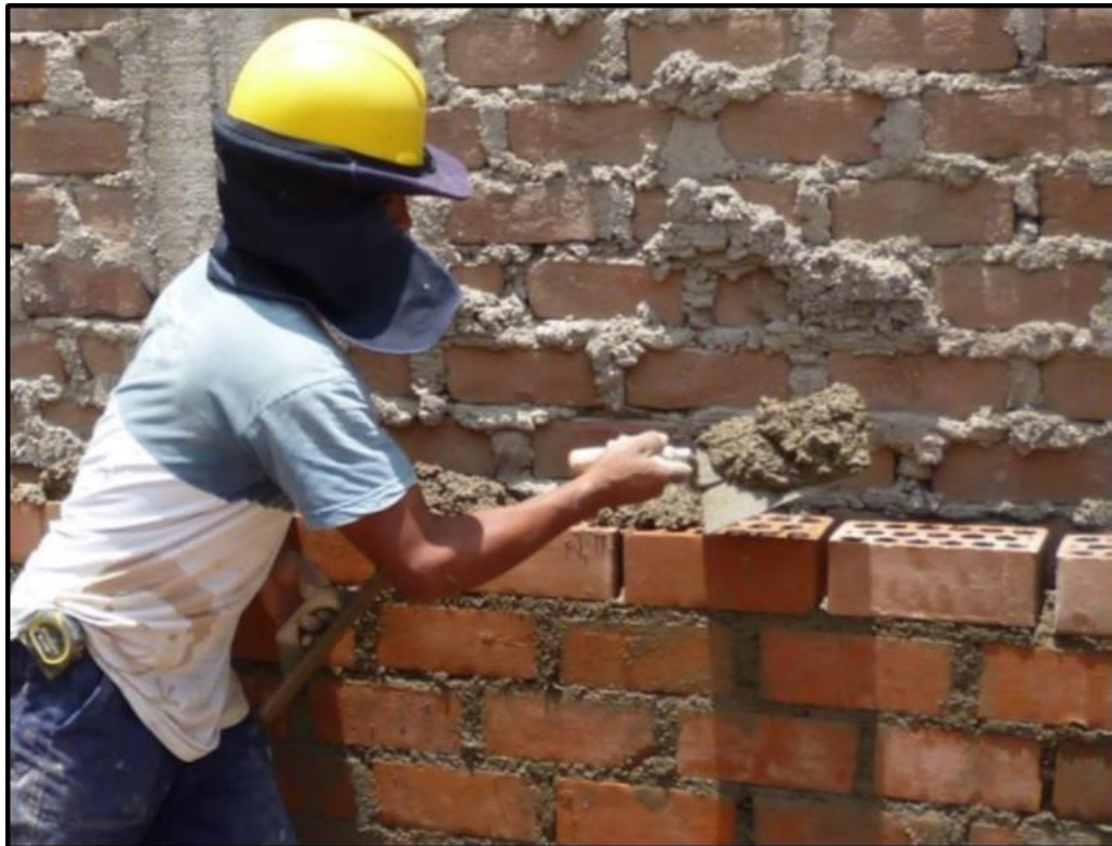
Figura 6. Albañil realizando la colocación del mortero para la colocación del ladrillo de un muro de albañilería.
