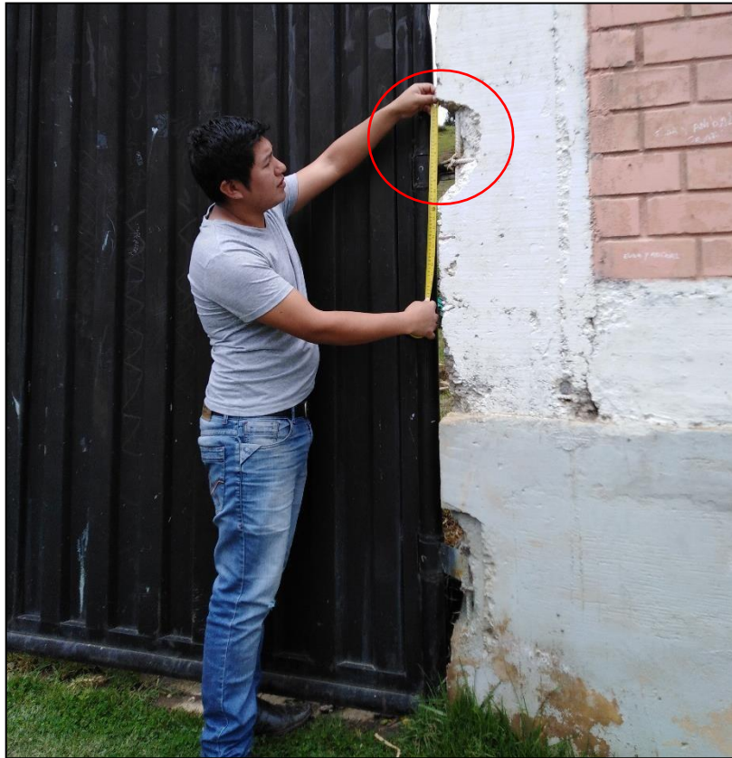
Fotografía 21: Midiendo la erosión mecánica en la unidad de muestra 6.
