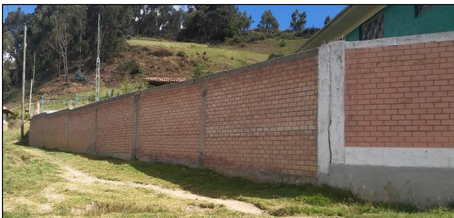
Figura 2. Fotografía del cerco perimétrico de albañilería confinada de la I.E 84181 José María Arguedas.
