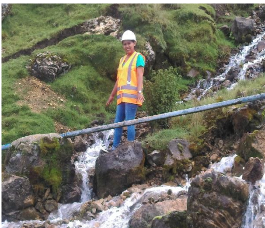
Foto 9. Imagen de la tubería PVC de la línea de conducción, expuesta a la intemperie.
