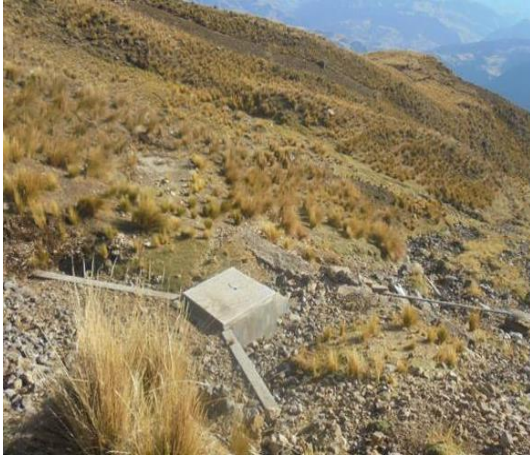
Foto 7. Captación Savilpata, en desuso debido a que no hay agua, todo el año.
