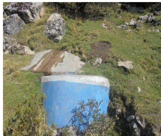
Foto 6. Captación Huiscaranra, en desuso, el ojo de agua se ha movido.
