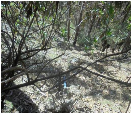
Foto 8. Imagen del deterioro de la línea de conducción.
