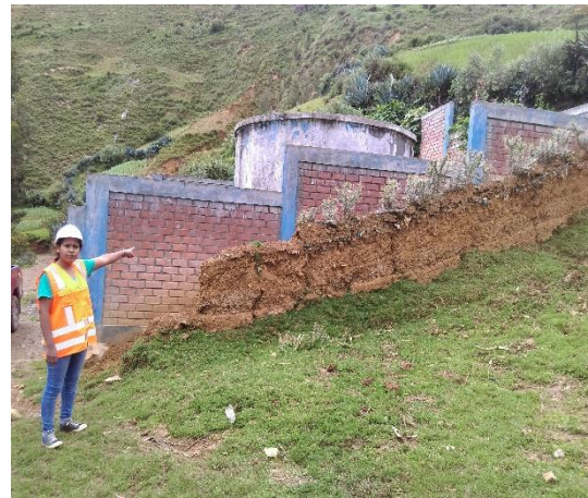
Foto 12. Vista del reservorio y cerco perimétrico.
