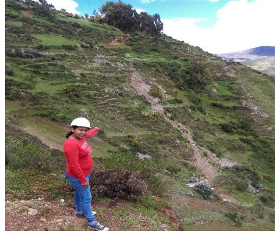
Foto 29. Vista del área por donde descende la red de alcantarillado emisor.
