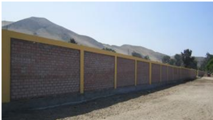
Figura 07: imagen de cerco perimétrico.
