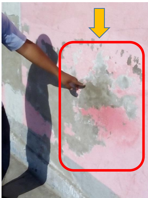
Figura 17: Se aprecia la patología de DELAMINACION en la unidad de muestra 04, afectando el elemento de sobrecimiento.
