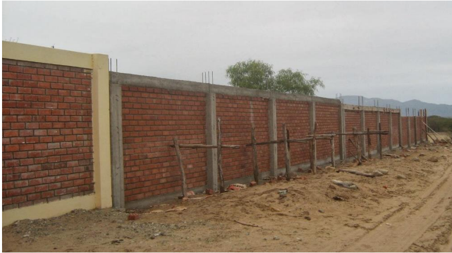
Figura 02: imagen de albañilería confinada de un cerco perimetrico
