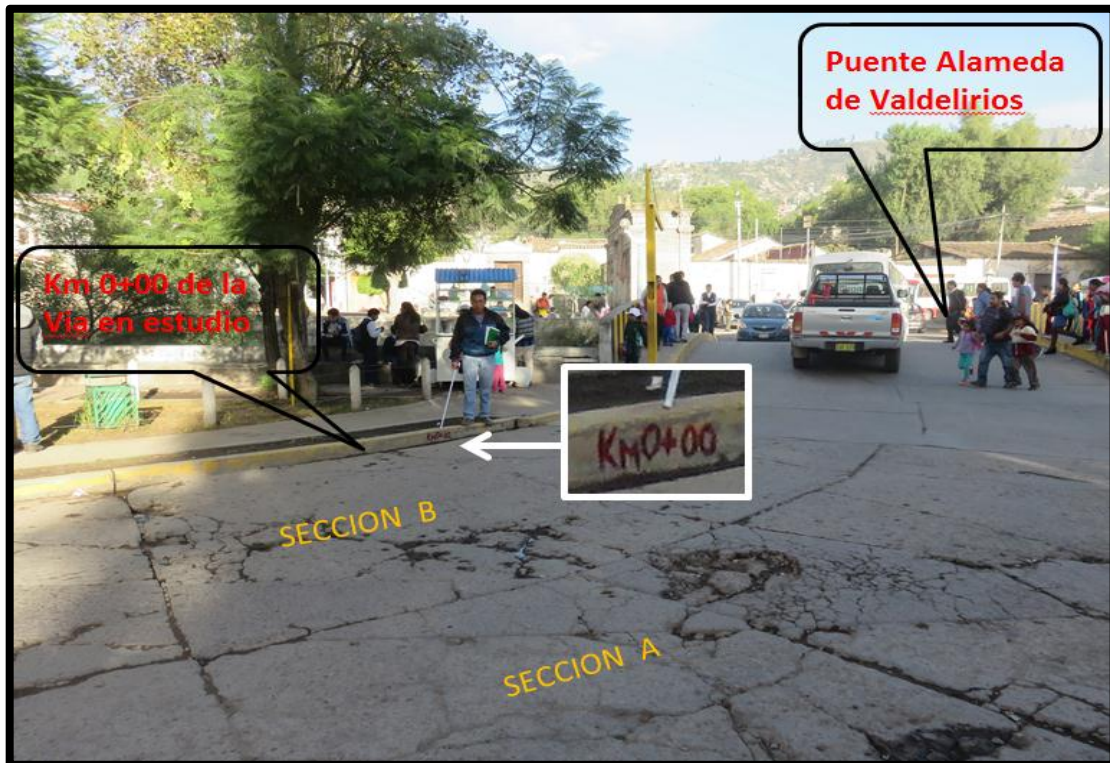
Vista fotográfica del punto de inicio de la vía en estudio
