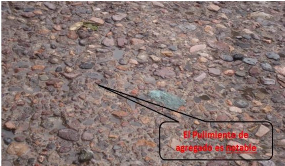
Identificación de pulimiento de agregado notable
