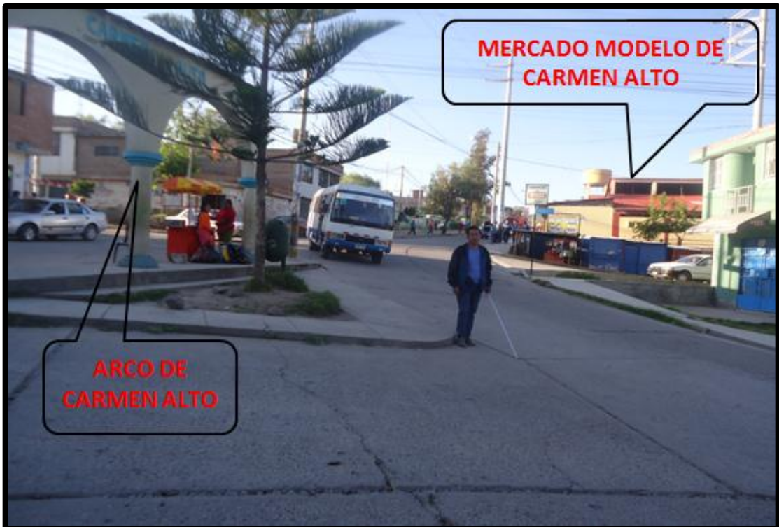
Vista panorámica del Arco de Carmen Alto fin del tramo de la vía en estudio
