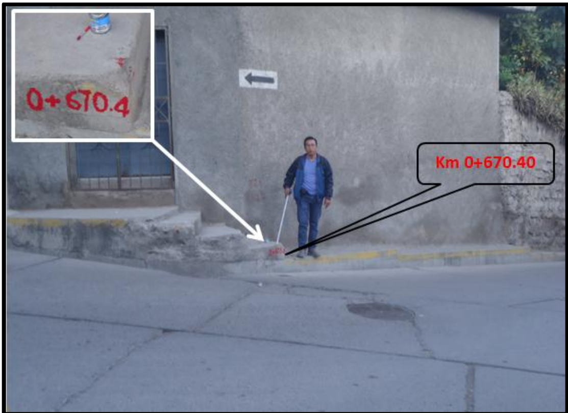
Vista fotográfica del Km. 0+670.40 fin de la Av. Carmen Alto cuadra N° 1 y Inicio de la Av. Perú cuadra N° 1
