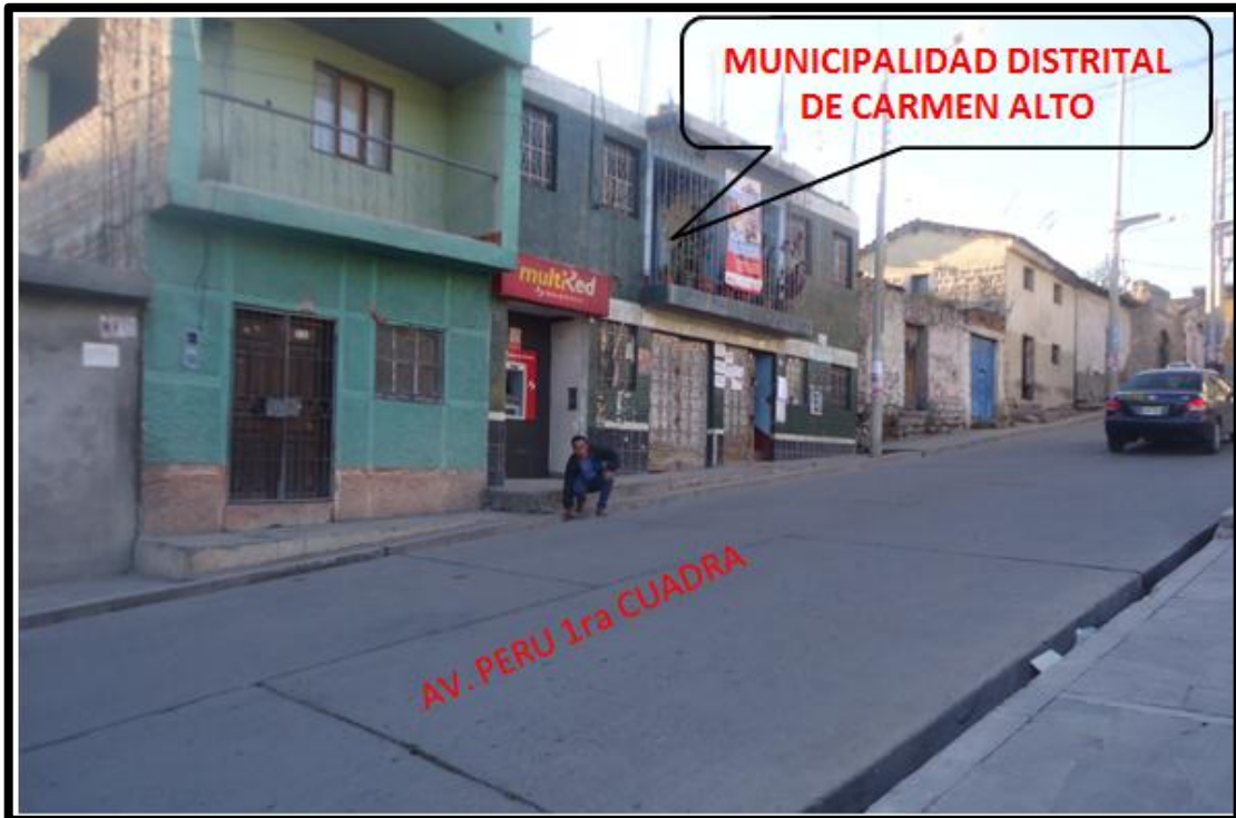
Vista panorámica calle Av. Perú, se muestra el local de la Municipalidad Distrital de Carmen Alto
