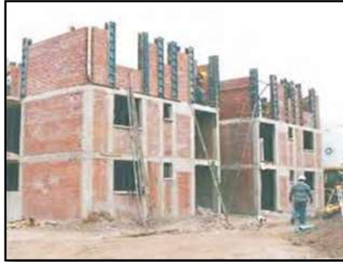
Figura 08. Proceso constructivo de muros portantes de albañilería confinada.
