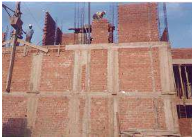
Figura 01. Detalle de una estructura de albañilería confinada.
