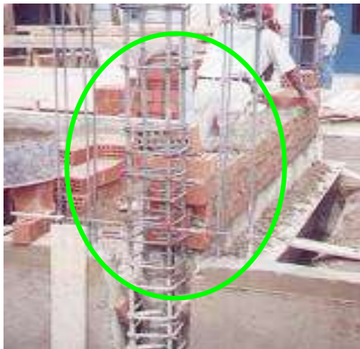
Figura 04. Proceso constructivo del acero para columnas de confinamiento.
