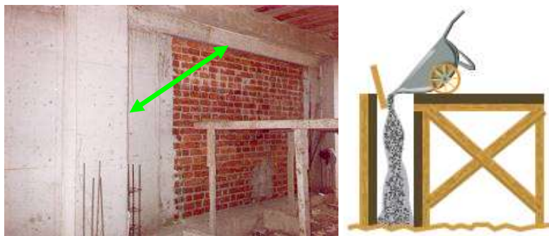
Figura 05. Detalle de la colocación del concreto en edificación.
