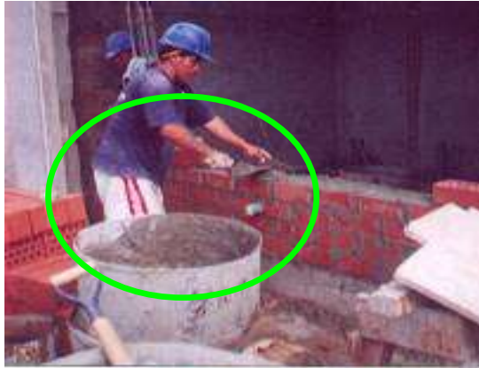
Figura 03. Detalle de la colocación de mortero en muros.
