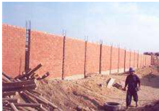
Figura 09. Proceso constructivo de muro no portante de albañilería confinada.
