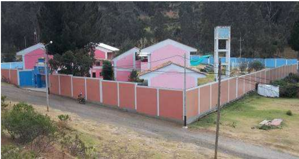
Fotografía 02 Vista panorámica del cerco perimétrico de la institución educativa san pedro de Corongo.
