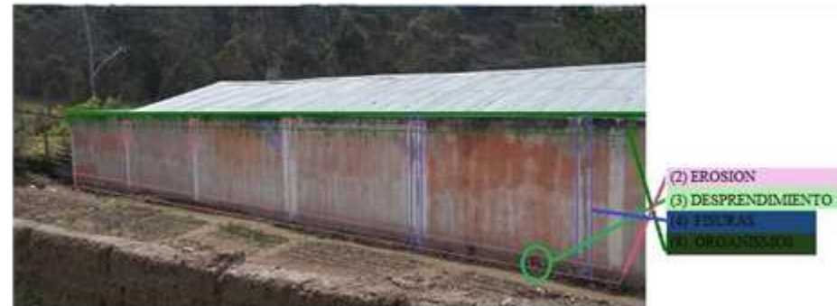
FOTOGRAFIA DE LAS PATOLOGIAS EN LOS EJES
