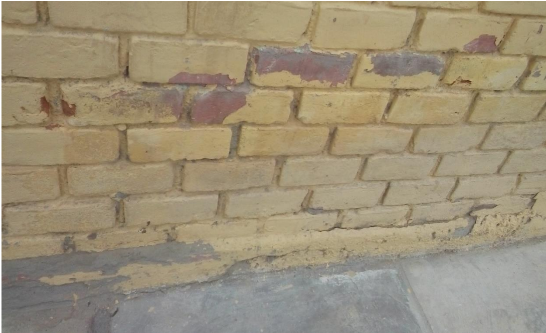
Imagen 28: Reparación de Humedad
