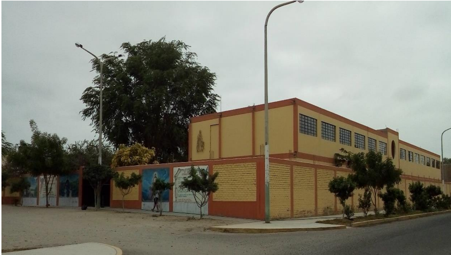
Imagen 11: Foto panorámica del cerco perimétrico de la Institución Educativa.
