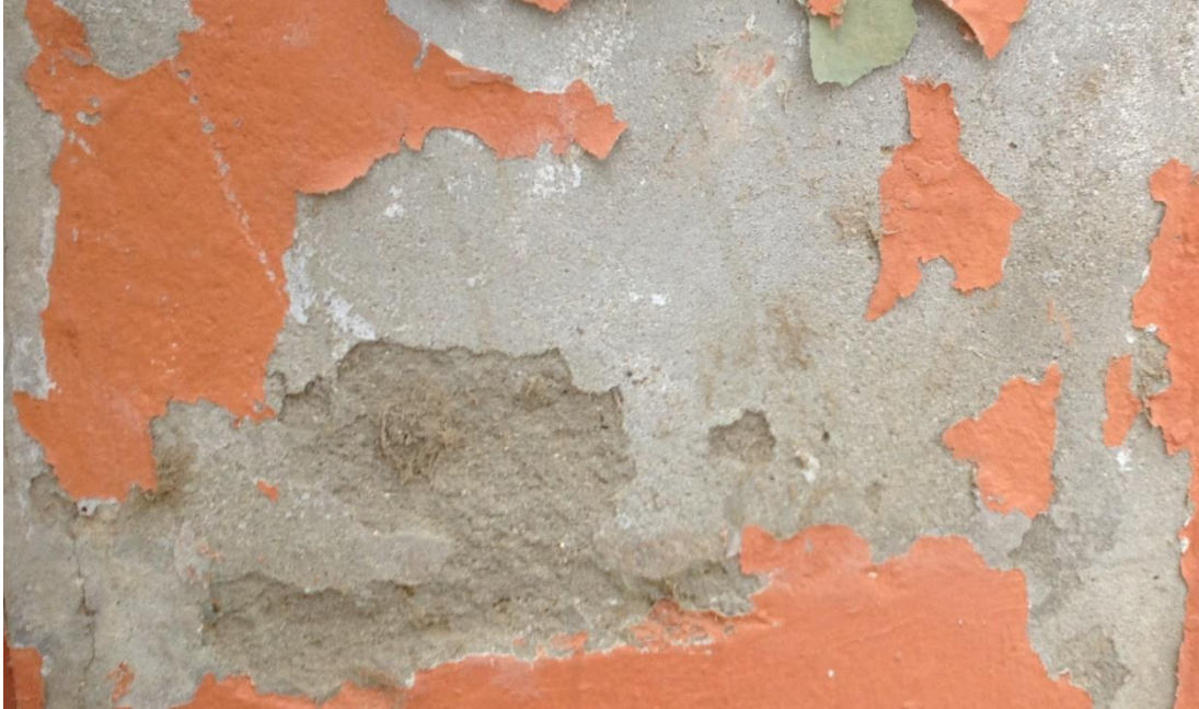
Imagen 26: Reparación de Erosión
