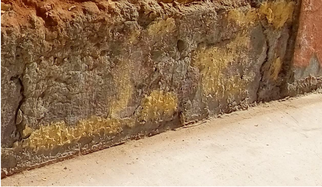
Imagen 25: Reparación de Desprendimientos
