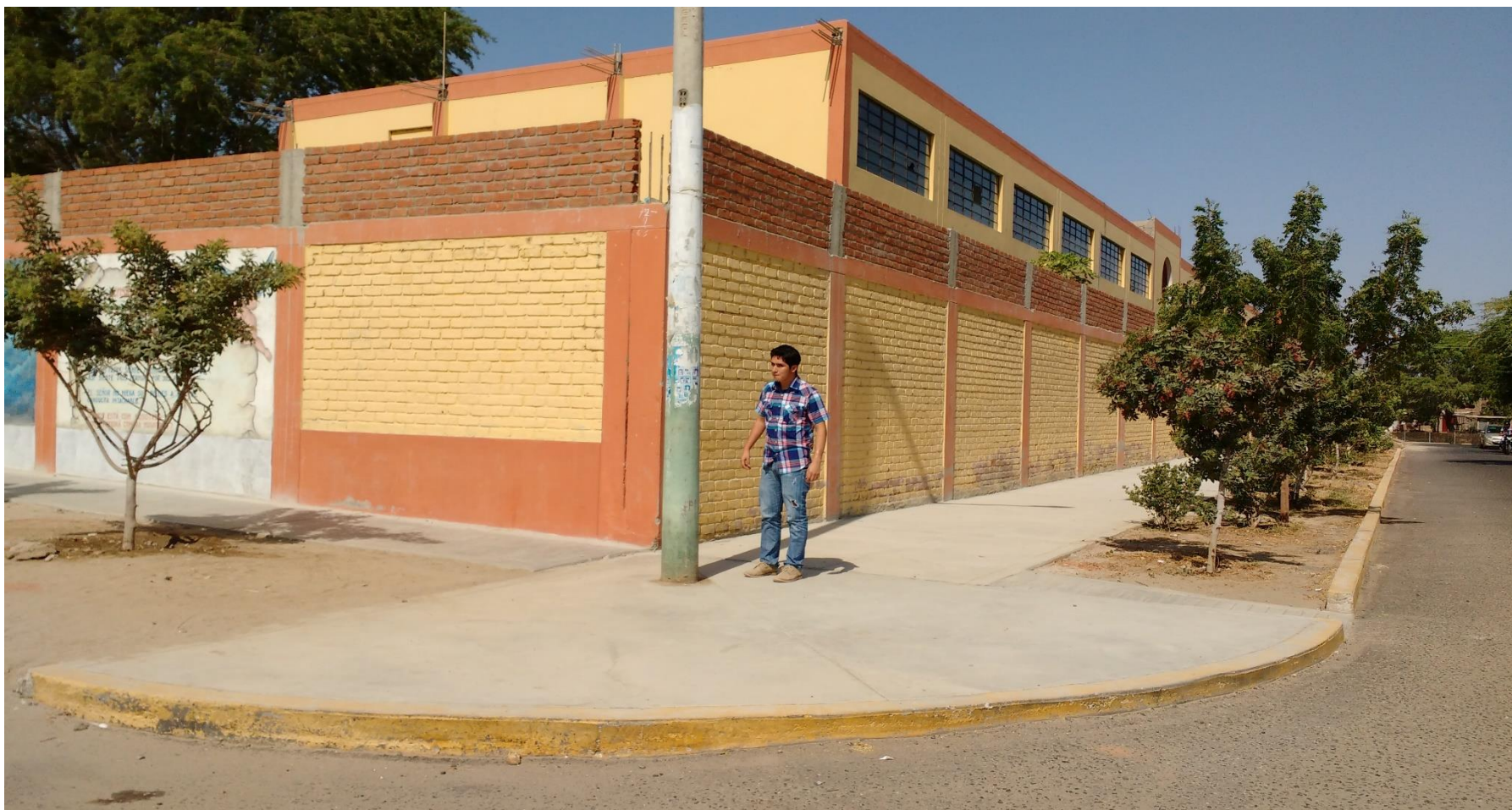
Imagen 12: Foto panorámica del cerco perimétrico de la Institución Educativa.
