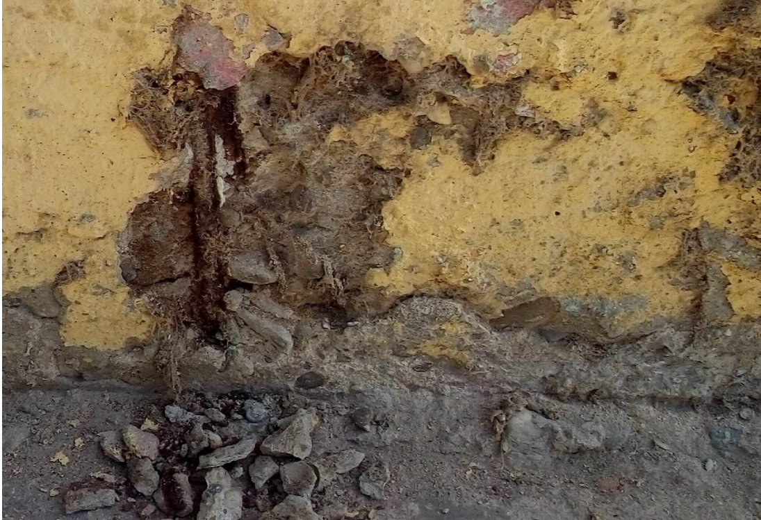
Imagen 24: Reparación de Corrosión.
