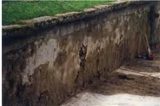
Imagen N°1: Ataque químico por sulfatos.
