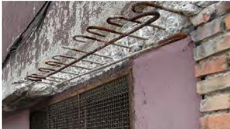
Imagen N°3: Ataque por Ácidos a estructuras de C°A°.
