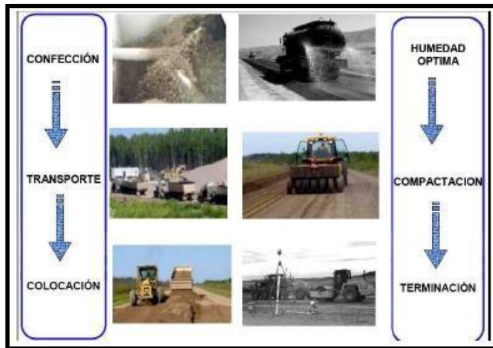
Fotografía N° 2.2: Etapas para la preparación de la base
