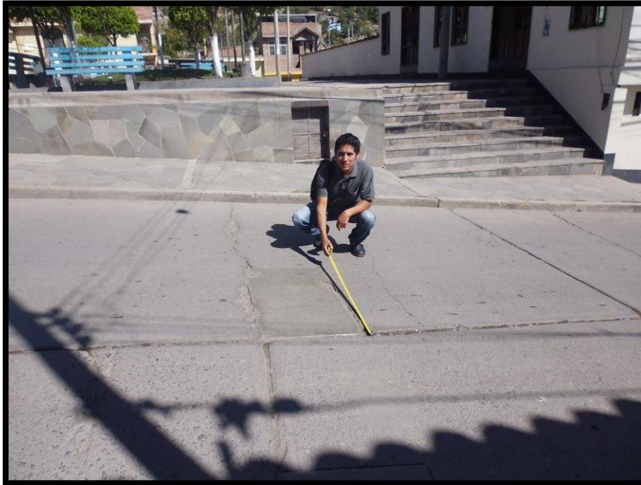
Fotografía A.15: se observa la existencia de parche pequeño con un grado de severidad Baja en la Avenida Perú (primera cuadra) del distrito de Carmen Alto, provincia de Huamanga, departamento de Ayacucho.
