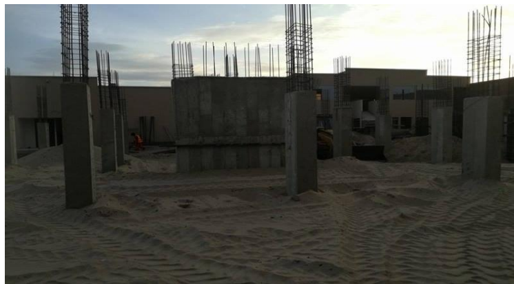
Gráfico 6: Estructuras de concreto armado.
