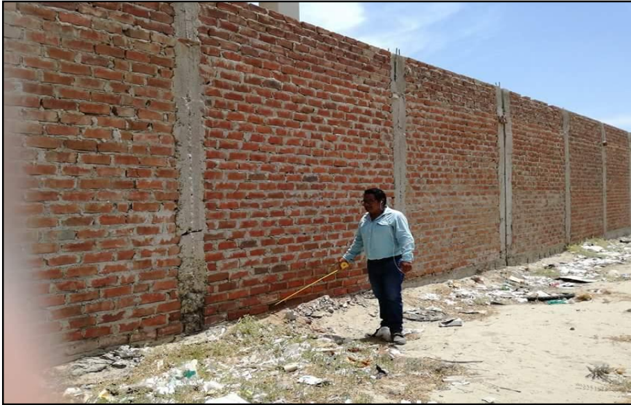
Gráfico 153: Presencia de humedad en el paño comprendido entre los ejes 97 y 98 perteneciente a la unidad de muestra 26.
