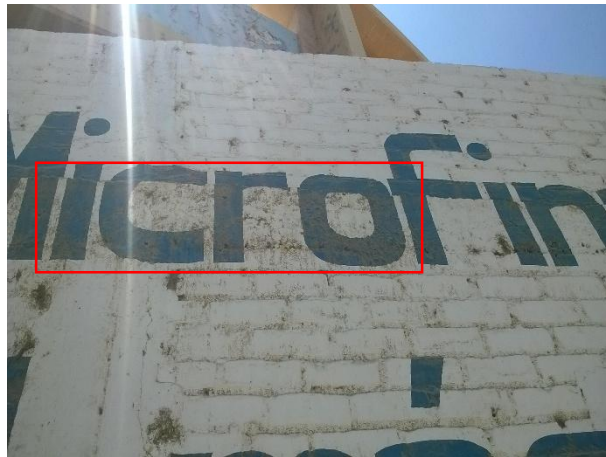
Figura 06. Daño por picadura o cavitación en viga
