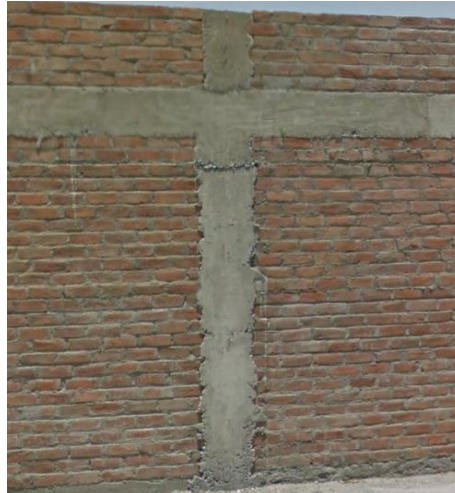
Figura 03. Columna y viga de concreto
