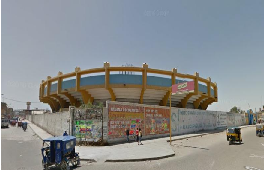
Foto 01: Vista panorámica del Estadio campeonos del 36 de Sullana.
