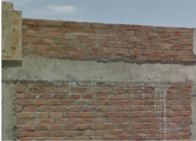
Figura 04. Viga de concreto armado
