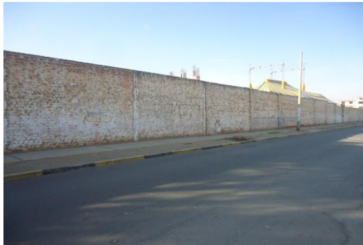
Figura 01. Muros de ladrillo en cerco perimétrico.
