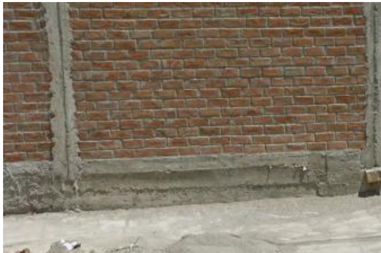
Figura 02. Sobrecimiento de concreto
