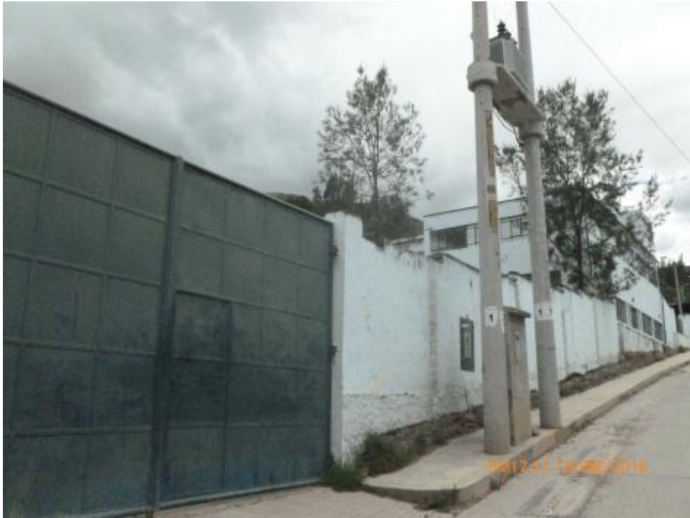
Imagen 16: Vista Panorámica de la Planta de Tratamiento de Agua Potable
