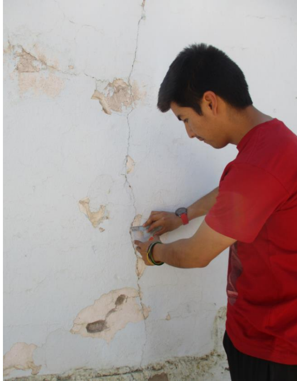
Imagen 20: Patología de fisura en muro
