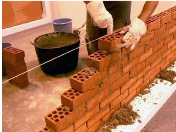
Imagen 03. Albañilería o mampostería
