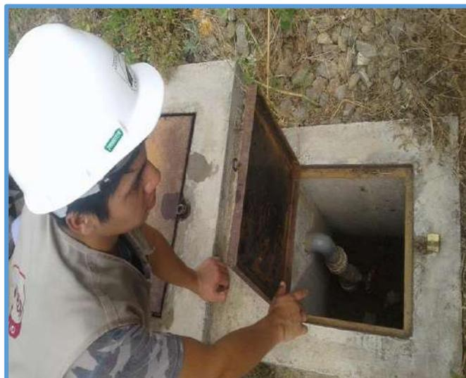
Fotografía 6: En esta fotografía se puede apreciar la cámara rompe- presión, que se encuentra en mal estado, como se puede visualizar la tapa metálica se encuentra en un estado oxidación, también en la válvula compuerta también se presentó fuga de agua, esto se da por falta de mantenimiento y limpieza.
