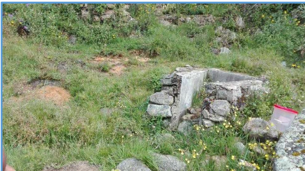
Fotografía 5: En esta fotografía se puede apreciar la cámara de captación que se encuentra en mal estado, también se puede visualizar que no cuenta con un cerco perimétrico, siendo una construcción artesanal y actualmente se encuentra en función.
