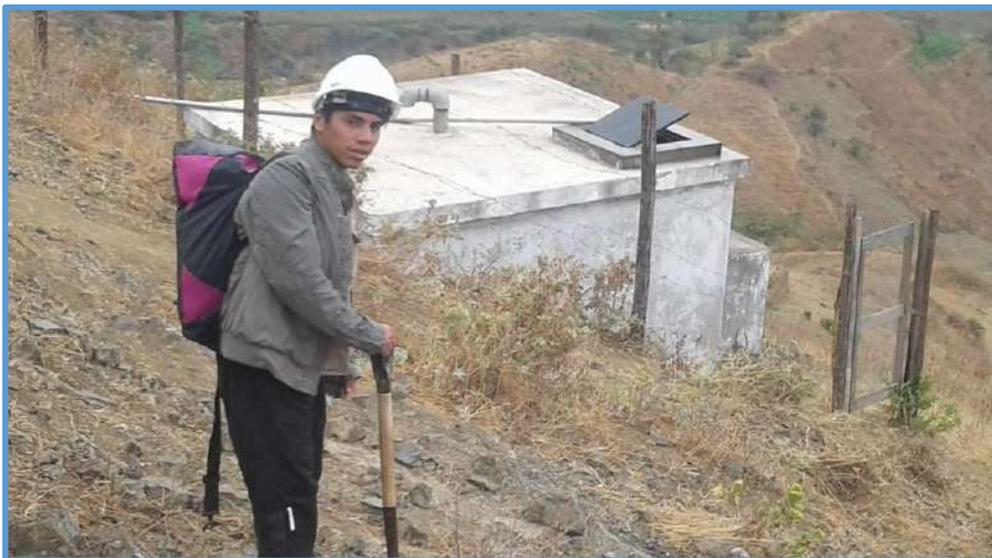
Fotografía 8: En esta fotografía se puede apreciar el reservorio de almacenamiento, se encuentra en mal estado, esto se da por falta de mantenimiento y limpieza.
